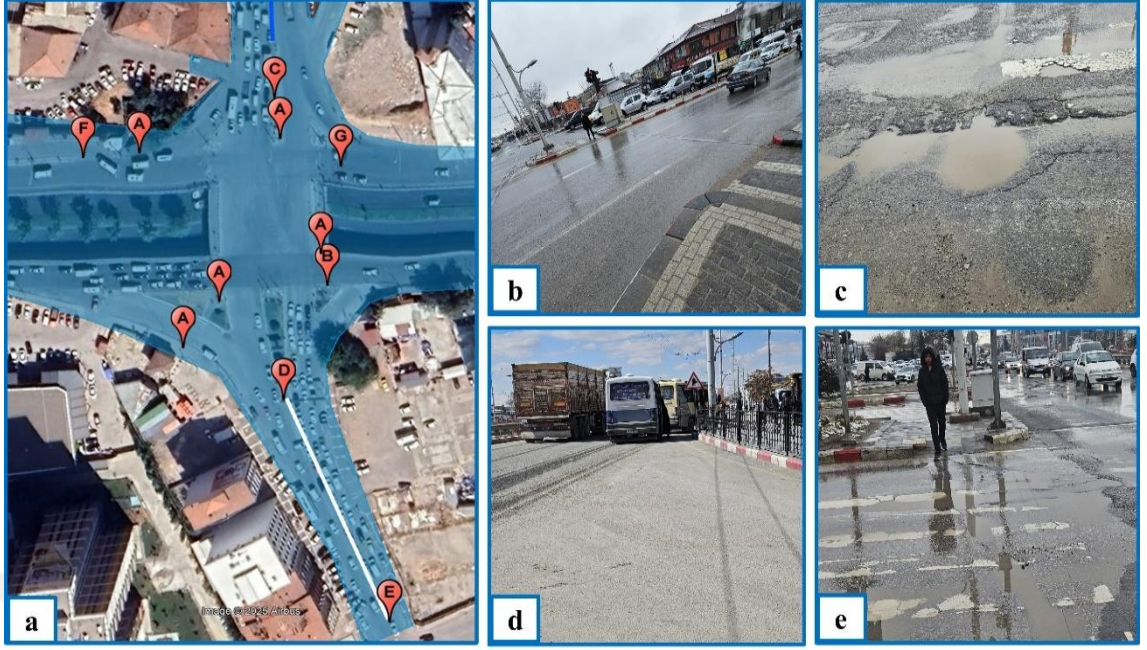
Şekil 3.6. Çalışma alanındaki tespit edilen sorunların fotoğrafları ve konumları
