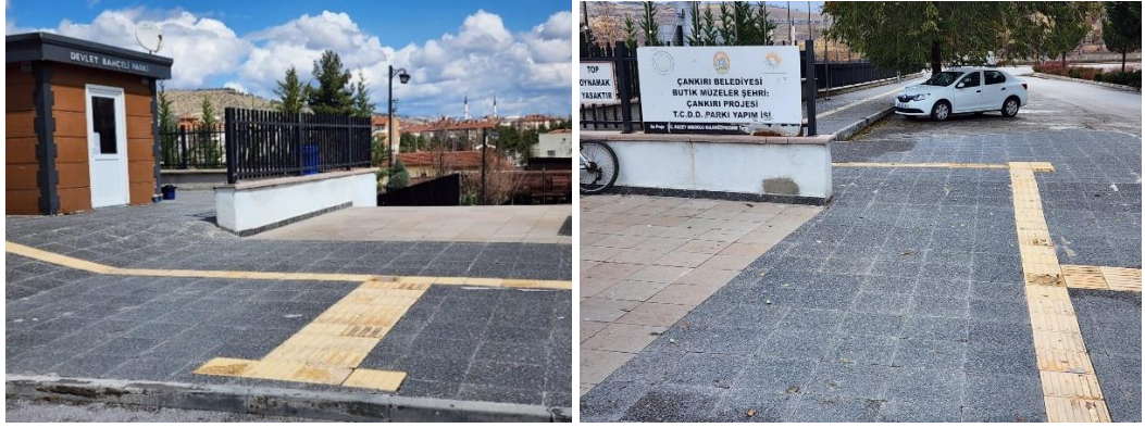
Şekil 5.8 Görme engelliler için sadece girişte bulunan hissedilebilir yüzeyler
