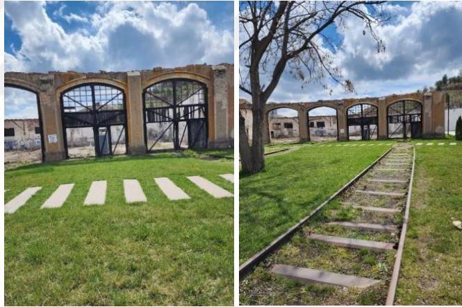
Şekil 5.20 Cer atölyesinin kalıntıları
