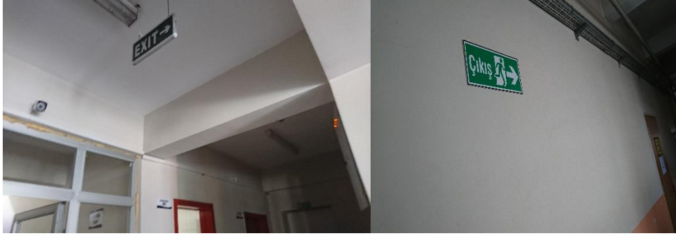
Şekil 4.4. Işıklı yönlendirme levhalarında eksiklik
