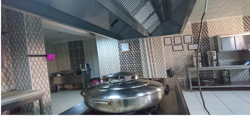
Şekil 4.5. Davlumbazlarda otomatik söndürme sistemi bulunmaması
