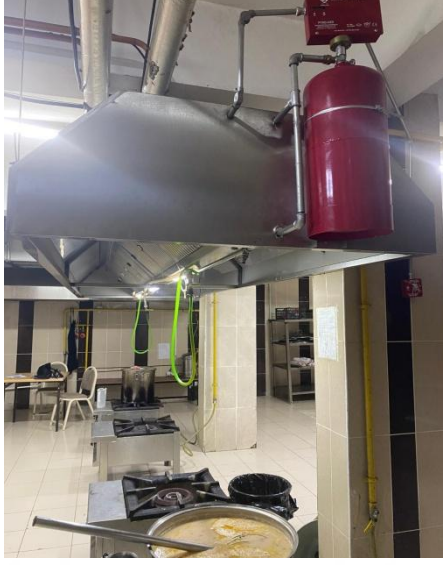
Şekil 4.1. Davlumbazlarda otomatik söndürme sisteminin bulunması (İlgili pansiyon izni ile)
