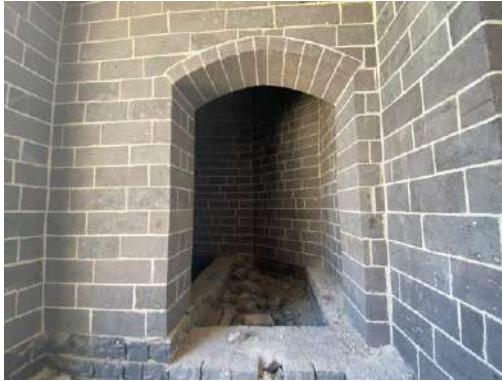
Şekil 6.78 Güney kanat bodrum kata geçişi sağlayan tek açıklıklı kemer
