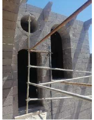
Şekil 6.129 Kuzeydoğu kanat birinci kata geçiş
