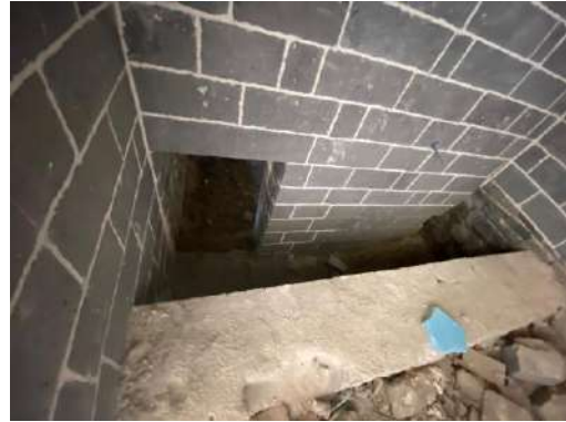
Şekil 6.79 Güney kanat bodrum kata geçişi sağlayan merdiven boşluğu
