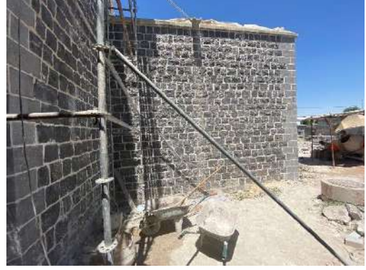
Şekil 6.94 Yapı güney kanat
