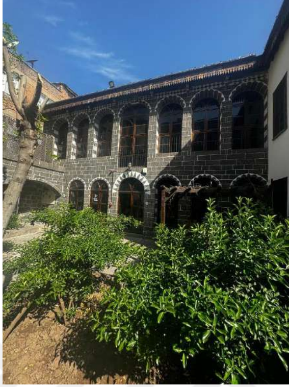
Şekil 6.175 Avlu kuzey kanat
