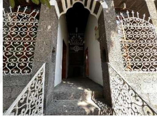
Şekil 6.16 Kuzey kanat 3 dilimli kemer açıklığı
