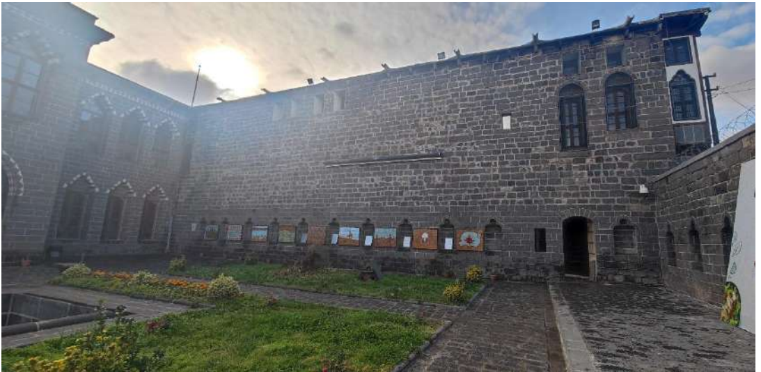
Şekil 6.248 Cemil Paşa Konağı selamlık bölümü-2023
