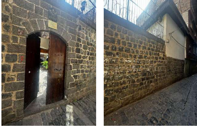
Şekil 6.174 Yapı Sokak cephesi
