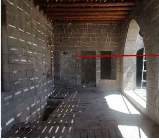
Şekil 6.124 Kuzey kanat birinci kat eyvan genel görünüm
