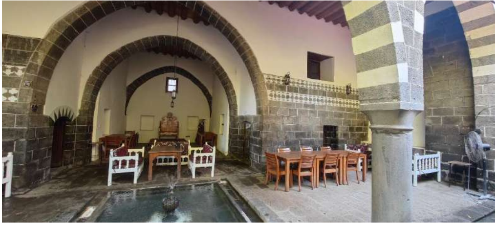
Şekil 6.187 Güney kanat havuzlu eyvan genel görünüm
