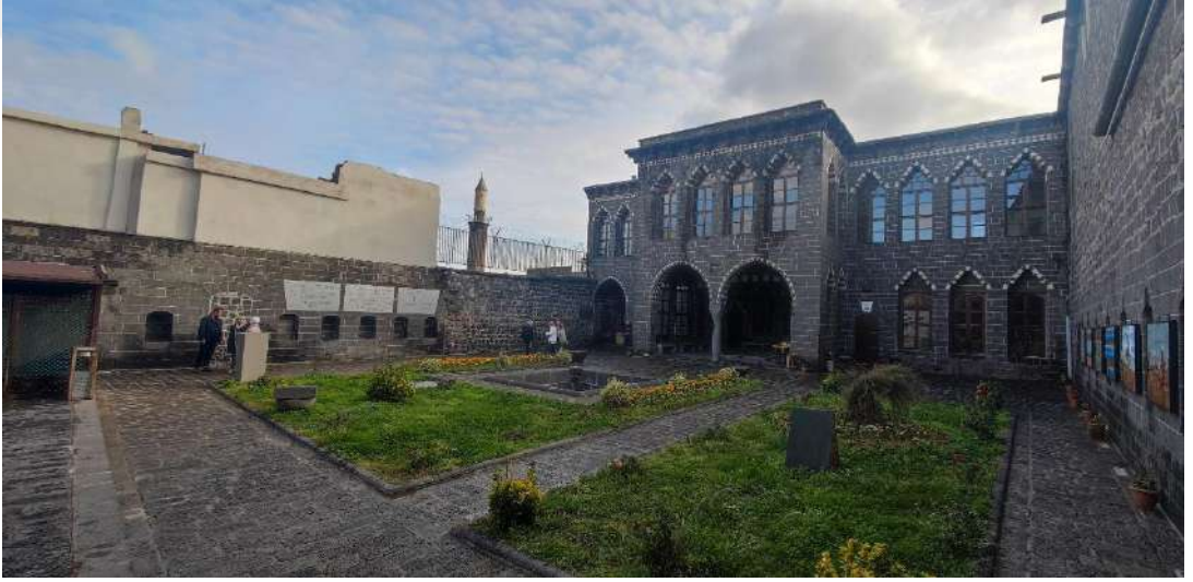
Şekil 6.247 Cemil Paşa Konağı selamlık bölümü-2023
