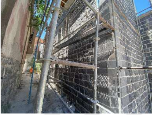
Şekil 6.95 Yapı güney kanat sokak cephesi
