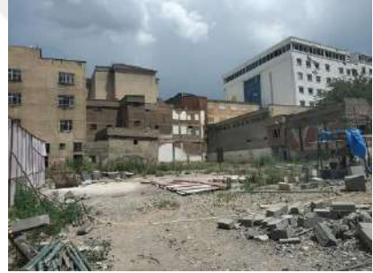
Şekil 6.73 2018 tarihli fotoğraf(REM Mimarlık Ltd.Şti. tarafından yapılan Rölöve raporundan alınmıştır.)
