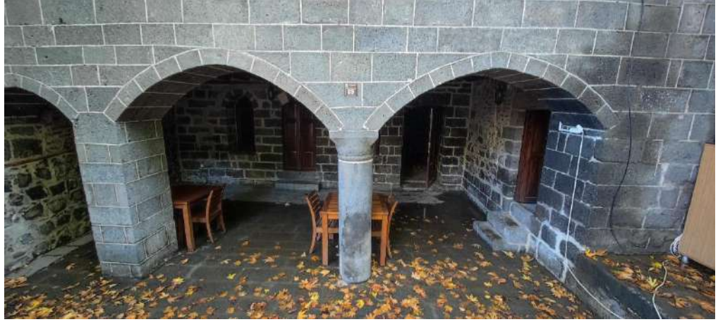
Şekil 6.189 Güney kanat doğu köşede yer alan 3 gözlü eyvan
