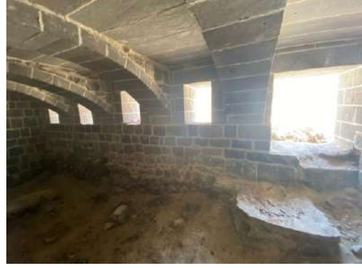
Şekil 6.81 Batı kanat bodrum kat doğu cephesi
