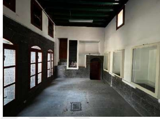
Şekil 6.36 Doğu kanat birinci kat sofanın kuzeyindeki odanın genel görünümü
