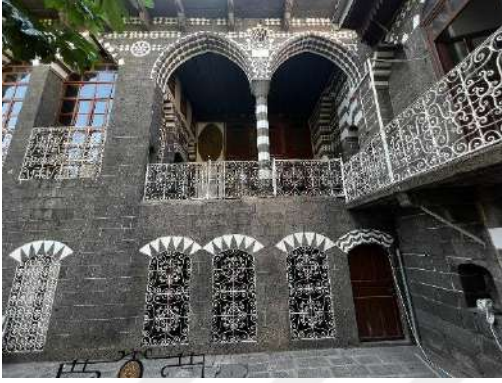
Şekil 6.59 Avlu güney kanadı batı köşesi
