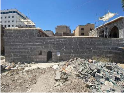
Şekil 6.93 Yapı doğu kanat sokak cephesi
