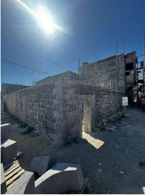
Şekil 6.131 Sokak kuzey cephesi
