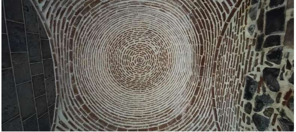
Şekil 6.194 Güney kanat hamam bölümü tuğla malzemedan yapılan kubbe
