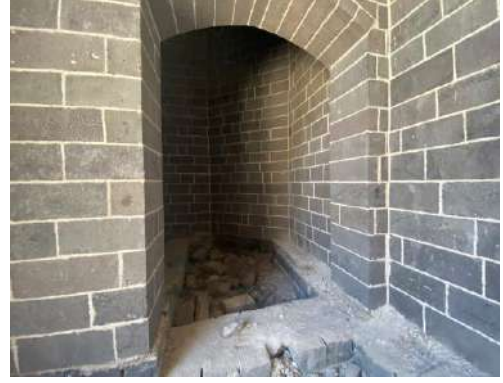
Şekil 6.85 Eyvandan aralığa geçişi sağlayan tek gözlü basık kemerli açıklık
