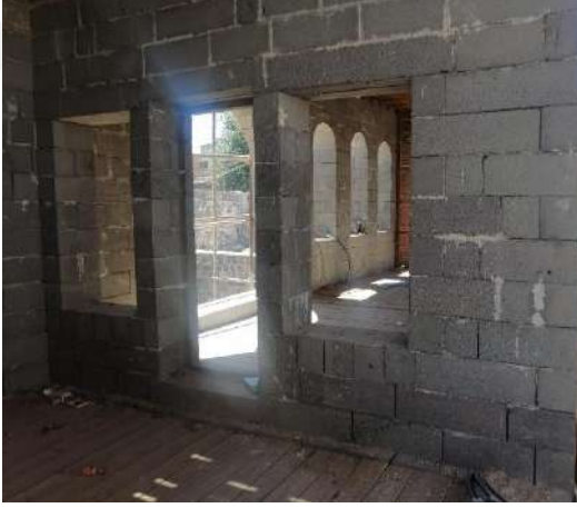
Şekil 6.126 Kuzey kanat birinci kat cumbalı oda batı duvarı
