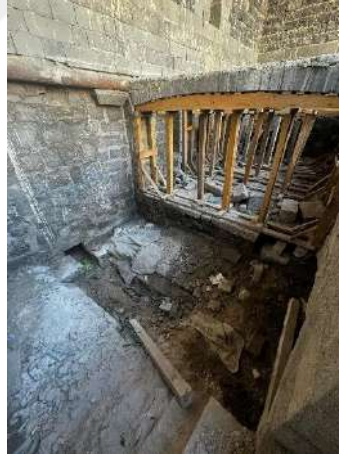
Şekil 6.122 Güney kanat eyvanının altında bulunan serdaplı odanın genel görünümü
