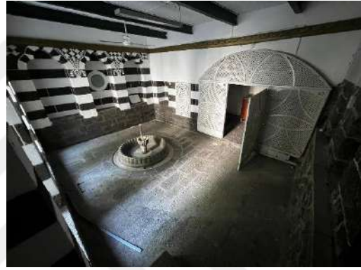
Şekil 6.26 Güney kanat zemin kat serdaplı oda genel görünüm
