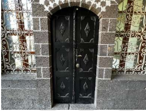
Şekil 6.67 Eyvanın doğusundaki demir malzemeden yapılmış oda kapısı
