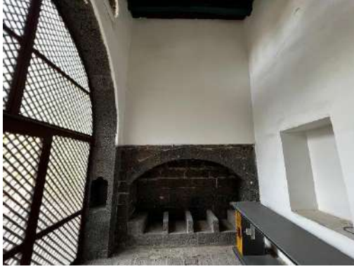
Şekil 6.15 Kuzey kanat mutfak
