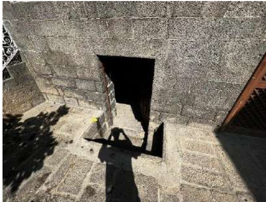
Şekil 6.8 Kuzey kanat bodrum kat girişi
