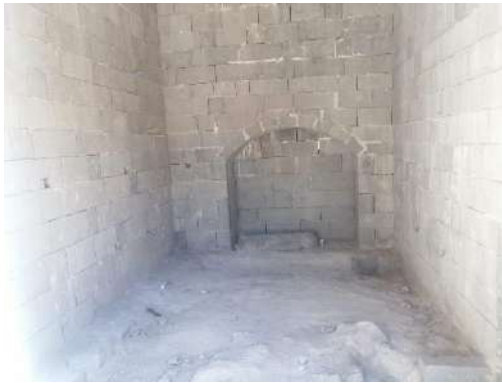
Şekil 6.115 Doğu kanat zemin kat mutfak
