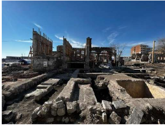
Şekil 6.103 Yapı muhdeslerden arındıktan sonra kazı çalışmaları yapıp çekilen fotoğraf (Kale firmasından alınmıştır.)
