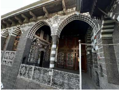
Şekil 6.69 Güney kanat eyvan 2 açıklıklı yüksek basık sivri kemer
