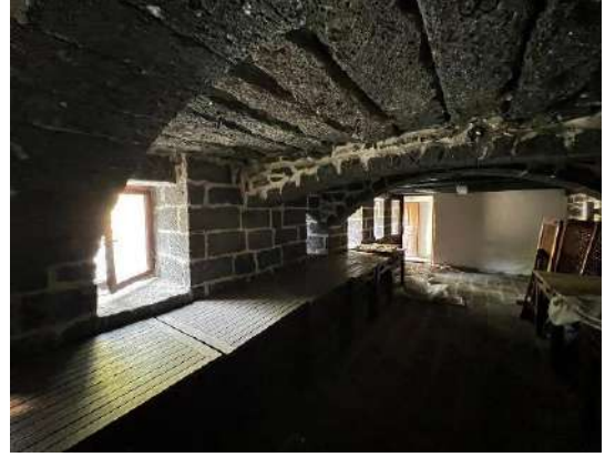
Şekil 6.46 Doğu kanat bodrum kat odası tavandaki sal taşları
