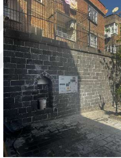
Şekil 6.173 Batı kanatta avlu duvarında bulunan niş
