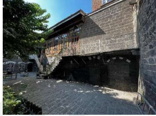
Şekil 6.20 Batı kanat kapatılmış kapı ve pencere boşluğu(selamlıkla irtibatlı)
