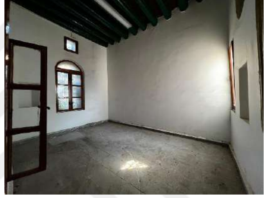
Şekil 6.42 Doğu kanat birinci kat cumba odası genel görünüm
