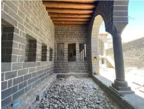
Şekil 6.86 Batı kanat eyvan kuzey duvarı
