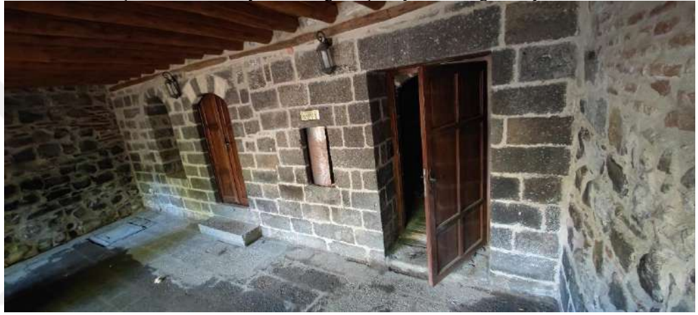
Şekil 6.190 Güney kanat doğu köşede yer alan 3 gözlü eyvan güney duvarı
