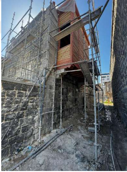
Şekil 6.133 Sokağa bakan cumba
