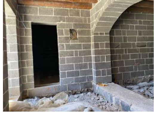
Şekil 6.89 Kuzey kanatta yer alan banyoya geçiş
