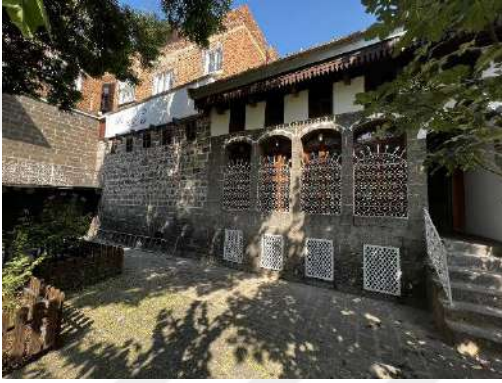
Şekil 6.55 Avlu kuzey kanat
