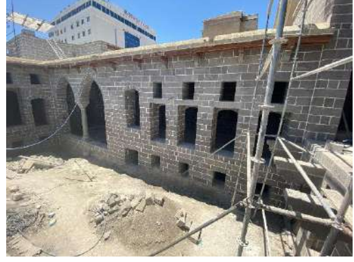
Şekil 6.98 Yapı batı kanat avlu cephesi
