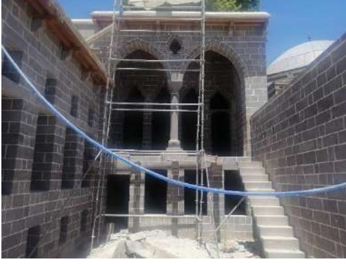
Şekil 6.97 Yapı kuzey kanat avlu cephesi
