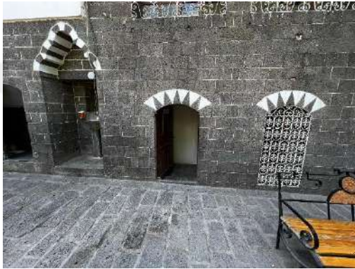
Şekil 6.31 Güney kanat zemin kat doğu köşedeki oda girişi
