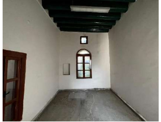
Şekil 6.40 Doğu kanat birinci kat cumba odası kuzey duvarı
