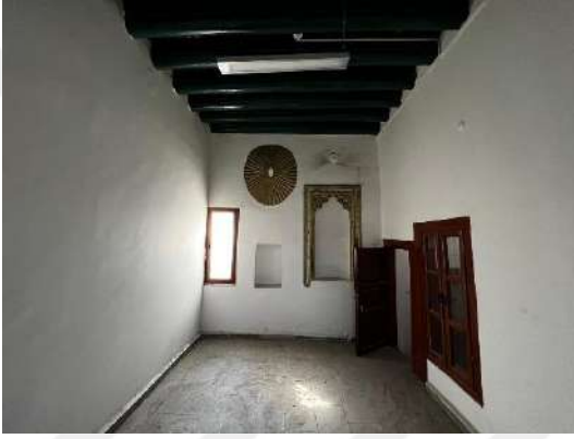
Şekil 6.41 Doğu kanat birinci kat cumba odası güney duvarı sokağa bakan pencere
