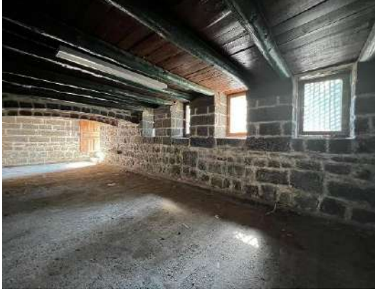
Şekil 6.10 Kuzey kanat bodrum kat pencereleri
