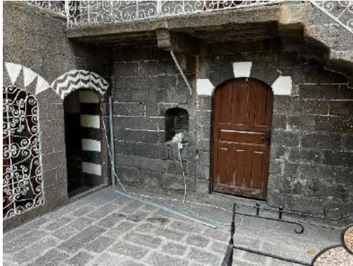
Şekil 6.21 Batı kanat zemin kata giriş kapısı
