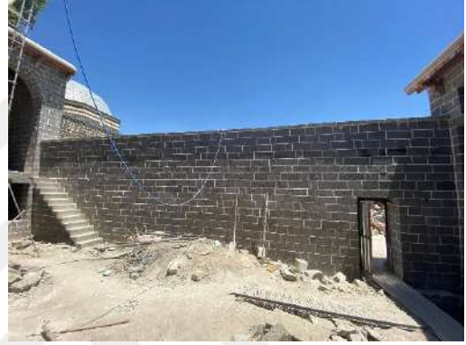
Şekil 6.100 Yapı doğu kanat avlu cephesi
