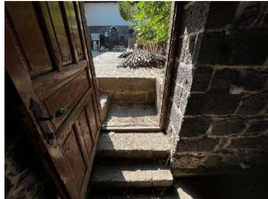
Şekil 6.9 Kuzey kanat bodrum kat merdivenleri
