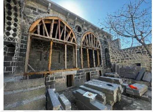
Şekil 6.120 Güney kanat eyvanı 2 gözlü basık sivri kemer formu
