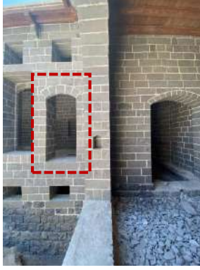
Şekil 6.83 Güney kanat mutfak girişi
