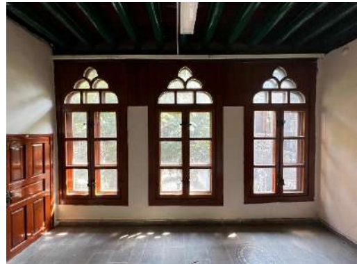
Şekil 6.66 Batı kanat 3 dilimli pencere doğraması
