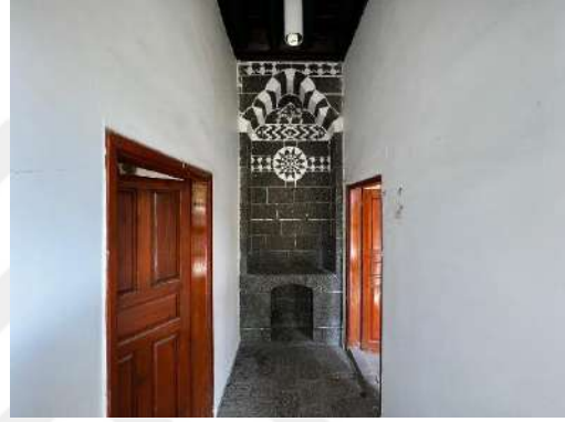
Şekil 6.68 Ahşap tek kanatlı oda kapıları
