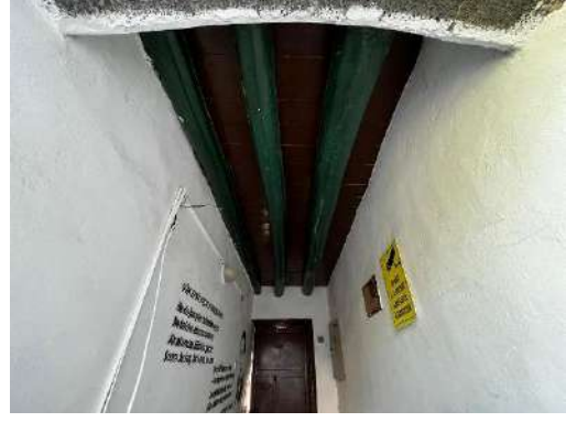
Şekil 6.34 Doğu kanat yapı girişi tavanı
