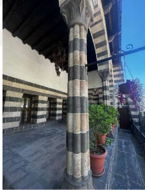
Şekil 6.210 Behram Paşa Konağı eyvan sütunu
