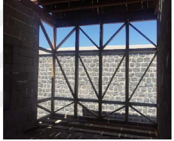
Şekil 6.127 Kuzey kanat birinci kat cumba
