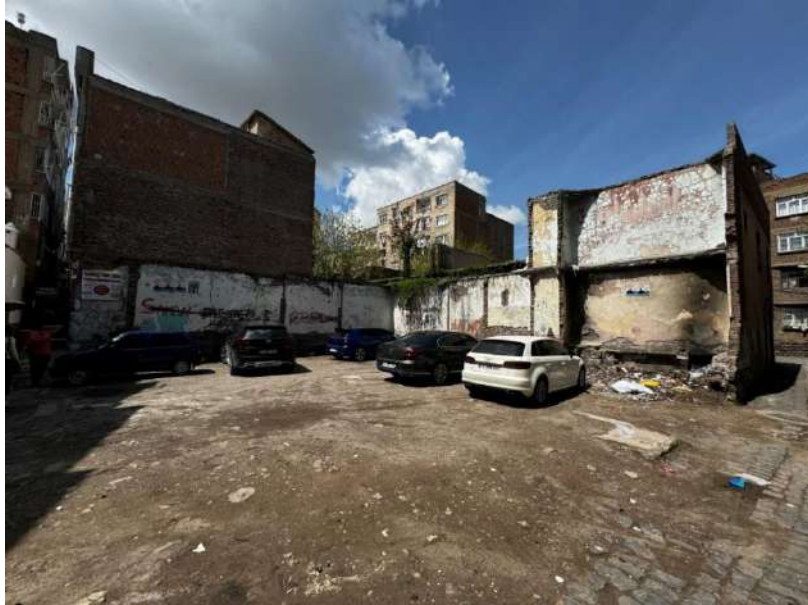
Şekil 6.230 Pirinççiler konağının yıkılıp otoparka çevrilen kısmı
