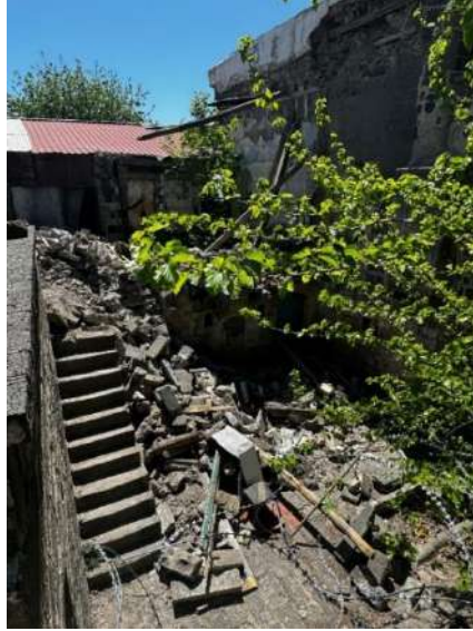
Şekil 6.215 Behram Paşa Konağı'nın selamlık kısmının üstten görünümü
