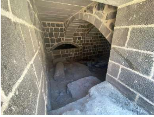
Şekil 6.80 Batı kanat bodrum girişi
