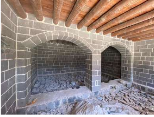
Şekil 6.88 Kuzey kanat yatak odası iki açıklıklı kemer
