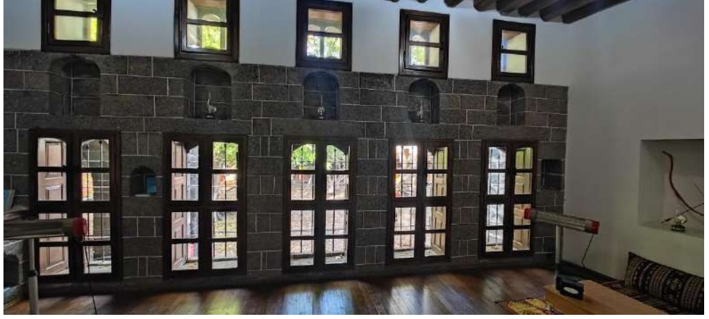
Şekil 6.192 Güney kanat birinci kat oda genel görünüm
