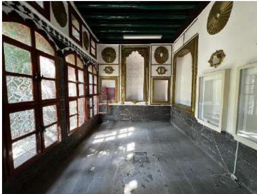
Şekil 6.17 Kuzey kanat sofanın batısında kalan oda
