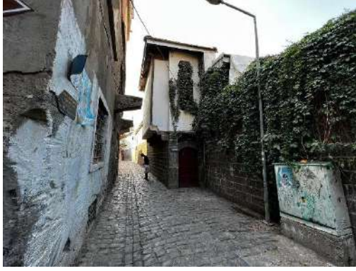
Şekil 6.49 Yapının kuzey cephesi
