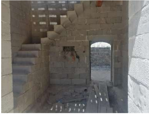
Şekil 6.113 Kuzey kanat yapı girişi
