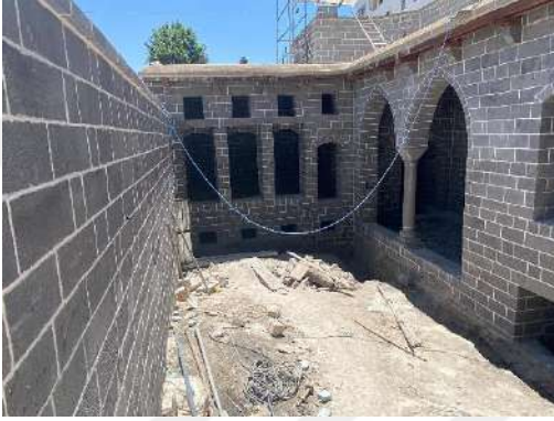
Şekil 6.99 Yapı güney kanat avlu cephesi
