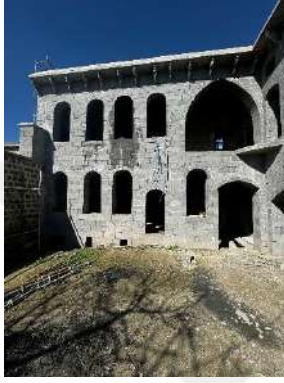
Şekil 6.134 Avlu kuzey kanadı
