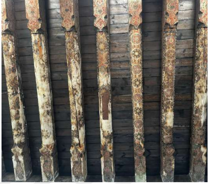
Şekil 6.208 Behram Paşa Konağı birinci kat batı odası tavanı
