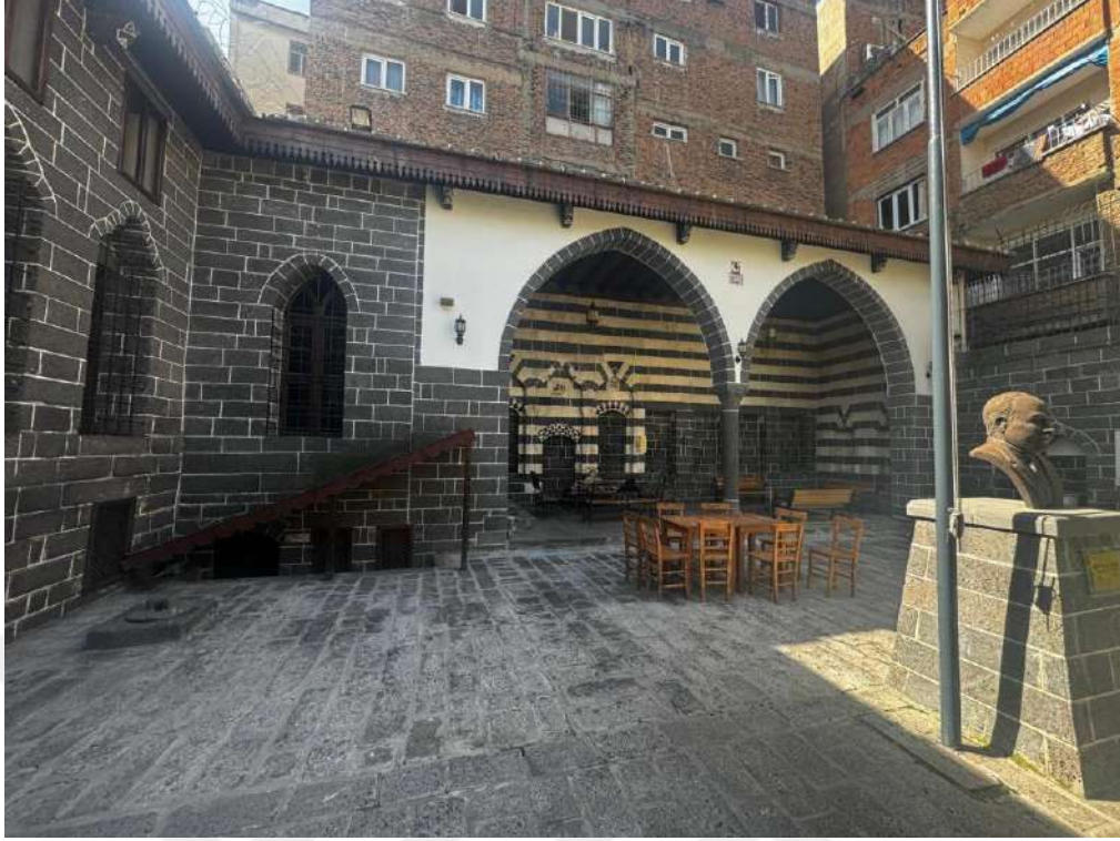
Şekil 6.177 Avlu güney kanat
