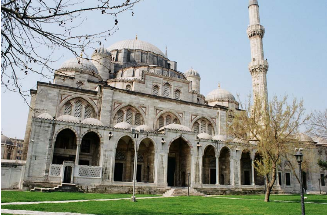
Resim 5. 1. Şehzade Camisi Yan Cephesi (M.Barış Yağlı, 2009)
