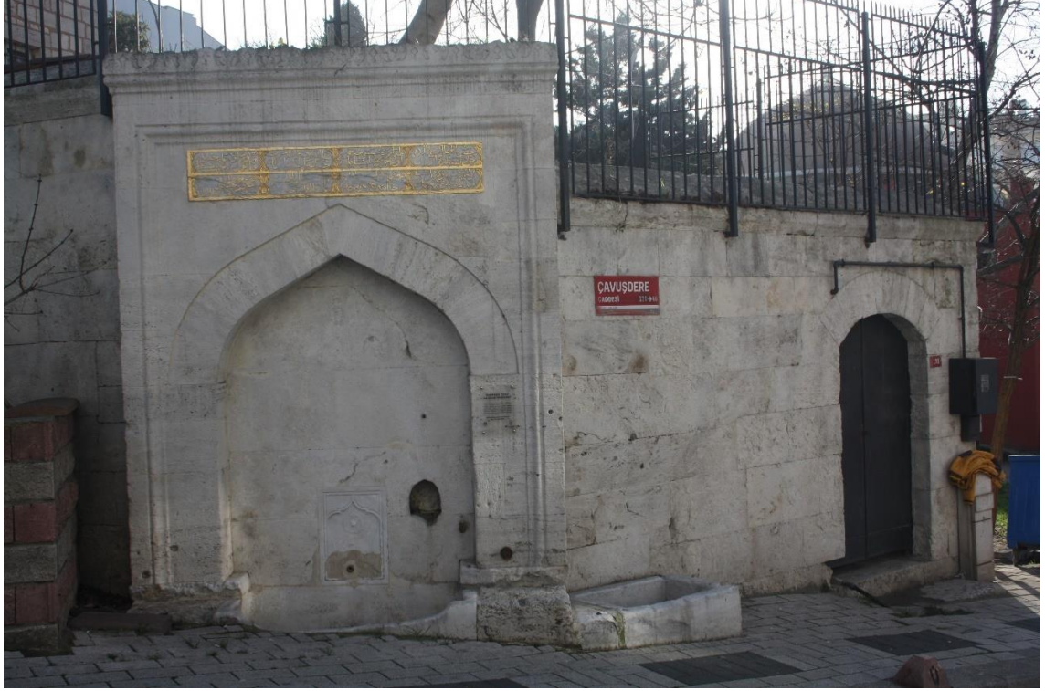
Resim 11: Valide Sultan Çeşmesi
