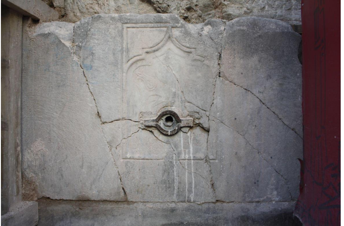
Resim 35: Taştekneler/Kasım Ağa Çeşmesi Günümüz Hali (Restorasyonda)
