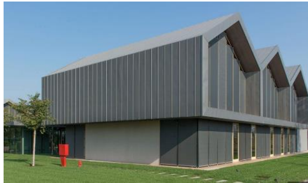
Görsel 25. Çinko Dış cephe kaplama, 2025
