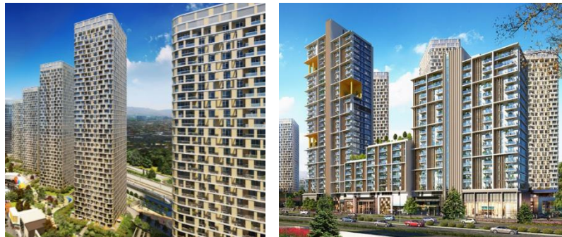
Görsel 53. Merkez Ankara Konutlar Dış Görünüm, 2025
