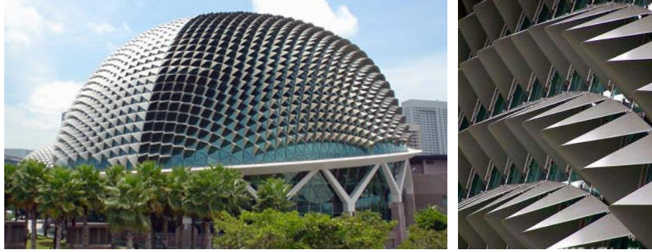
řekil 4.19 Esplanade’de gneř kırıcılar.
