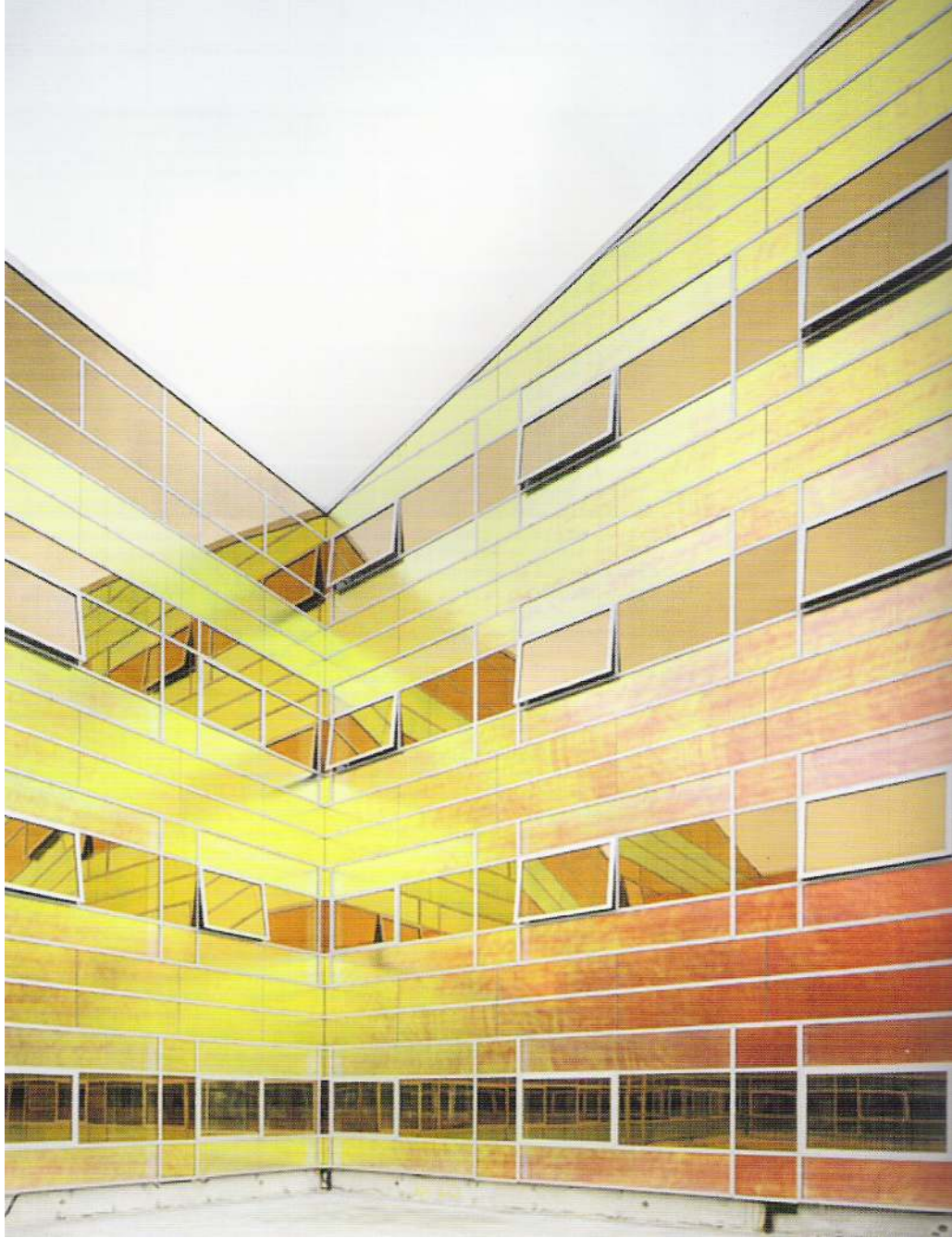
Şekil 3.13 Almere Ofis Binası'nda çizgisel doku ile köşe anlatımı.
