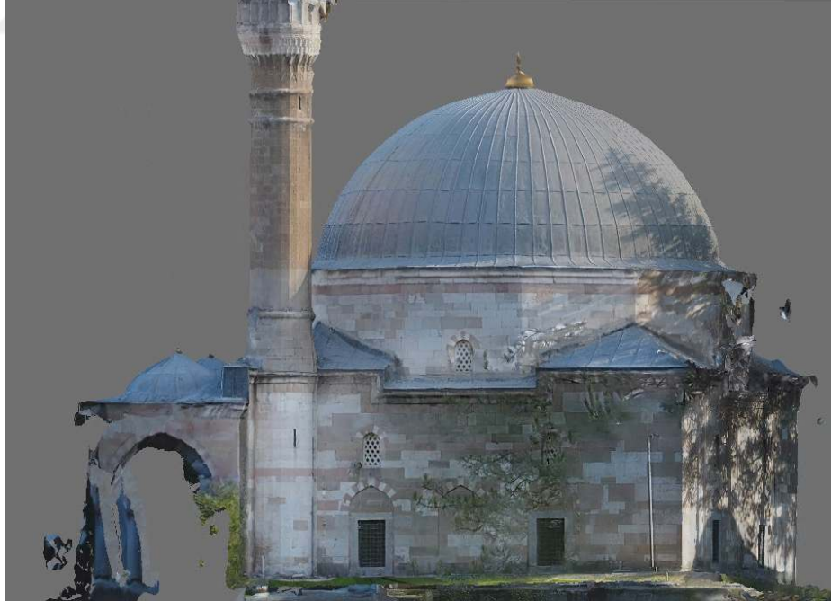
řekil 5.6 Nokta bulutundan retilmiř 3B model batı cephe
