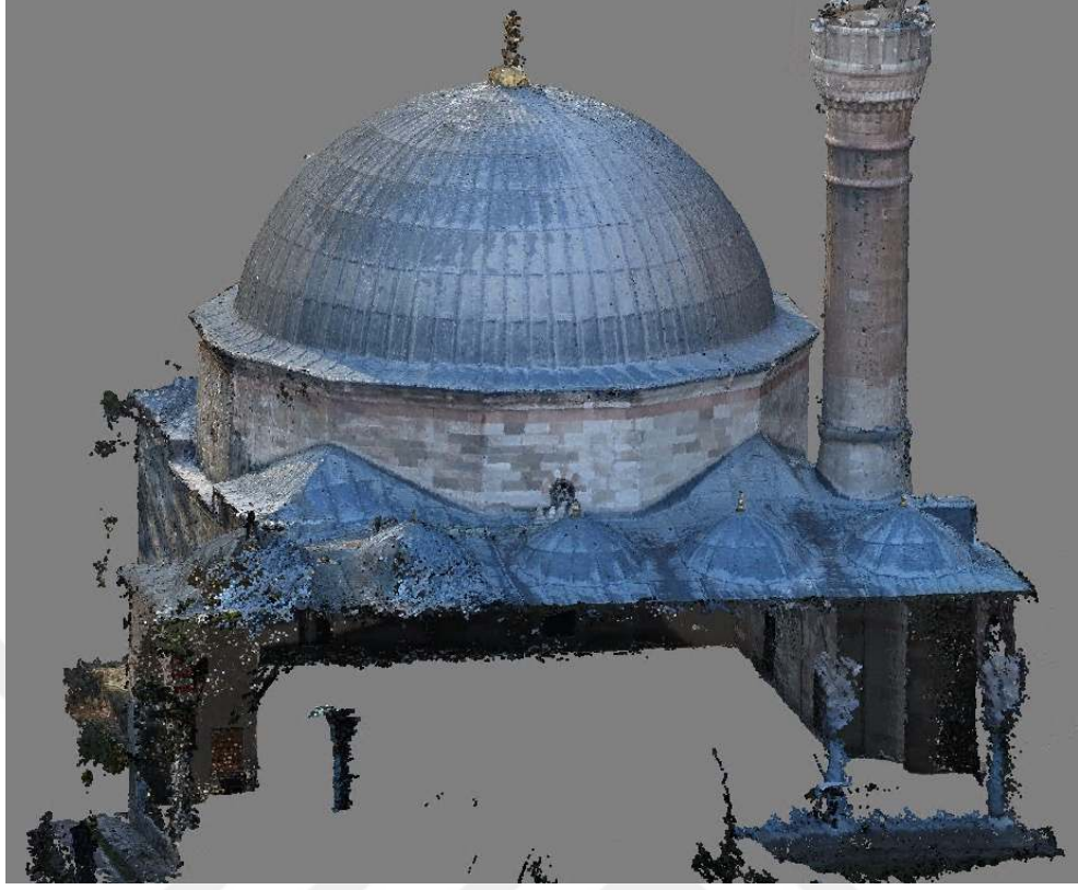
Şekil 5.7 İHA verisinden üretilmiş nokta bulutu kuzey cephe
