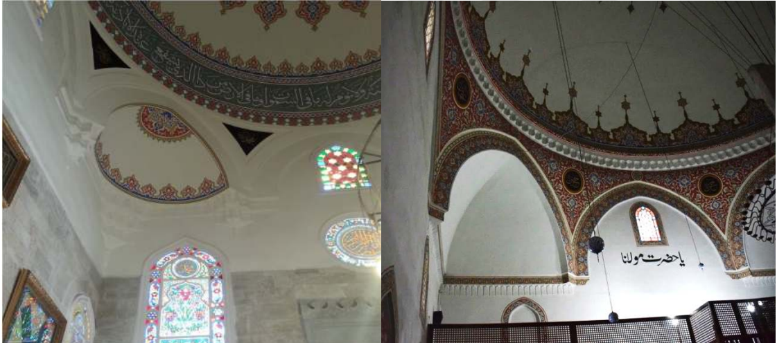
Şekil 8.5 Solda Şemsî Ahmet Paşa Camisi (Şenyurt, 2018) yarım kubbe geçişleri, sağda Kurşunlu Külliye Camisi tromp geçişleri
