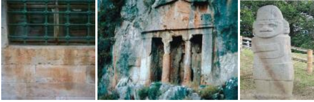
Şekil 116. Metallerin neden olduğu renklenme / Farklı etmenlerin sebep olduğu renklenme / Asit yağmurlarının sebep olduğu renklenme (Öcal & Dal, 2012).
