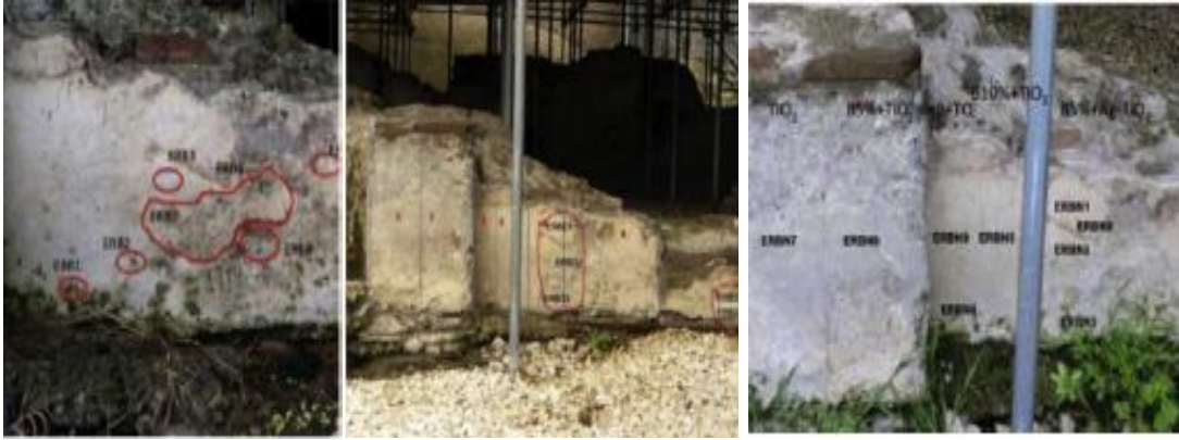
Şekil 158. Villa dei Papiri'nin SE duvarında yer alan biyolojik bozunmaya \text{TiO}_2 uygulaması/ İtalya; Sırasıyla Şubat 2015, Nisan 2015 ve Eylül 2015'te duvar yüzeylerinde biyolojik kolonizasyonun durumu (Uyar Z. , 2024).
