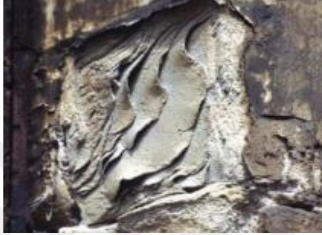
Şekil 133. Taş yüzeyinde tabakalaşma (Tayşi, 2021).
