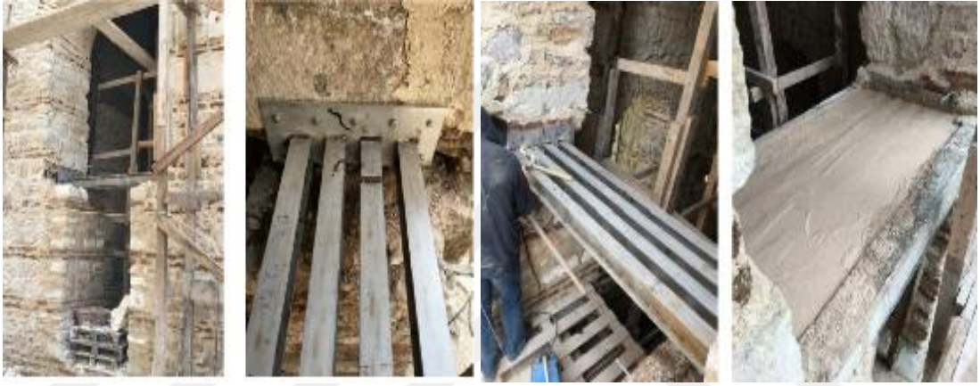
Şekil 64. İstanbul-Fatih İskele (III. Mustafa) Cami Sıbyan Mektebi pencere açıklıklarının çelik lentolarla ile güçlendirilmesi (Yüce, 2021).
