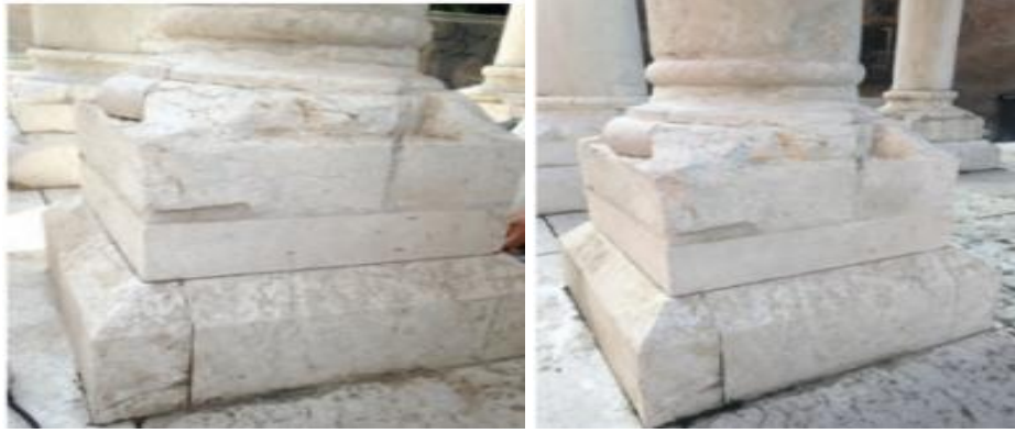
Şekil 170.Solda sağlamlaştırıcı öncesi; sağda sağlamlaştırıcı sonrası (Scherer, Franzoni, Sassoni, & Graziani, 2018).
