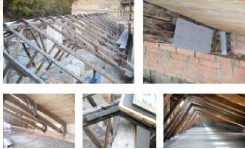
Şekil 99. Metal levha ve kenetlerle güçlendirme (Brancaccio, 2016).
