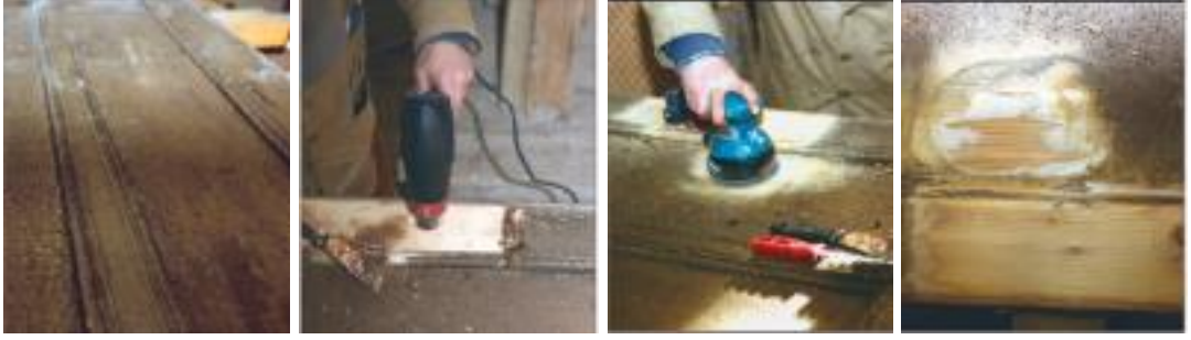
Şekil 200. Mekanik yöntem ve ısı yöntemi ile boya sökümü (İ.B.B., 2009).
