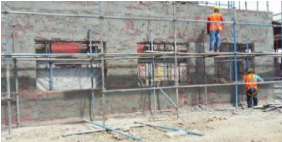
Şekil 54.İstanbul- Hasanpaşa Gazhane Binası'na FRP Uygulaması (Yıldırım, 2023).
