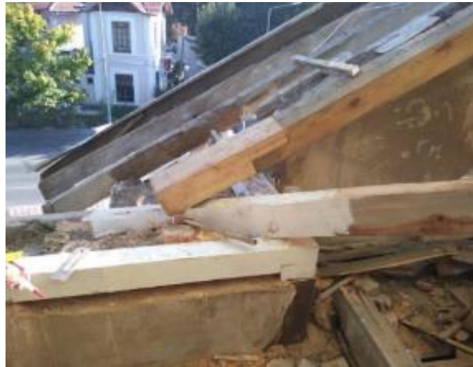
Şekil 95.Kırklareli Gar Binası, Gei döndürülemez müdahale-Ahşap çatı taşıyıcılarda bozulan kısımların yenilenmesi (Güven, 2022).
