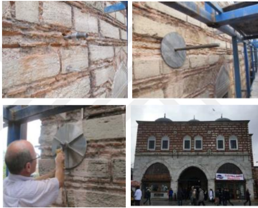
Şekil 59. İstanbul-Mısır Çarşısı Balıkpazarı Kapısı üstü odalarının paslanmaz çelik hatılların yerleştirilmesi (Yüce, 2021).
