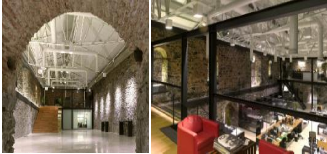
Şekil 8.İç mekânda geri döndürülebilirliği mümkün çelik strüktürle tasarlanan asma katlar (Büyükarıslan & Güney, 2013).
