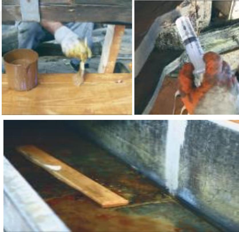
Şekil 202. İstanbul- Yenicami Hünkâr Kasrı, Sırasıyla fırça ile sürülerek sağlamlaştırma uygulamaları, enjeksiyon yöntemi ile sağlamlaştırma, Emprenye yöntemi ile sağlamlaştırma (İ.B.B., 2009).
