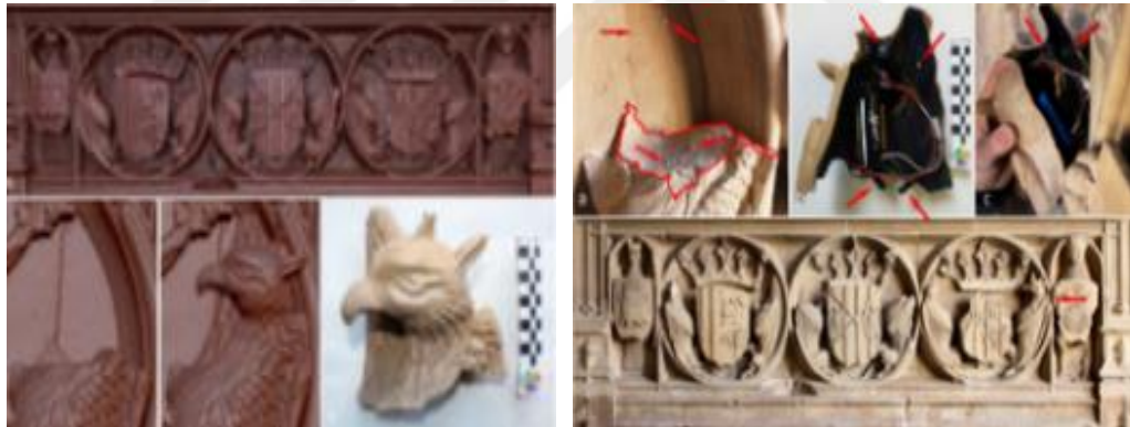
Şekil 33. Solda esik alanın 3d rekonstrüksiyon ve SLA ile basılmış protez, sağda eksik bölgeye akıllı protezin yapıştırılmasını işlemi (Niqueta, Sánchez-Lópezb, & Mas-Barberàa, 2020).
