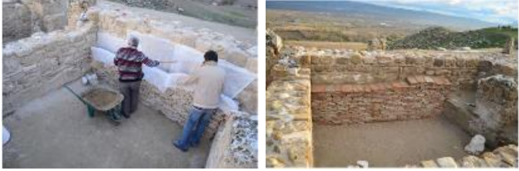
Şekil 18. Lokal koruma setinin oluşturulması (Tarhan, 2019)
