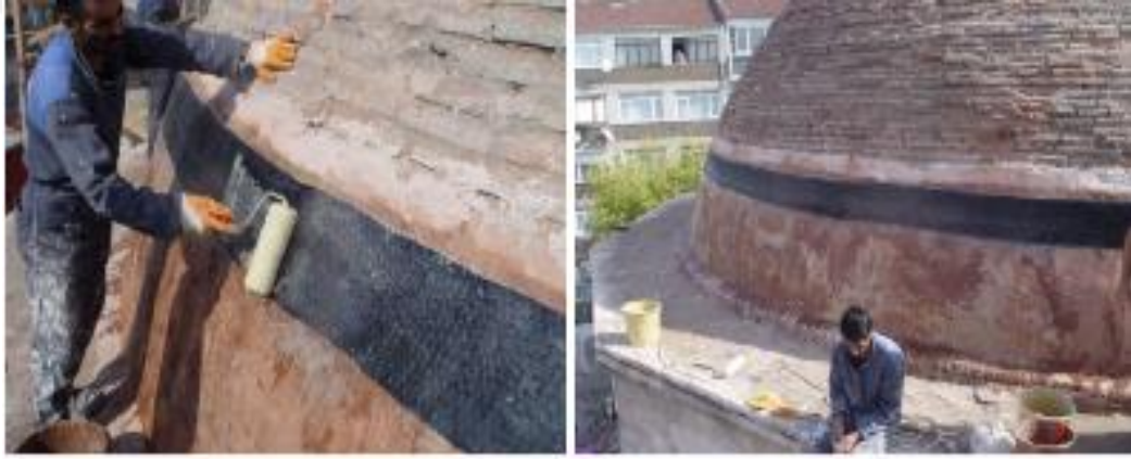
Şekil 83. İskendepaşa Camii ana kubbe kasağında epoksi reçine sürülerek geri dönüşümü mümkün olmayan karbon lifli polimer kumaş (CFRP) uygulaması (Yüce, 2021).
