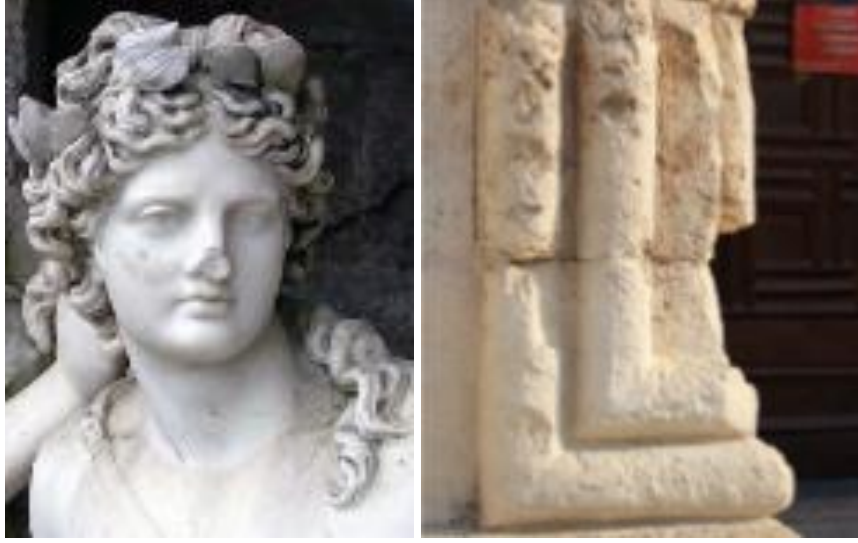
Şekil 126. Solda parça kaybının olduğu bir heykel (ICOMOS-ISCS, 2008); Sağda Kırşehir Cacabey Medresesi'nde görülen parça kaybı (Yurttaş, 2018)
