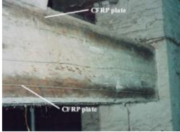
Şekil 96. Kiriş güçlendirmek için yapılan geri dönüşümsüz CFRP uygulaması (Pinto, 2008).
