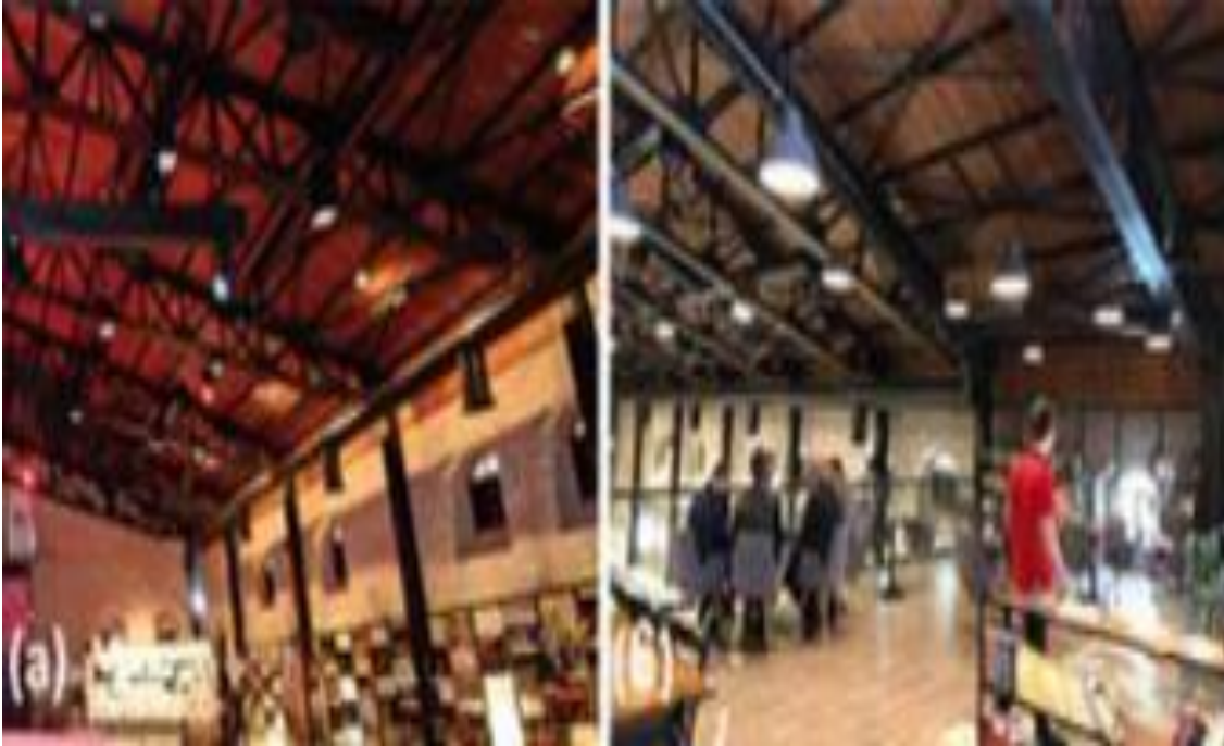
Şekil 4. Tantavi Ambarı iç mekânda çelik strüktürler üzerinde çözülen havalandırma ve aydınlatmalar (Yalaz & Yıldız, 2020).
