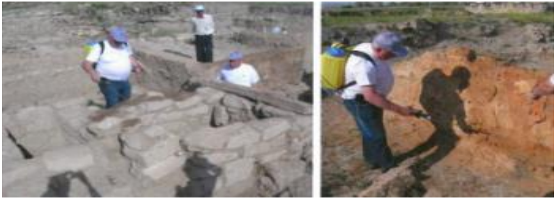
Şekil 27. Kayseri- Kocasinan Kültepe Kaniş Ören Yeri'nde kerpiç duvarlar ve taş temellerin korunmasına yönelik taş koruyucu nano silis partiküllerinden oluşan hidrofor nanomalzeme uygulaması (Uyar Z. , 2024).
