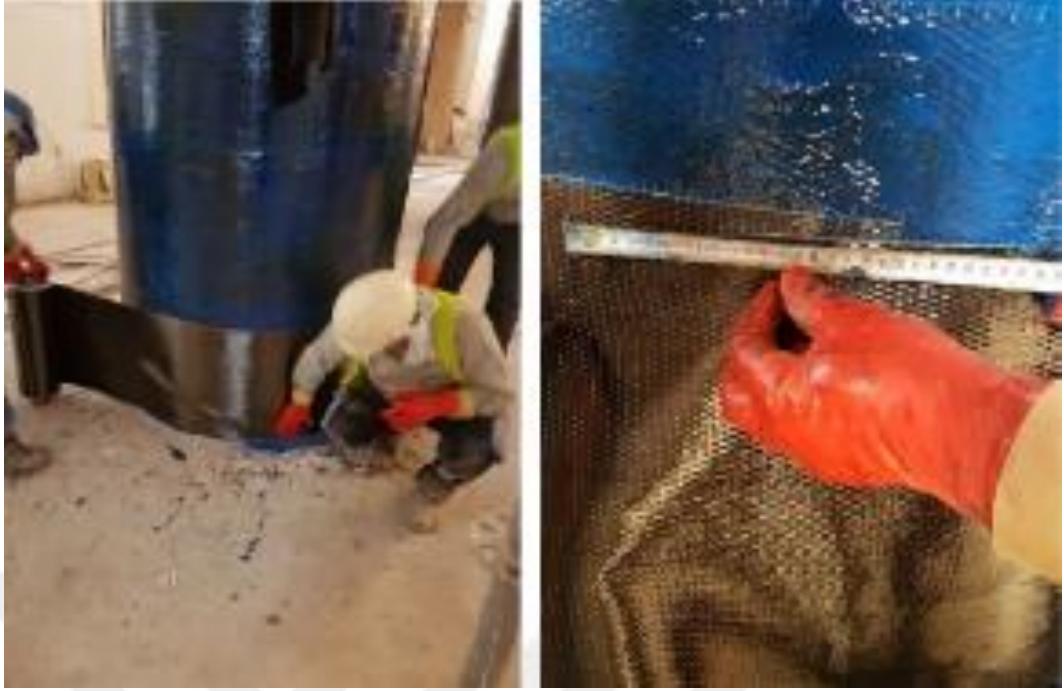
Şekil 91.İzmir/Konak -Hisar Camii geri dönüşü mümkün olmayan güçlendirme müdahalesi, Taşıyıcı ayaklara yapılan epoksi reçine üzerine FRP uygulaması (Uyar Z. , 2024).
