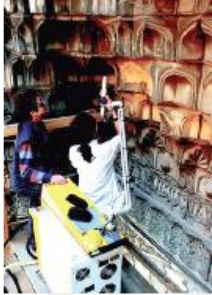
Şekil 149.Lazer ile temizleme (Ersen, 2013)
