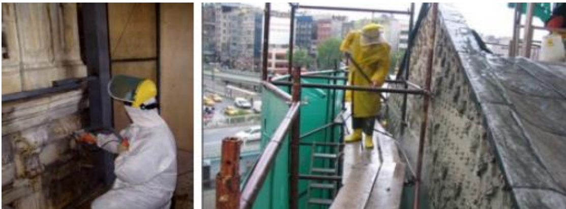
Şekil 142.Basınçlı su ile temizlik (Zakar, 2013; Kaçmaz, 2020)
