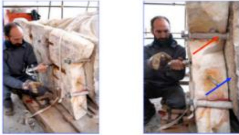
Şekil 30.Çıkış delikli dişli pimlerin (kırmızı ok), kuru pimlerin (mavi ok) yerleştirilmesi (Devreux & Spada, 2010).
