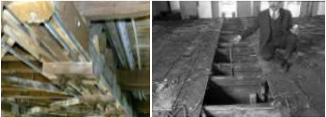
Şekil 73.Solda ahşap döşeme kirişinde yapılan FRP güçlendirme uygulaması (Zakar, 2013). Sağda Mimar Sinan Üniversitesi Mimarlık Fakültesi'nin ahşap kirişli döşemelerinin betonarme döşemeye çevrilmek için kaldırılması (Yıldırım, 2023).
