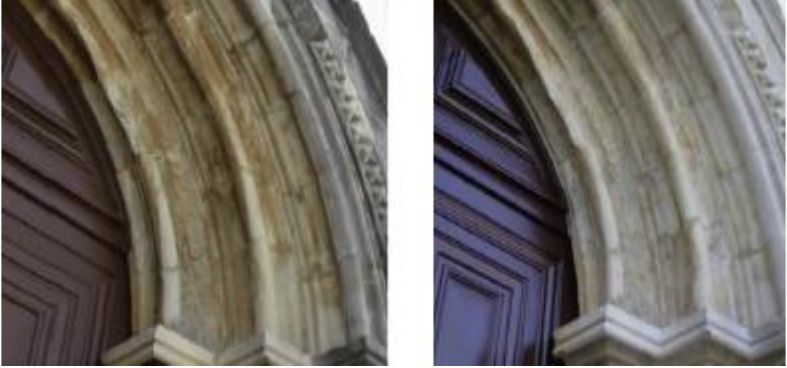
Şekil 171. Portekiz-Loulé Kilisesi’nde biyo sağlamlaştırıcı uygulaması; Solda uygulama öncesi, sağda uygulama sonrası (Rodriguesa & Pinto, 2019).
