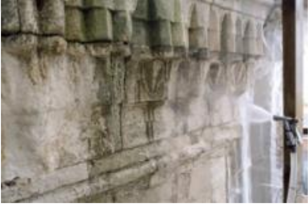
Şekil 143. Atomize su ile yıkama (Ersen, 2013).
