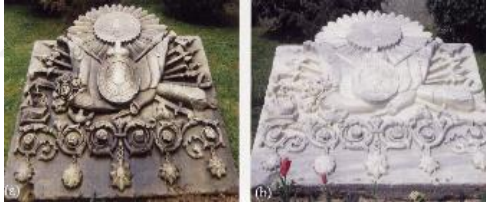
Şekil 146. Mikro kumlama ile yapılan yüzey temizliği a) öncesi, b) sonrası (Zakar, 2013).
