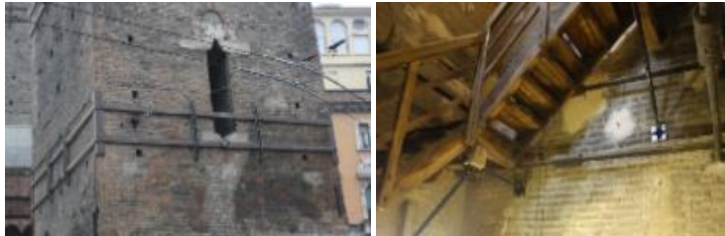
Şekil 60. Bolonya Asinelli Kulesi Gergi uygulaması- iç mekân/ Bolonya Eğri Kule Gergi Uygulaması-Kuşaklama dış cephe görünüşü (Zakar, 2013).
