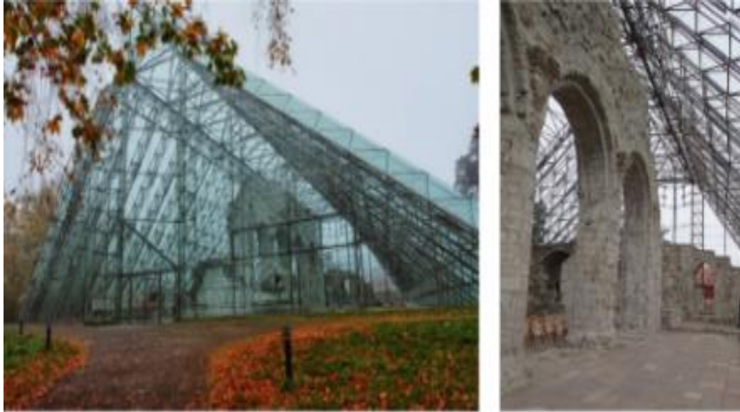
Şekil 20. Hamar Katedrali Koruyucu Çatı Örtüsü, Norveç (Yılmaz, Şener, & Yılmaz, 2019).
