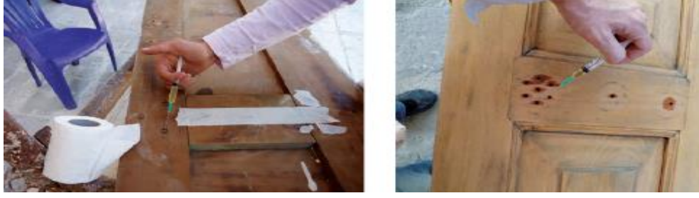
Şekil 205. Ankara Altındağ Cenab-ı Ahmet Paşa Camii Ahşap elemanlarda enjeksiyon yöntemi ile ilaçlama çalışmaları (KUDEB, 2009-2011).
