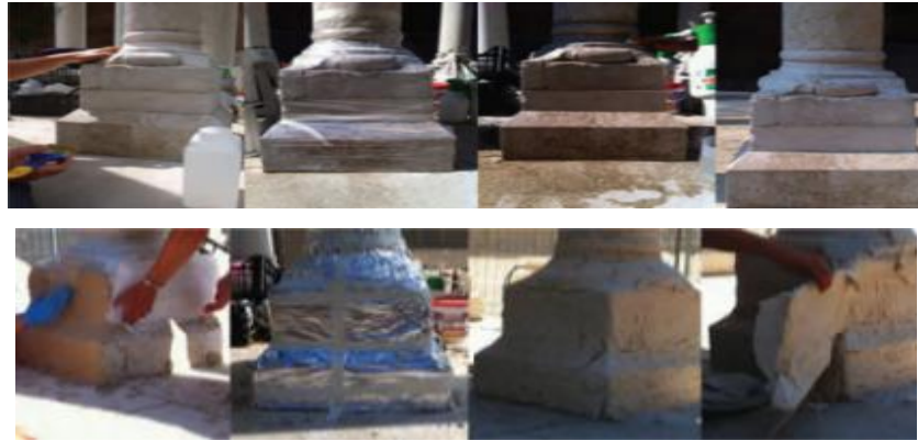
Şekil 169. İtalya-Bologna’da Rolandino De Passeggeri Mezarının sütun kaidesine yapılan hidroksiapatit (HAP) sağlamlaştırıcı uygulama aşamaları (Scherer, Franzoni, Sassoni, & Graziani, 2018).
