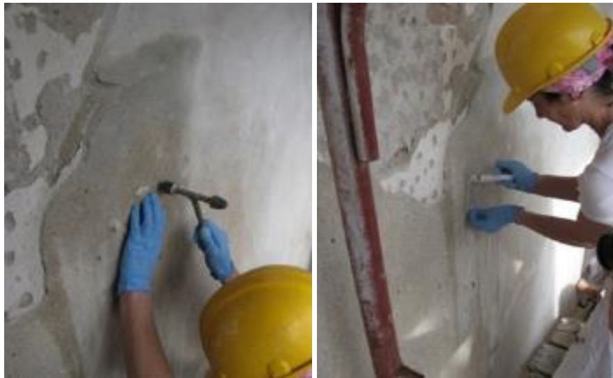
Şekil 179. Sıvanın enjeksiyon tekniğiyle sağlamlaştırılması (Zakar, 2013).
