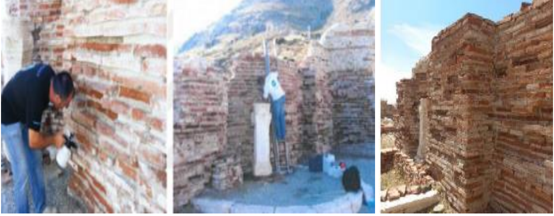
Şekil 25. Solda Burdur- Sagalassos Antik Kenti hamam yapısına yüzey koruyucu nanomalzeme uygulaması; sağda yapının günümüzde de tuğla örgülü duvarların yüzeylerinin ve harçlı derzlerin özgünlüğünü koruduğu görülmektedir (Uyar Z. , 2024).
