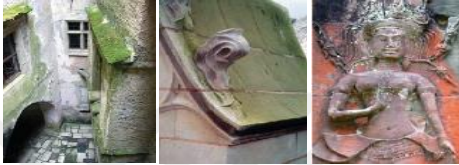
Şekil 135. Taş yüzeyinde oluşan algler (ICOMOS-ISCS, 2008).
