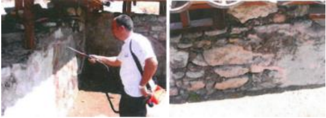
Şekil 25. Solda Burdur- Sagalassos Antik Kenti hamam yapısına yüzey koruyucu nanomalzeme uygulaması; sağda yapının günümüzde de tuğla örgülü duvarların yüzeylerinin ve harçlı derzlerin özgünlüğünü koruduğu görülmektedir (Uyar Z. , 2024).
