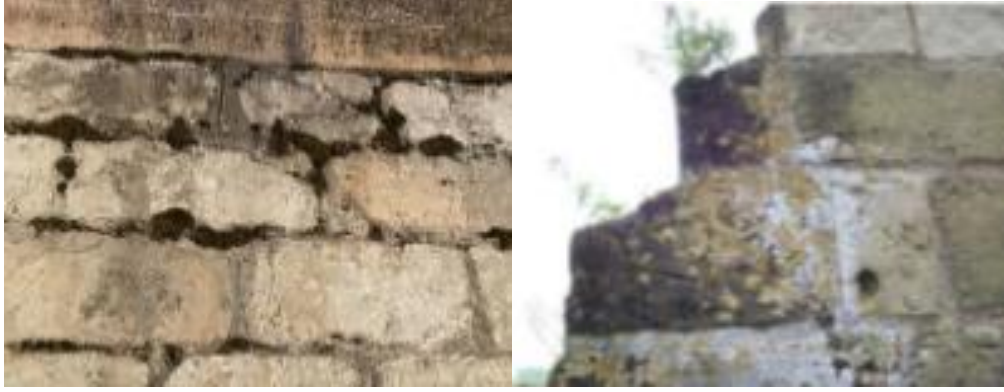
Şekil 138. Taş malzemedede gözlemlenen mantarlar, Solda Konya Alâeddin Cami (Ünal, 2023); Sağda Val de Loire, Fransa (Vatan Kaptan, 2010).
