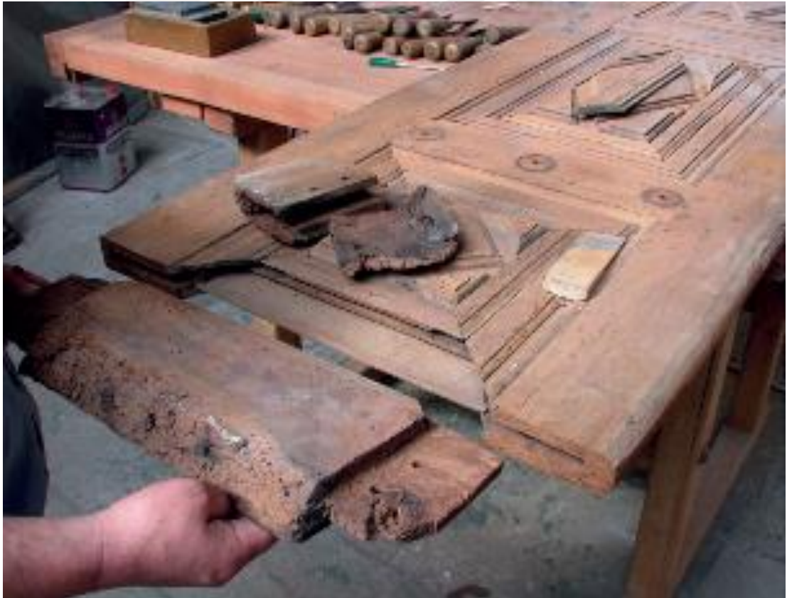
Şekil 199. İstanbul-Nuruosmaniye Cami, Ahşap malzemede temizlik-bütünleme-sağlamlaştırma (Alioğlu & Aydemir, 2012).
