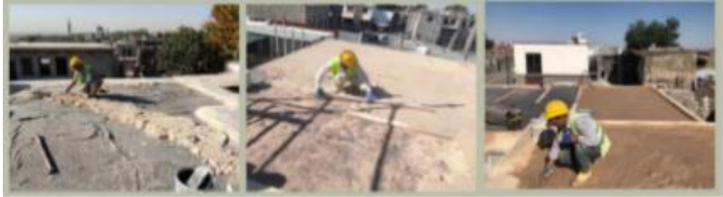
Şekil 107. Düz çatıda geri döndürülemez bir uygulama- Dam harcının serilmesi Diyarbakır-Suriçi/Geleneksel bir Diyarbakır Evi Örneği (Dabanoğlu & Çağlayan, 2024).
