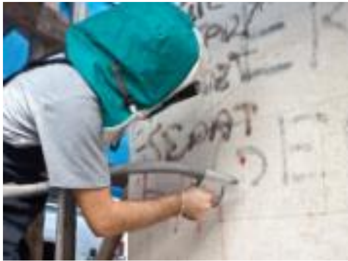
Şekil 145.Kumlama uygulaması (Ersen, 2013)
