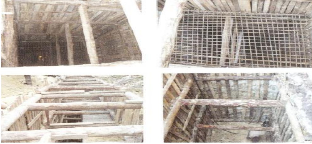
Şekil 39. Depreme karşı güçlendirme çalışmalarında temeli daha sağlam kılmayı ön gören kuyu temel ile caminin dört yönünün geri dönüşü mümkün olmayan betonarme perde içine alınması, Edirnekapı Mihrimah Sultan Camii-İstanbul (Karakuş, 2012).
