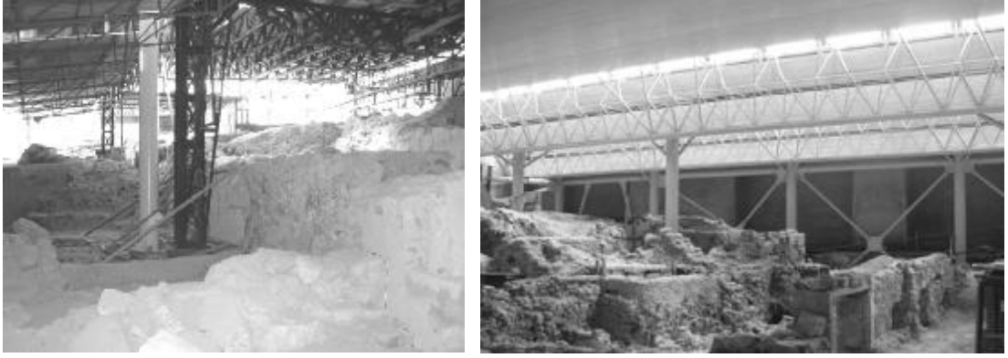
Şekil 12. Yunanistan- Akrotiri arkeolojik sit alanında eski strüktüre ait kolonun yerine yenisinin yerleştirilmesi solda, Kolonlar arasında kullanılan takılıp sökülebilirliği mümkün çaprazlama kirişler sağda (Uyar O. , 2008)
