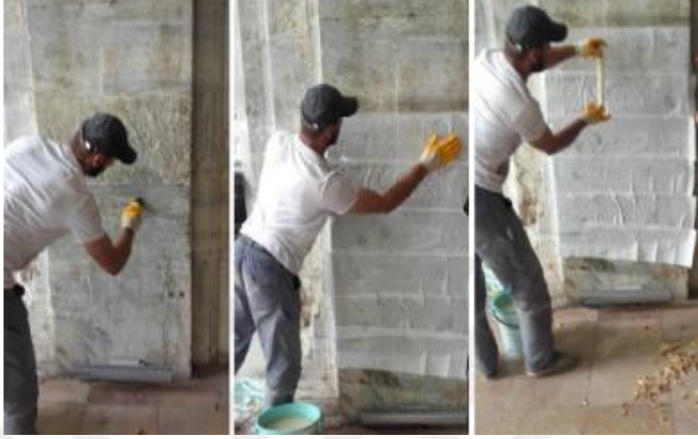
Şekil 148. Bursa-Yıldırım Bayezid Camii, Kimyasal temizlik uygulamaları (Kaçmaz, 2020).
