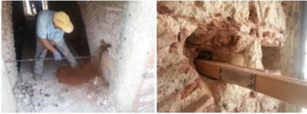
Şekil 207.İstanbul-Mısır Çarşısı moloz taş duvarlarında çürümüş ahşap hatılın yenilemesi (Yüce, 2021).
