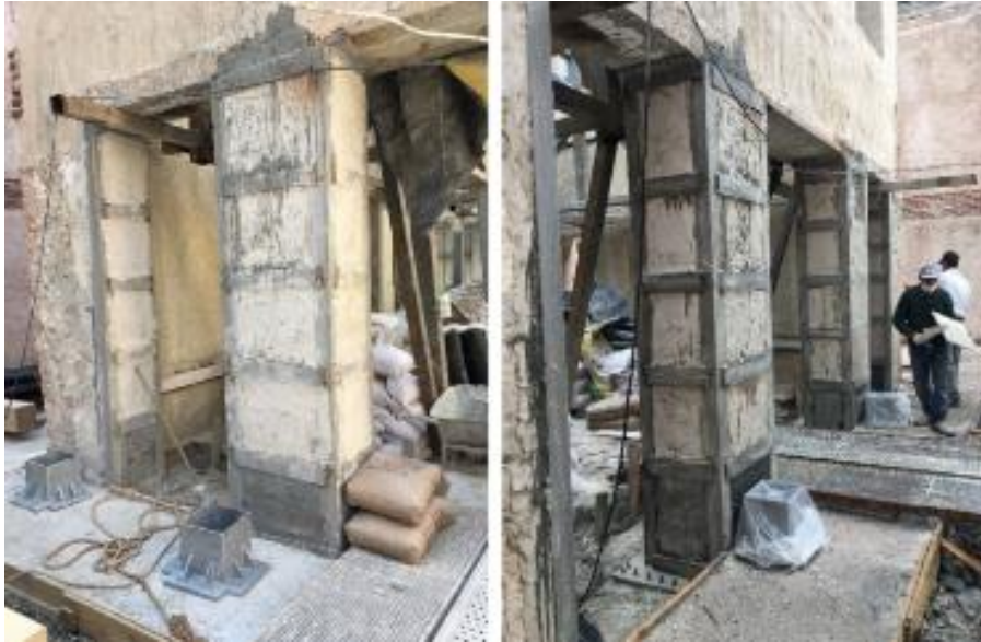
Şekil 65. İstanbul-Fatih İskele (III. Mustafa) Cami Sıbyan Mektebi kârgir ayakların paslanmaz çelik elemanlar ile güçlendirilmesi (Yüce, 2021).
