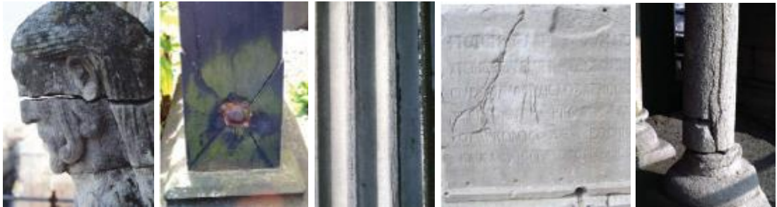
Şekil 128. Kırık/Yıldız şeklinde kırık/Kılcal çatlak/Çatlaklar Ağı/Yarık (ICOMOS-ISCs, 2008; Öcal & Dal, 2012).
