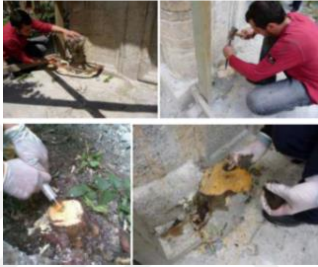
Şekil 147.Tarihi taş yapıda odunsu bitkilerin temizlenme aşamaları (Kaçmaz, 2020)
