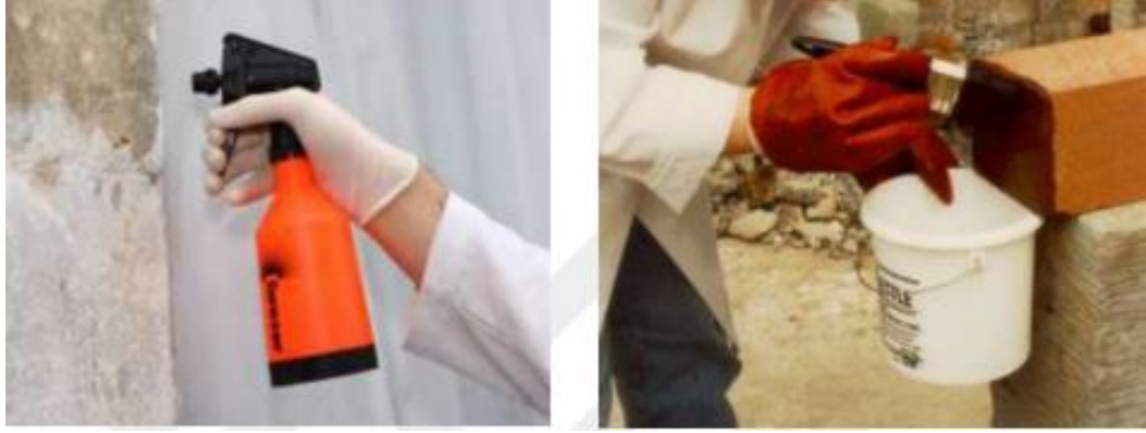
Şekil 152.Solda Püskürtme yöntemiyle sağlamlaştırıcı uygulaması; Sağda fırça sürme yöntemiyle sağlamlaştırıcı uygulaması (Tayşi, 2021).
