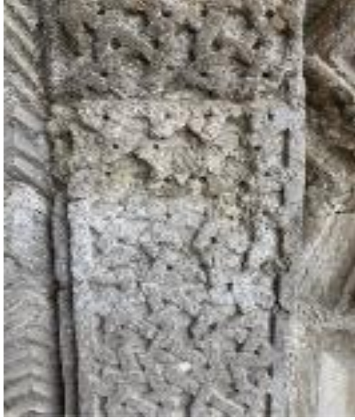
Şekil 134. Sırçalı Medrese taş kapısında meydana gelen dağılmalar (Ünal, 2023).
