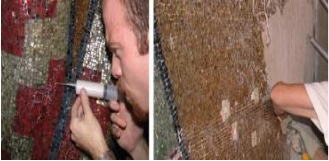
Şekil 178. Ayasofya'nın kubbe mozaiklerinin sağlamlaştırılması amacıyla yapılan harç enjeksiyonu; Solda mikro enjeksiyon, sağda makro enjeksiyon (Cura, 2024).
