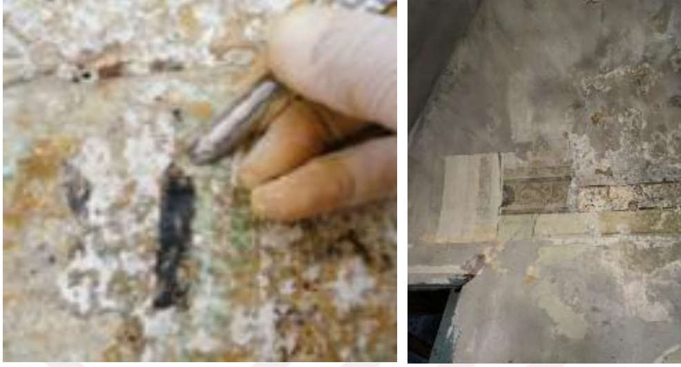
Şekil 144.Solda küçük el aletleri ile yapılan temizlik (Ersen, 2013); Sağda St. Pierre Han- Raspalama işlemi sonucunda bulunan motif (Güven, 2022).
