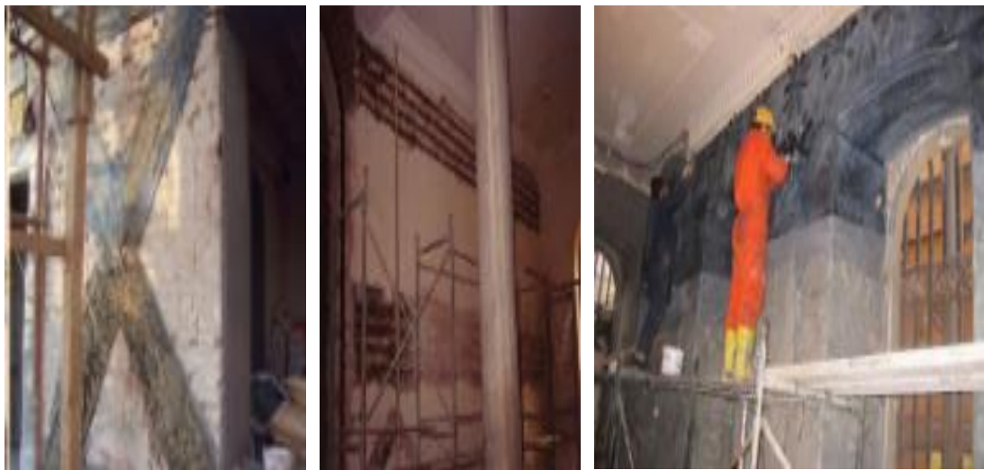
Şekil 56. Geri dönüşü mümkün olmayan CFRP ve FRP bant uygulamaları (Zakar, 2013).
