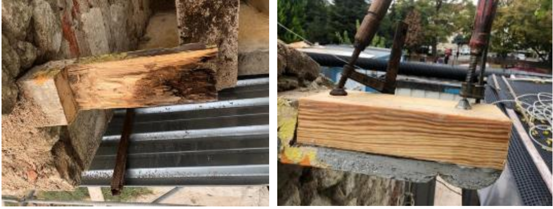
Şekil 203. Kırklareli Gar Binası, Çürüyen çatı kirişinin yeni parça takviyesi ile sağlamlaştırması (Güven, 2022).
