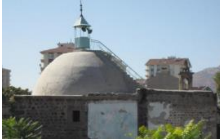
Şekil 82. Kayseri Gubaroğlu Mescidi beton atılmış kubbe (Karakuş, 2012).
