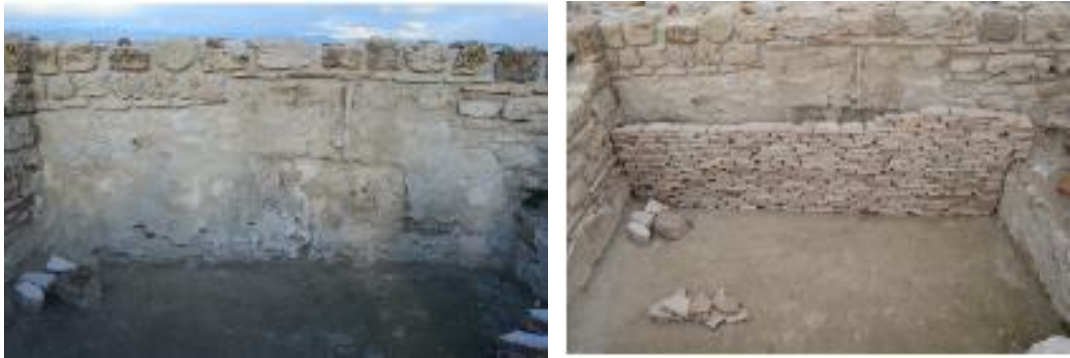
Şekil 17. Freskin yer aldığı duvar ve harçsız kuru örgü tekniğiyle oluşturulan lokal koruma seti (Tarhan, 2019).
