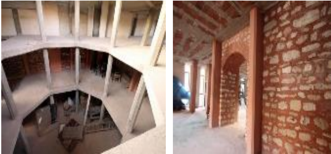
Şekil 1.İstanbul-Ağa Hamamı Soğukluk(solda) ve Ilıklık(sağda) Mekânında betonarme döşeme uygulaması (Cebioğlu, 2013).
