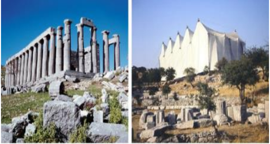
Şekil 19. Apollo Epicurius Tapınağı Koruyucu Çatı Örtüsü, Girit Adası/Yunanistan (Yılmaz, Şener, & Yılmaz, 2019).
