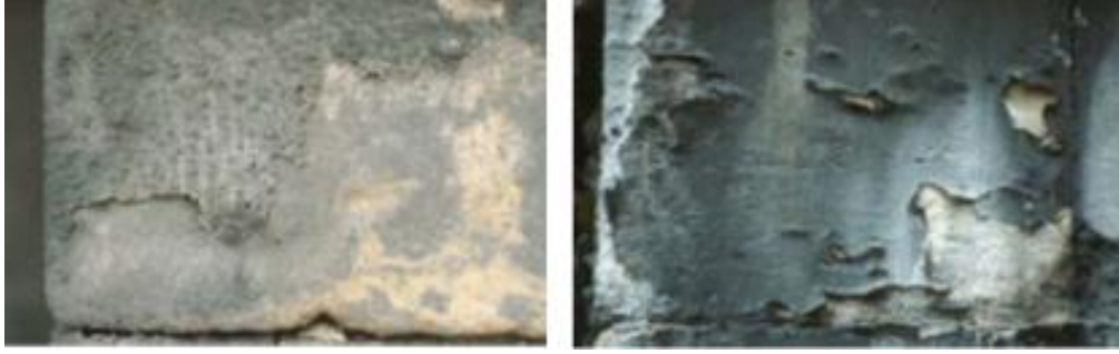
Şekil 131. Taş yüzeyinde meydana gelen kabarma (Öcal & Dal, 2012).
