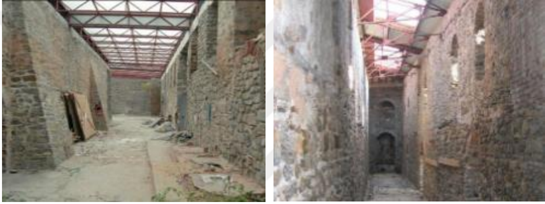
Şekil 6.İstanbul-Kasimpaşa Tuz Ambarının restorasyon öncesi hali (Büyükarıslan & Güney, 2013).
