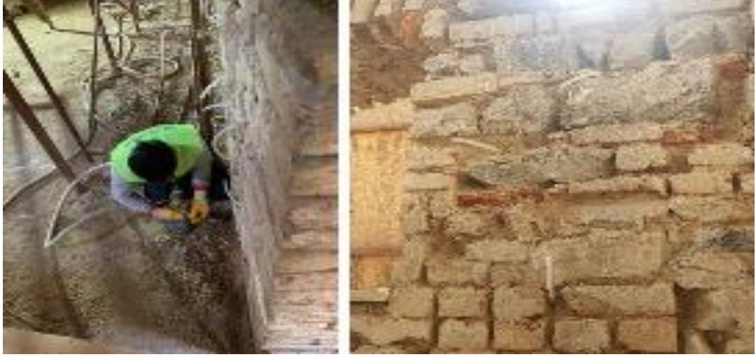
Şekil 53.İstanbul - Kâğıthane Tarihi Çamaşırhane Binası'nda Enjeksiyon Yöntemi (Yıldırım, 2023).
