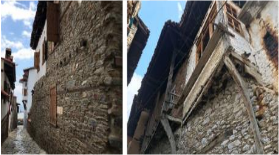
Şekil 184. İzmir, Birgi Köyü geleneksel evlerinden ahşap hatıl ve ahşap payandaların kullanımı (Yüce, 2021).
