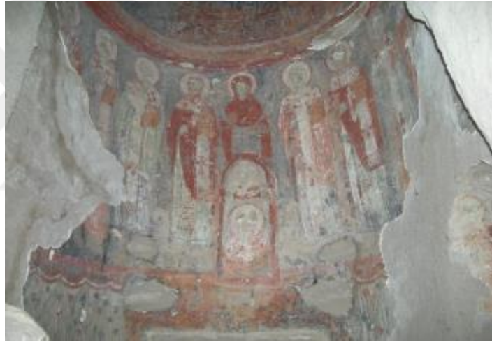
Şekil 175.Aksaray-Ihlara Vadisi, Direkli Kilise Sıva Dökülmesi (Günözü, 2014).
