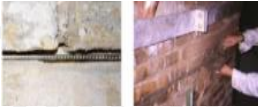
Şekil 62. FRP çubukların hidrolik kireç esaslı harçlar ile geri döndürülebilir duvar güçlendirme uygulaması (Keskin & Özen; Küçükdoğan, 2007).
