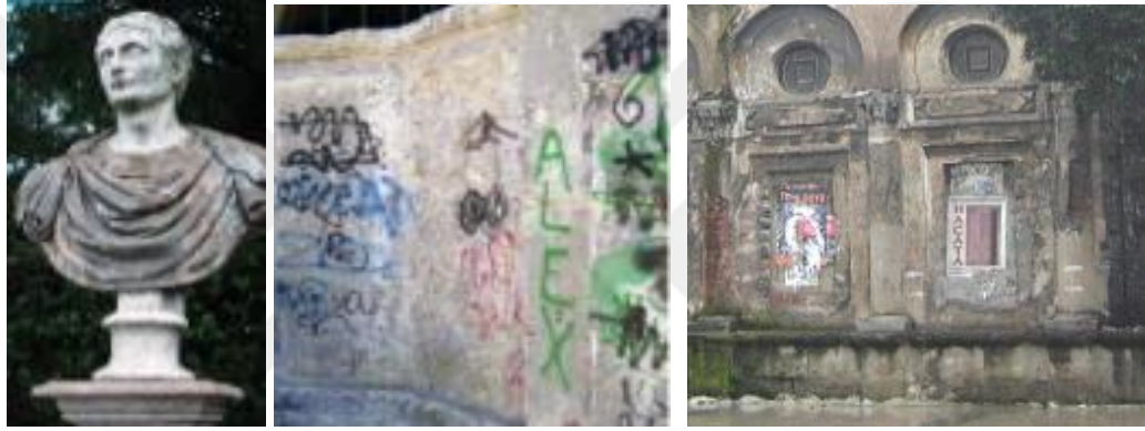
Şekil 120. Taş heykeller ve duvar yüzeylerine yapılan grafitiler (ICOMOS-ISCS, 2008); İstanbul-Köprülü Medresesi tarihi yapı cephesine vandalizm (Vatan Kaptan, 2010).
