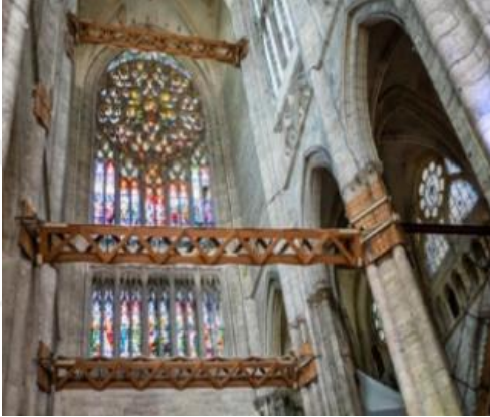
Şekil 212. Fransa-Beauvais Katedrali'nde kullanılan geri döndürülebilirliği mümkün ahşap gergi destekler (Yıldırım, 2023).
