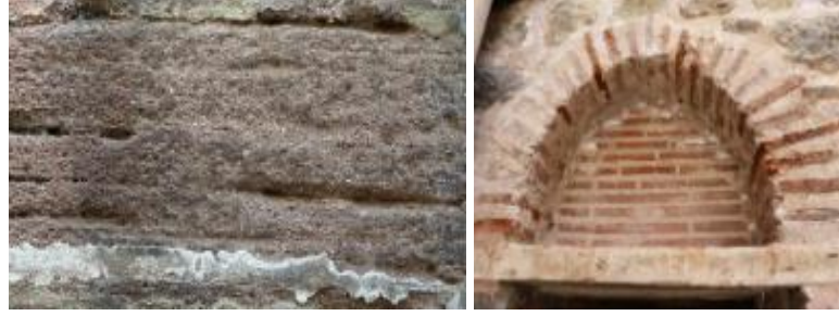
Şekil 124. Solda taşlarda görülen diferansiyel erozyon (Ünal, 2023);Sağda Afyon Boyalıköy Medresesi (Yurttaş, 2018).
