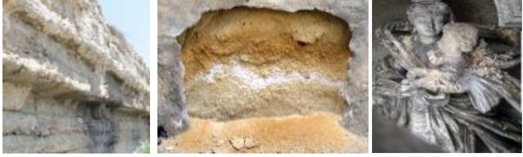
Şekil 114. Taş yüzeylerinde meydana gelen birikmeler tuz, hayvan pisliği vb. (ICOMOS-ISCS, 2008; Öcal & Dal, 2012).
