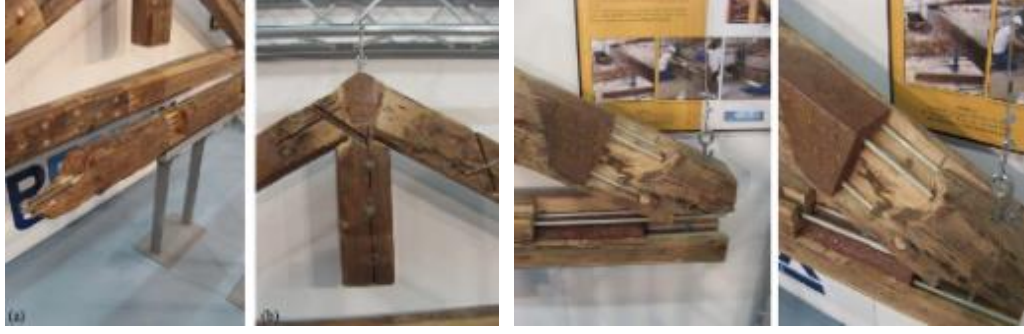
Şekil 94. Ahşap çatı taşıyıcıların metal donatılarla güçlendirilmesi (Zakar, 2013).
