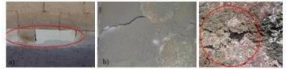
řekil 118.a) Mustafapařa M.Y. O.binasının temelinde ait tf tařlarda tozlařma(Nevřehir), b)Selimiye Camii- St. Sophia Katedrali bir bloęun kimyasal bozunma sonucunda kabuklanması (Lefkořa), c) Kale duvarında kristalleřme sonucunda oluřan kabarma (Ankara) (etin, 2024)
