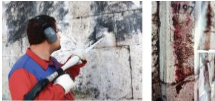
Şekil 150.Kuru buz ile temizlik uygulaması (Ersen, 2013).
