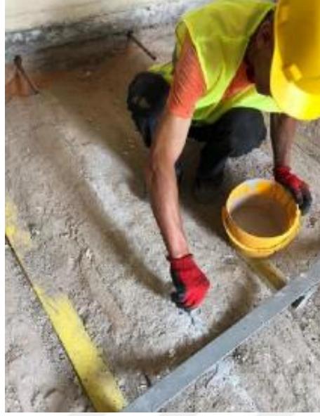
Şekil 72.Kırlareli Gar Binası, Volta döşemedeki tuğla çatlaklarına enjeksiyon uygulaması (Güven, 2022).
