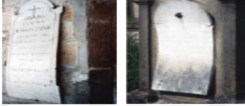
Şekil 129. Daha çok mermerlerde görülen deformasyon ve bükülmeye örnekler (ICOMOS-ISCS, 2008).
