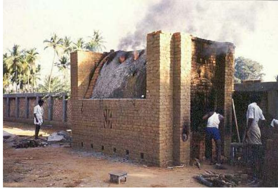
Fotoğraf 18: Meeker'in 1. yapısının pişirilmesi (De Rooden, Web, 1990)
