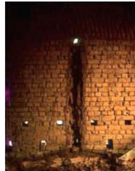
Fotoğraf 21: Meeker'in 2. yapısının pişirmesi ve çatlağı (Kundoo, 2008: 291)
