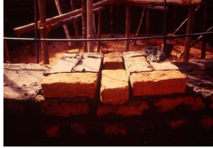
Fotoğraf 20: 2. Yapının pişmiş ve pişmemiş tuğlalarının birleştirildiği duvar (Kundoo, 2008: 66)
