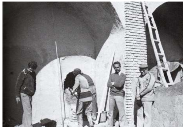
Fotoğraf 9: Duvardaki açıklıkların harçsız kerpiç tuğlalar ile kapatılması (Khalili, 2008: 27)
