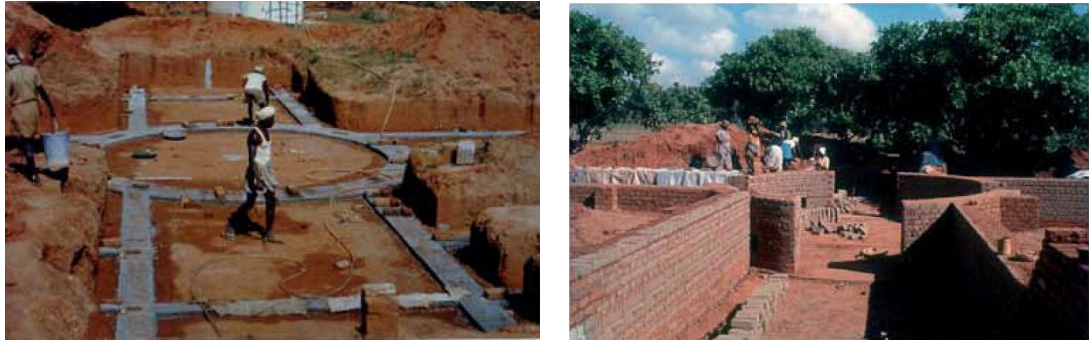
Fotoğraf 30: Duvarların, çimentodan dayanma ayağı ve zemin düzeyinin altındandan başlaması (Kundoo, 2008: 298)
