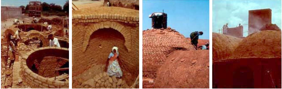
Fotoğraf 49: Minolta Aquatech'in lojmanlarının inşaatı ve pişirilmesi (Kundoo, 2008: 333)
