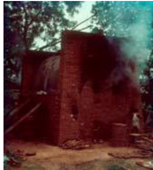
Fotoğraf 21: Meeker'in 2. yapısının pişirmesi ve çatlağı (Kundoo, 2008: 291)
