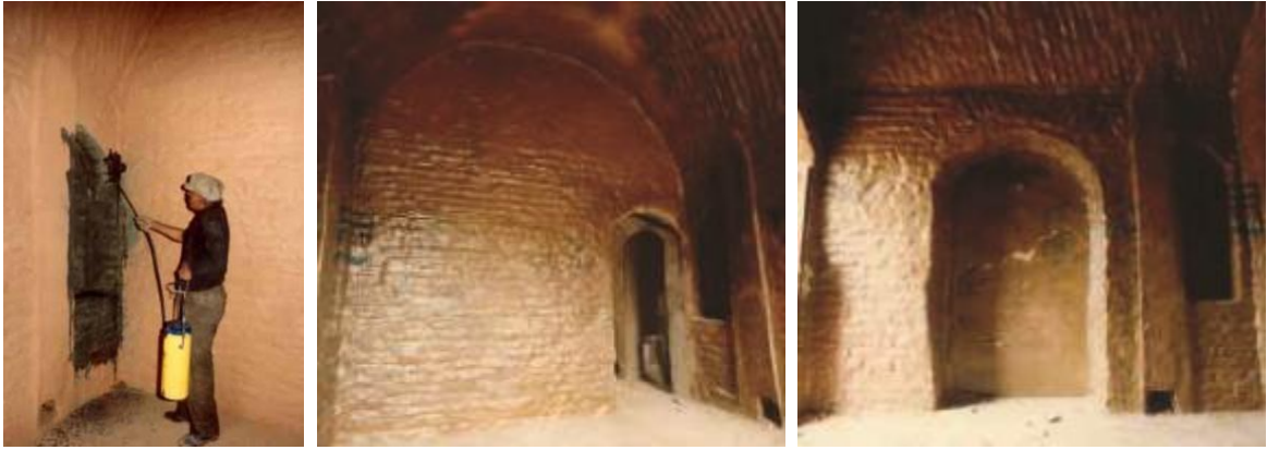
Fotoğraf 14: Javadabad ilkokulunun bazı duvarlarının sırlanma ve pişirim sonrası görüntüleri (Khalili, Geltaftan Process, Web, 1982)
