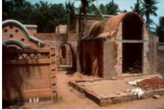
Fotoğraf 27: 6. Yapının pişirildikten sonra tamamlanması (Meeker, Mud, Web, 1991)
