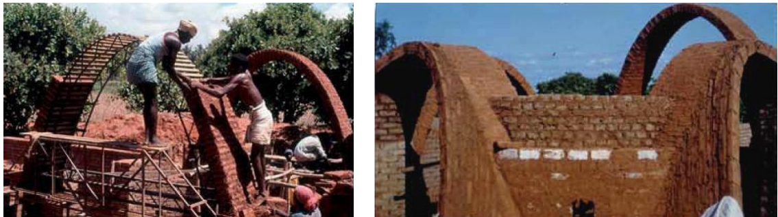
Fotoğraf 31: Mekanizmalı çelikten kemer kalıbı ve kubbeli orta odanın tonozlarla bağlantısı (Kundoo, 2008: 298)
