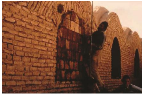
Fotoğraf 12: Duvardaki pencereler ve deliklerin harçsız kerpiç tuğlalar ile kapatılması (Khalili, Geltaftan Process, Web, 1982)
