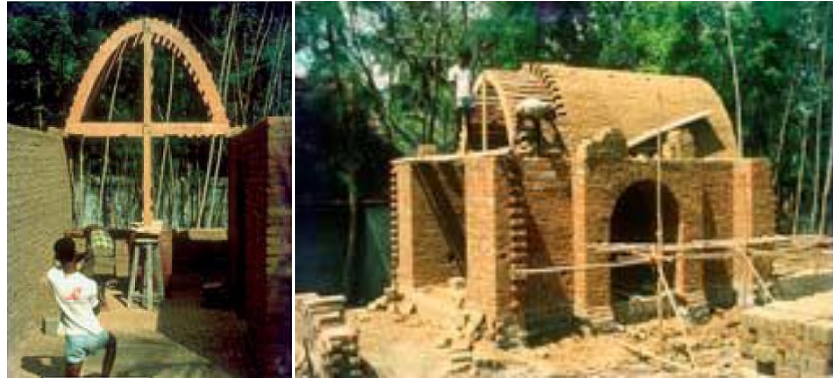
Fotoğraf 22: Ahşaptan taşınır kemer kalıbı ve tonozun inşa edilmesi (Kundoo, 2008: 292)
