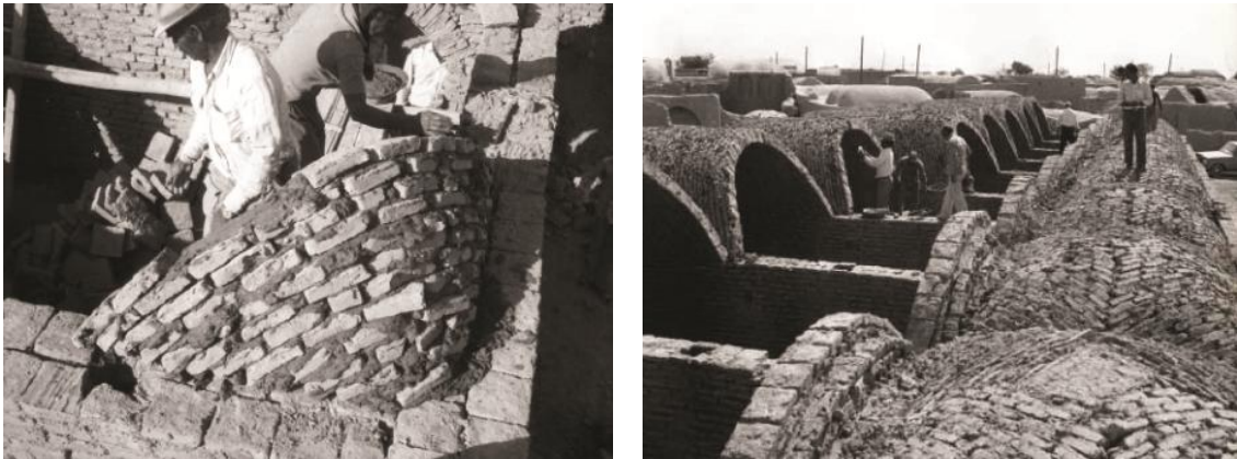
Fotoğraf 11: İran'da Javadabad ilkokulunun tonozları ve kubbelerinin inşası (Khalili, Geltaftan Process, Web, 1982)
