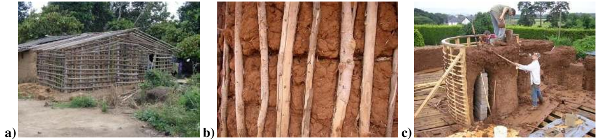
Fotoğraf 5: Omurgalı kerpiç duvar yapım tekniği
