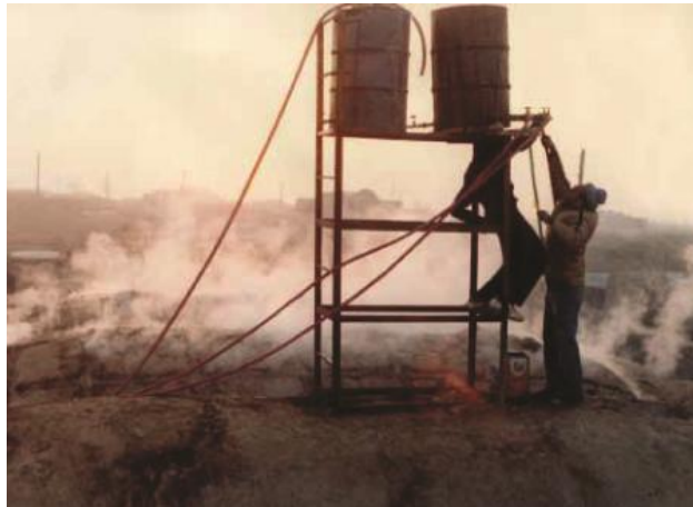
Fotoğraf 13: Yüksek alana yerleştirilmiş 2 gazyağı varili ve hortumların brülör ile bağlantısı (Khalili, Geltaftan Process, Web, 1982)
