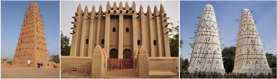
Fotoğraf 4: Hatıllı kerpiç örnekleri
