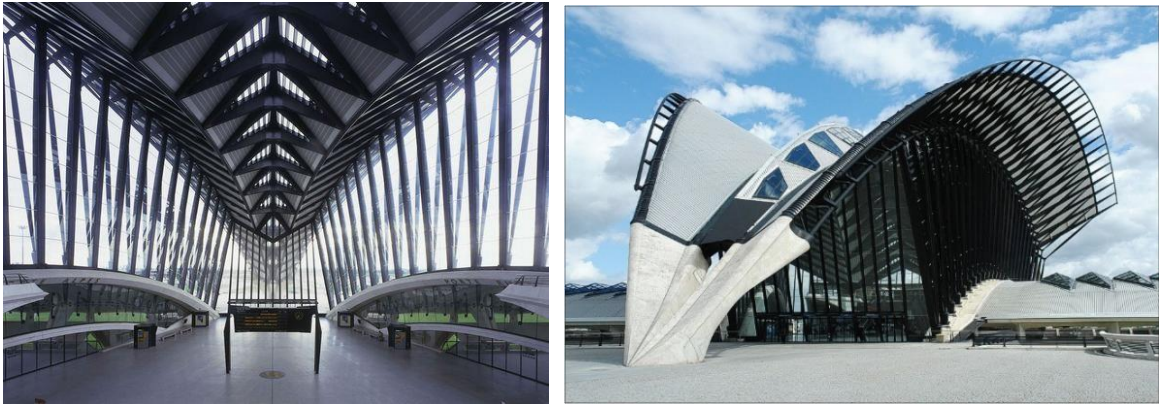
Şekil 4.40. Lyon-Saint Exupéry Havaalanı Tren İstasyonu iç mekân ve dış cephe strüktürü (URL-74, 2023; URL-75, 2023)
