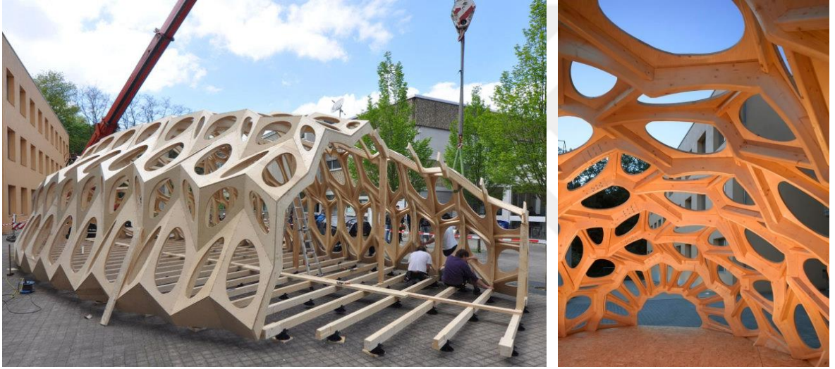
Şekil 4.47. Pop-Up Bowooss Bionic Research Pavilion yapım aşaması (1) ve ahşap kabuk birleşim detayı (URL-76, 2023)
