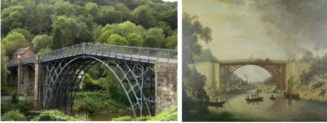
Şekil 2.6. Coalbrookdale Severn Irmağı köprüsü, Abraham Darby, 1779, Coalbrookdale (Serdar, 2023)
