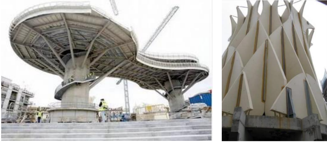
Şekil 4.27. The Metropol Parasol betonarme çekirdek ve ahşap taşıyıcı inşası (URL-63, 2023)
