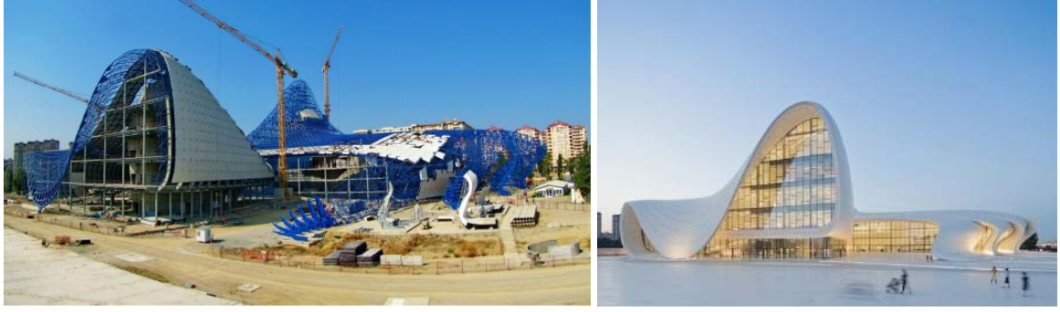
Şekil 2.24. Haydar Aliyev Kültür Merkezi yapım aşaması ve binanın bitmiş hali (URL-7, 2022)
