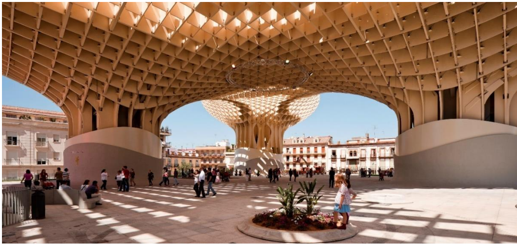
Şekil 4.26. The Metropol Parasol yapısının mantar gövdesi hiflerine benzeyen taşıyıcı ve üst örtüsü (URL-60, 2023)
