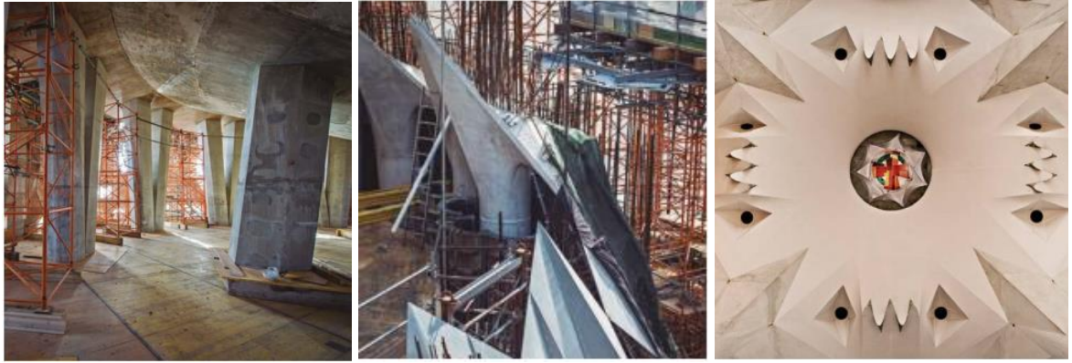
Şekil 4.33. Sırasıyla kule, sütun ve neflerde beton kullanımı (Anonim, 2023)
