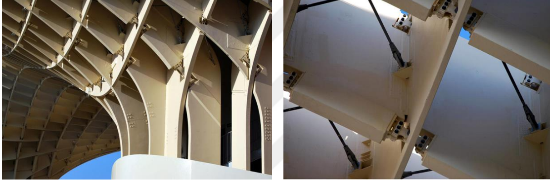
Şekil 4.28. The Metropol Parasol ahşap birleşim detayları (URL-64, 2023)
