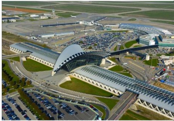
Şekil 4.34. Lyon-Saint Exupéry Havaalanı Tren İstasyonu (URL-71, 2023)
