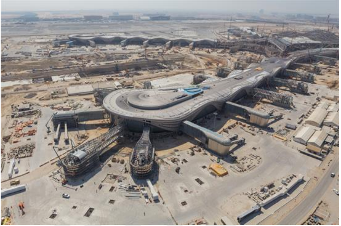
Görsel 4.28. Abu Dabi Havalimanı çalışan pistler arasında şantiyenin havadan görünüşü (Busson, 2015)
