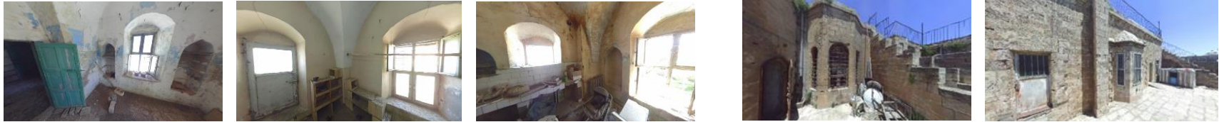
İç mekan detayları
