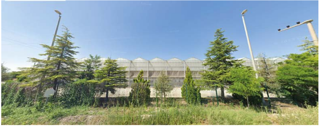
Şekil 37: Torku Ultra Isıtmalı Sera cephesi ve yağmur olukları detayı (Ahmet Fazıl Bayrakçı arşivinden)
