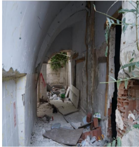
Resim 13. Tonozlu Mahzen Yapısı
