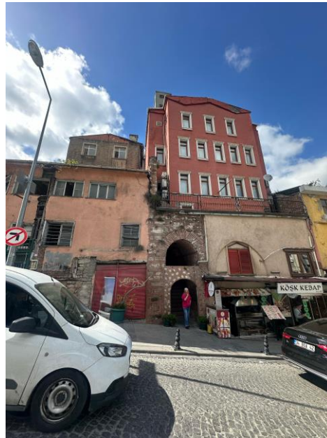
Resim 8. Tonozlu Merdiven Yapısı
