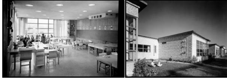
řekil 4.36. Crow Island Elementary School, İ cephe grseli ve L sınıf yarı zel avlusu (Perkins ve Will, 2025)
