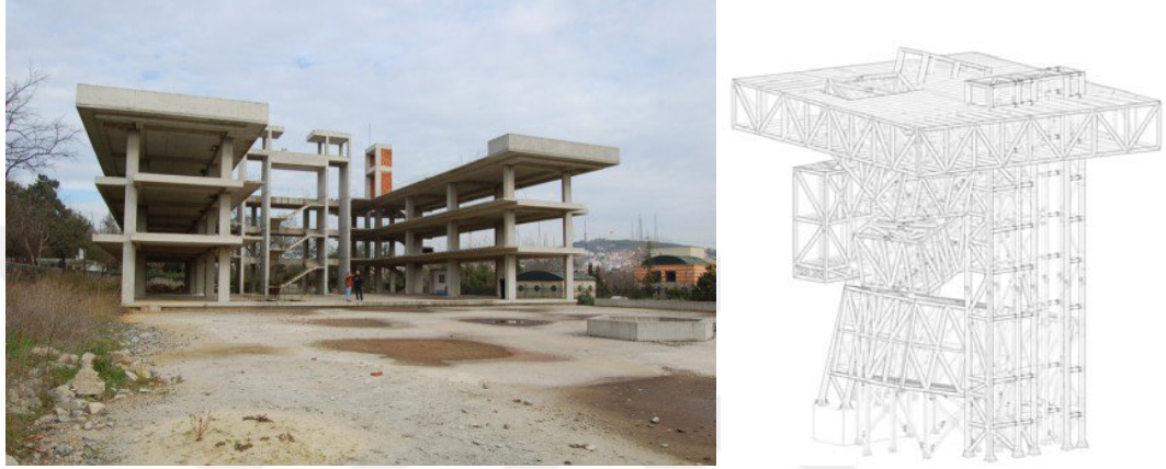
Şekil 3.10: Nakkaştepe'deki kullanılmayan otel yapısı ve REX'in daha önceden hayata geçiremediği Annenberg Merkezi (Url-37).
