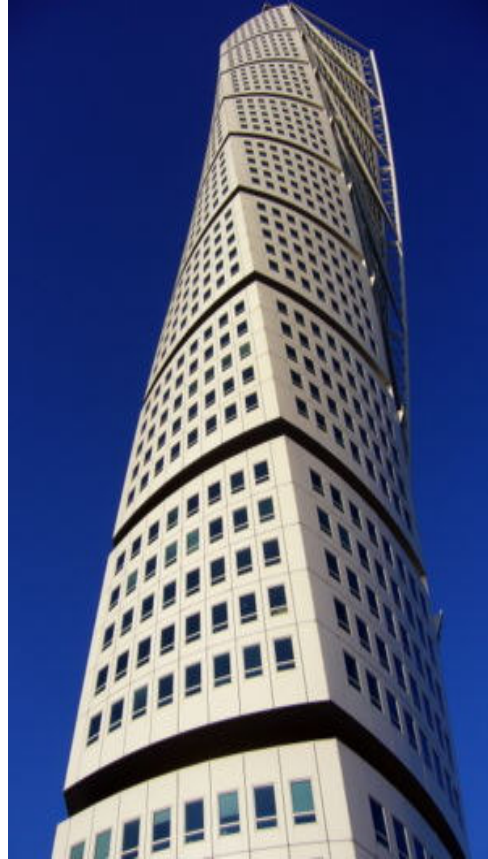
Şekil 4.29 Turnig Torso Dış Cephe
