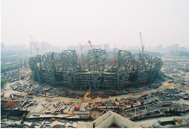
Şekil 4.27 Stadyum yapım aşamasından bir görünüş
