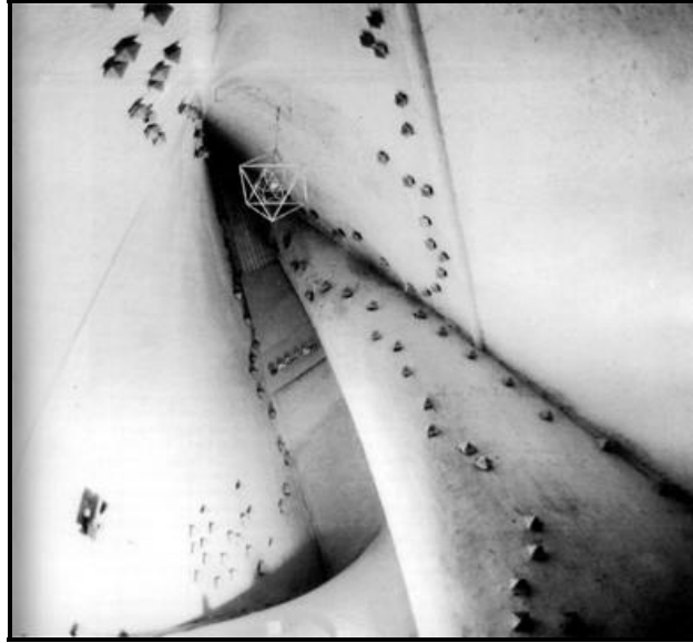
Şekil 3.7 Poémé Electronique gösterisi için Philips Pavyonu'na yerleştirilen hoparlör sistemi, mimar ve kompozitör: Iannis Xenakis
