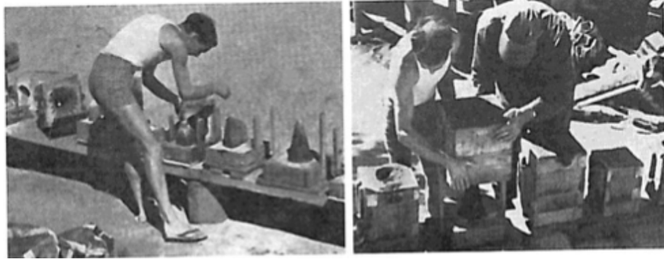
Şekil 4.6 : Soleri’nin Cosanti’de ürettiğı toprak kalıp Çanlar, 1970’ler. [URL-19]
