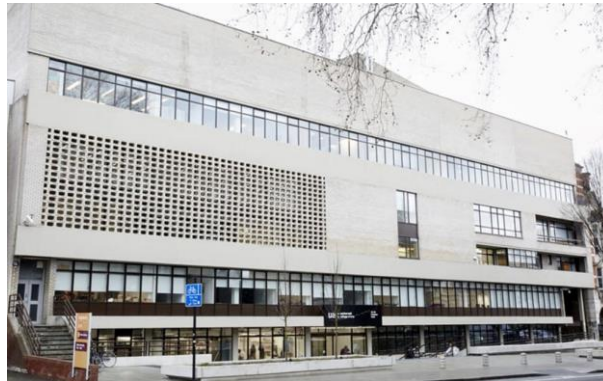
Şekil 10. Camverwell Sanat Koleji dış cephe görüntüsü (URL-56, 2025)
