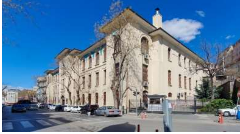
Resim 4. Eski Ankara Adliye Binası.
