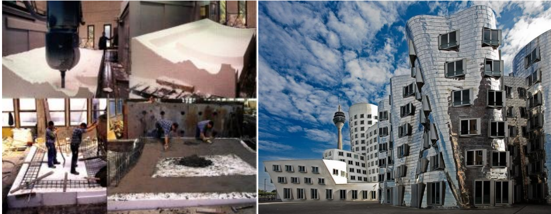
Resim 4.4. Beton panellerin kalıbı için köpüğün oyulması, Zollhof Towers in Dusseldorf, Almanya, Gehry, 1999 [36]
