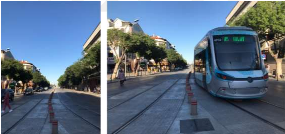
Şekil 5.10. Konya Katanersiz Tramvay yolu
