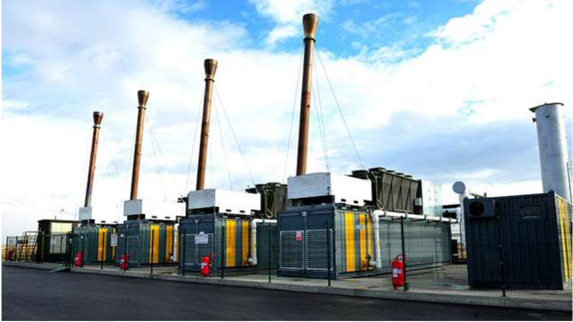
Şekil 5.16. Katı Atık Tesisinde Metan Gazından Elektrik Üretimi (Url 50)
