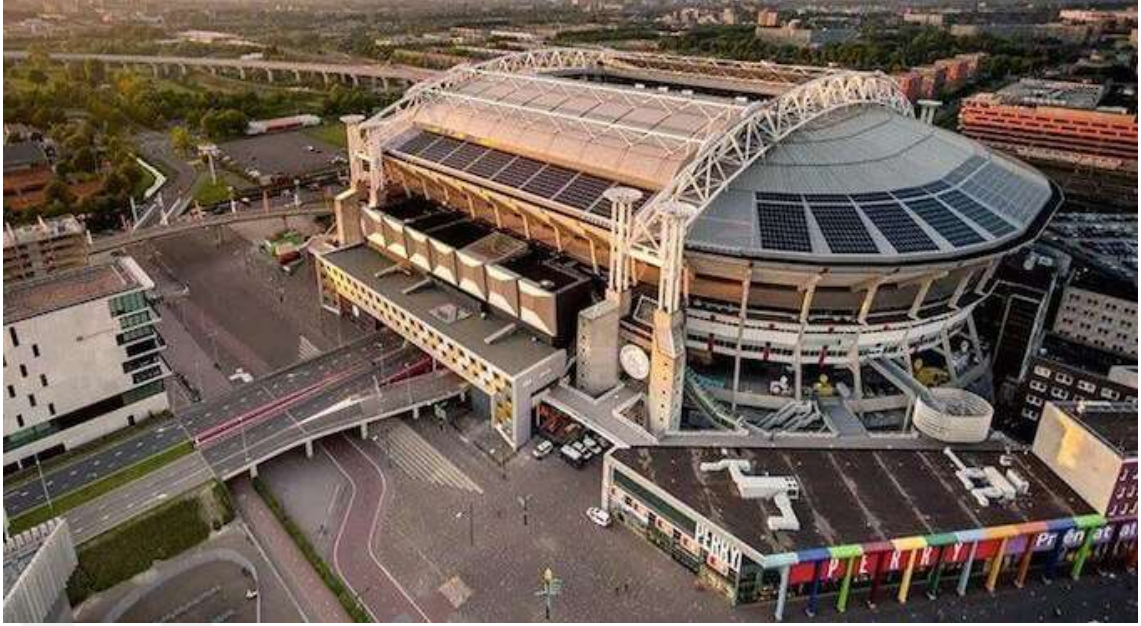
Şekil 4.4. Johan Cruijff Stadyumu dış cephe güneş panelleri (Url 12)
