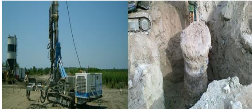
Şekil 3.11. JG makinesi ve oluşan JG kolonu
