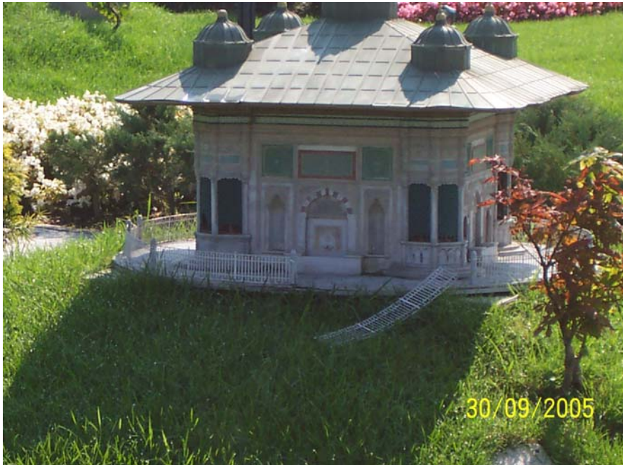
Şekil 26. III. Ahmet Çeşmesinde Görülen Hasar Örneği (KUTAY, 2005).
