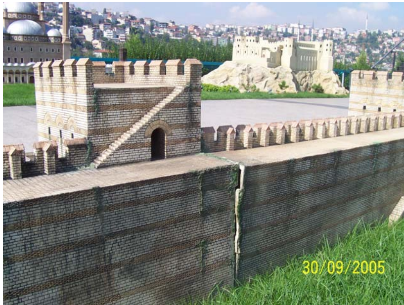
Şekil 23. İstanbul Surlarının Üzerinde Oluşan Çatlaklar (KUTAY, 2005).
