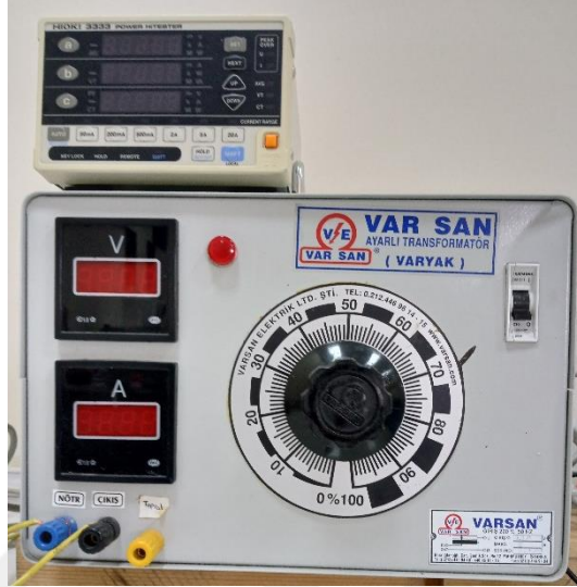
Şekil 3.12. Doğru akım güç kaynağı ve analizörü
