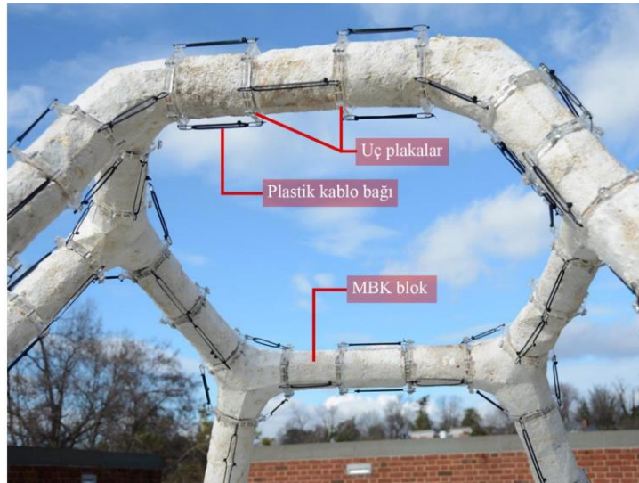
Şekil 89. MBK blokların bağlantı tekniği (Luo, 2022)
