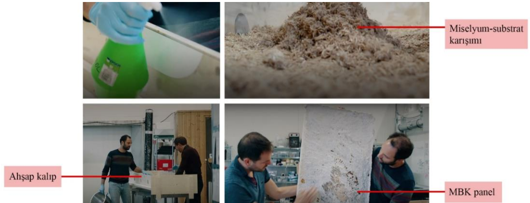
Şekil 64. MBK cephe panellerinin kalıplanması (Company New Heroes, 2019a)
