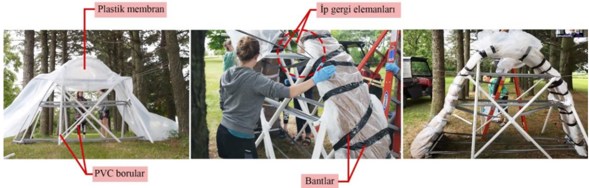
Şekil 50. Mycoarch kalıplama yöntemi (Yaşar University Faculty of Architecture, 2021; Jensen, 2017)
