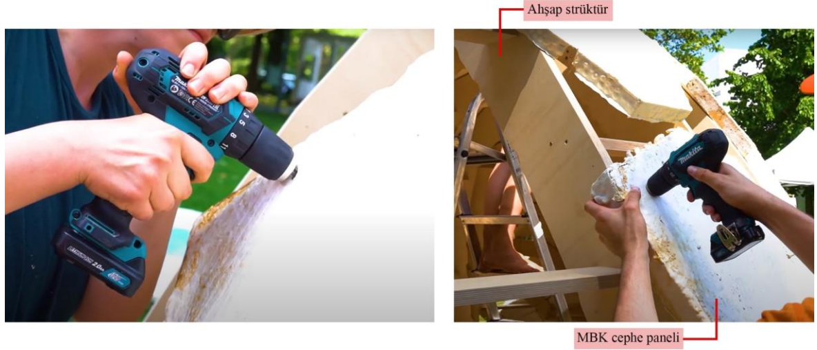
Şekil 81. Çivi ile bağlantı tekniği (Vera Meyer | V. meer, 2021a)
