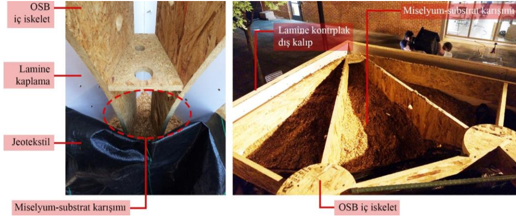
Şekil 97. Miselyum-substrat karışımının kalıplara aktarılması (Miller, 2018)
