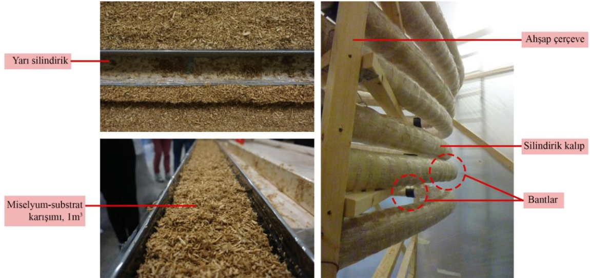
Şekil 67. Ters katener MBK kemerlerin kalıplama süreci (AGI, 2019; Descalzi ve diğerleri, 2019)
