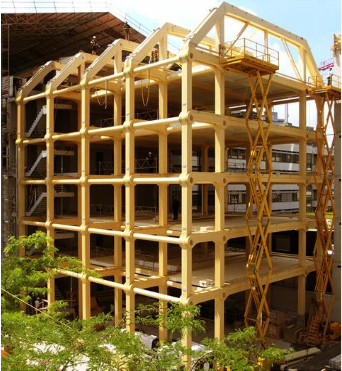
Görsel 5.27. Shigeru Ban, Tamedia New Office Building, Zürih, İsviçre, 2013. Ahşap Strüktür Sistem ( http-38 )
