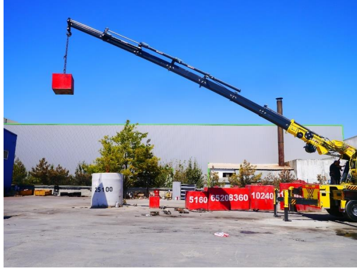
Şekil 4.1. Mobil vinç bomlarının fotogrametrik ölçüm çalışması (MPG A.Ş. Mobil Vinç Test Alanı)
