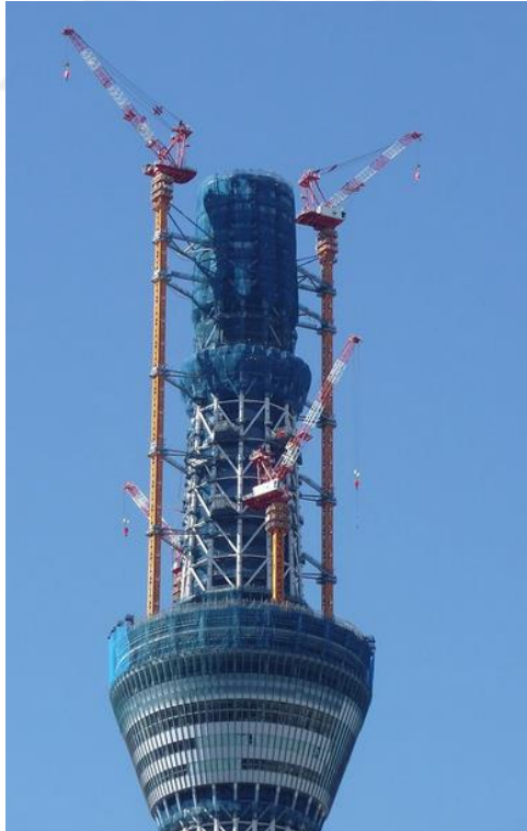
Şekil 3.7. Kuyruksuz kule vinç uygulama örneği
