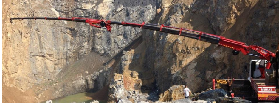
Şekil 3.21. 115 ton metre kaldırma kapasiteli mobil hidrolik vinç
