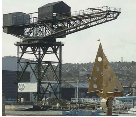
Şekil 3.9. Dev kirişli kule vinç uygulama örneği
