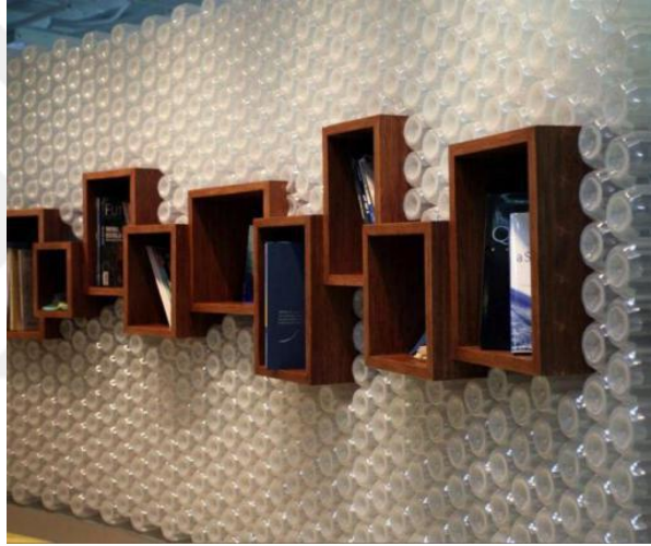
Görsel 3.2.4. Polli-Brick sistemi iç mekan yüzey uygulaması,
