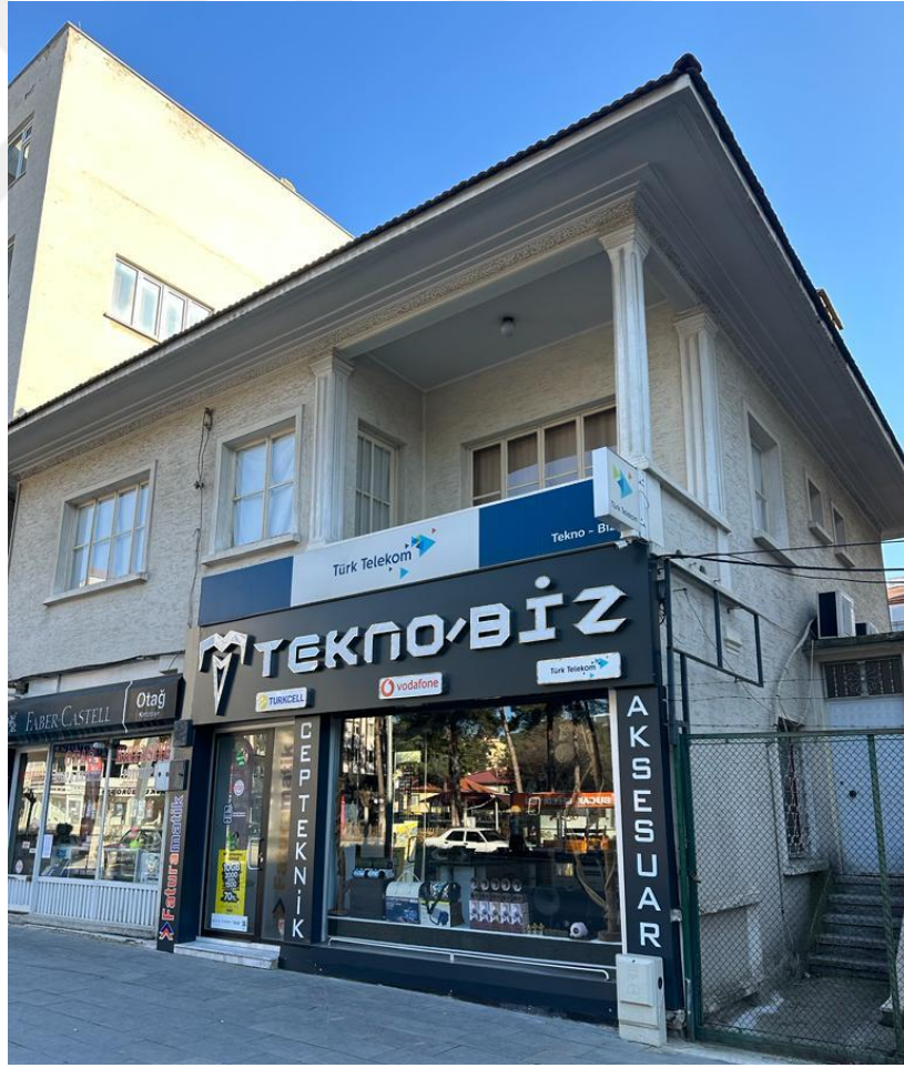
Şekil 4.88. 1324 ada 5 parselde bulunan konut
