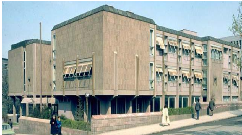
Şekil 2.19. 1967, Türk Tarih Kurumu Binası, Ankara (Yıldırım, 2007)
