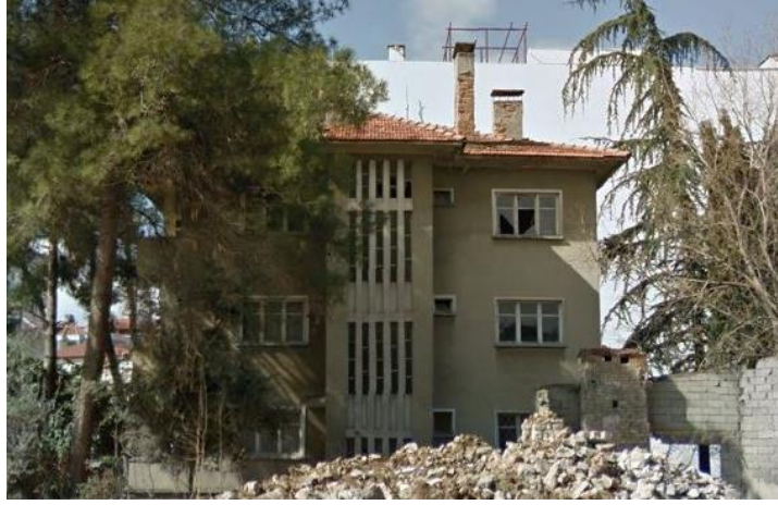
Şekil 4.106. 1825 ada 4 parselde bulunan konut
