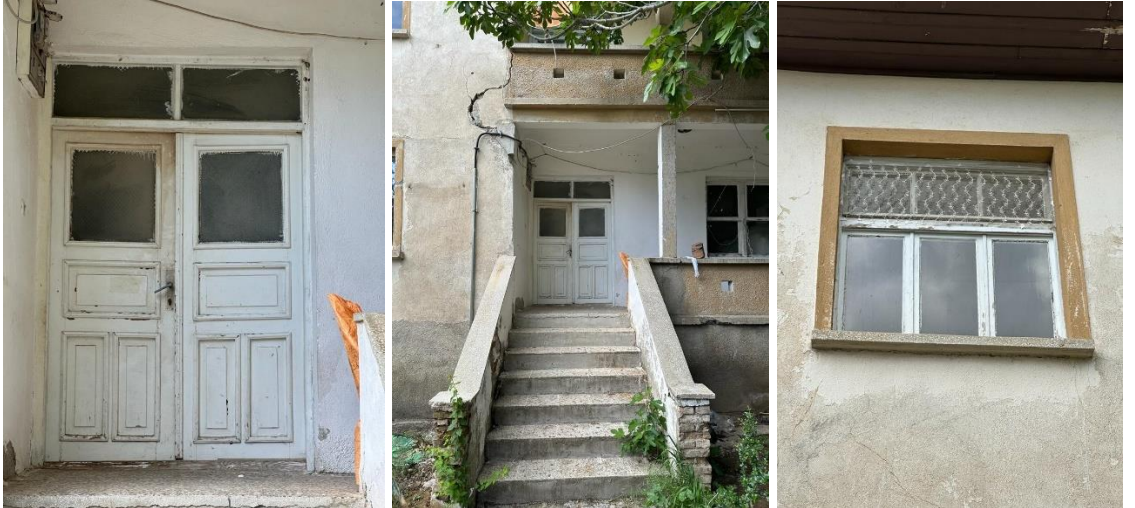
Şekil 4.85. 1324 ada 8 parselde bulunan konutun özgün giriş kapısı ve pencere doğramaları
