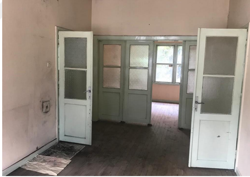
Şekil 4.94. Sezen Villa iç mekân camekanı
