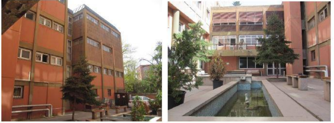
Şekil 2.22. Türk Tarih Kurumu Binası'nın açık avlusu (Akdoğan, 2019)
