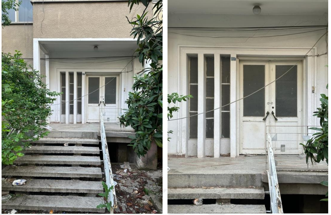
Şekil 4.110. 1825 ada 4 parselde bulunan konutun girişi
