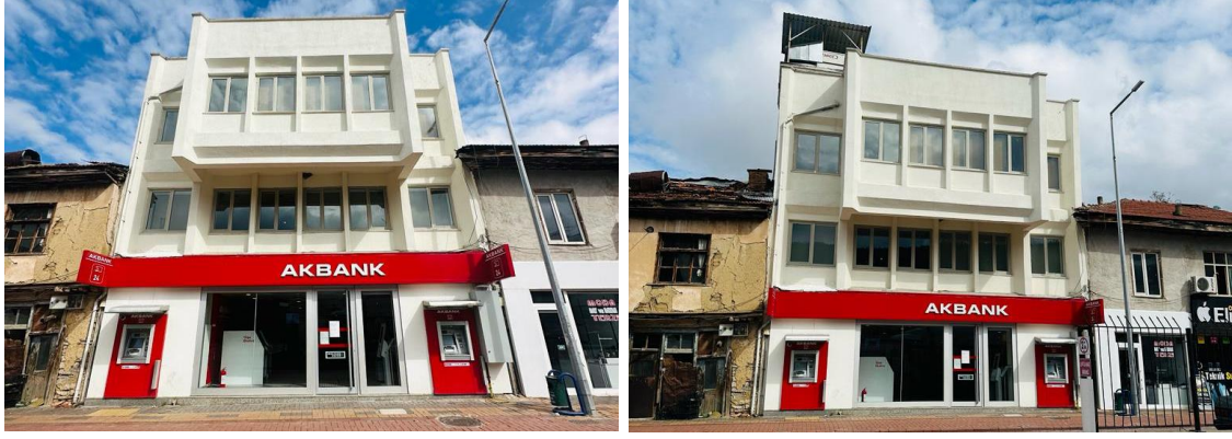
Şekil 4.126. 143 ada 18 parselde bulunan banka ve lojman yapısı
