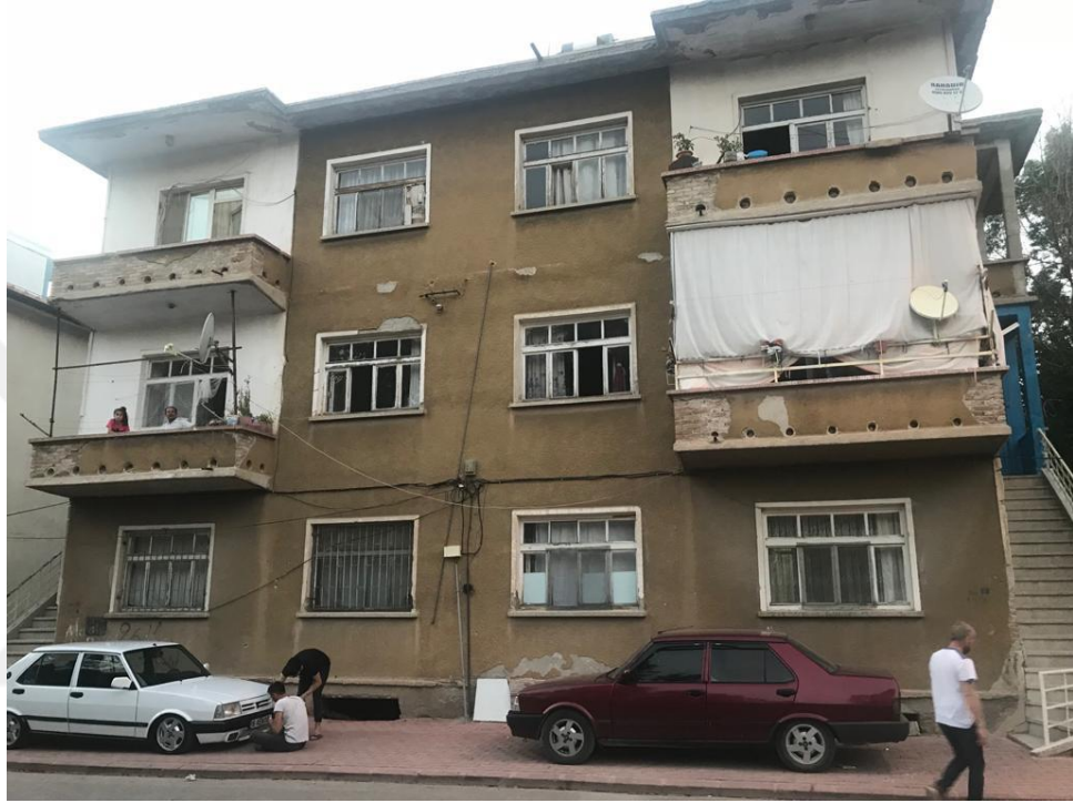
Şekil 4.101. 273 ada 16 parselde bulunan konut
