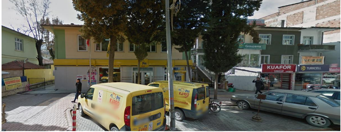
Şekil 4.67. Bucak Postane Binası (Google Maps, t.y.b)
