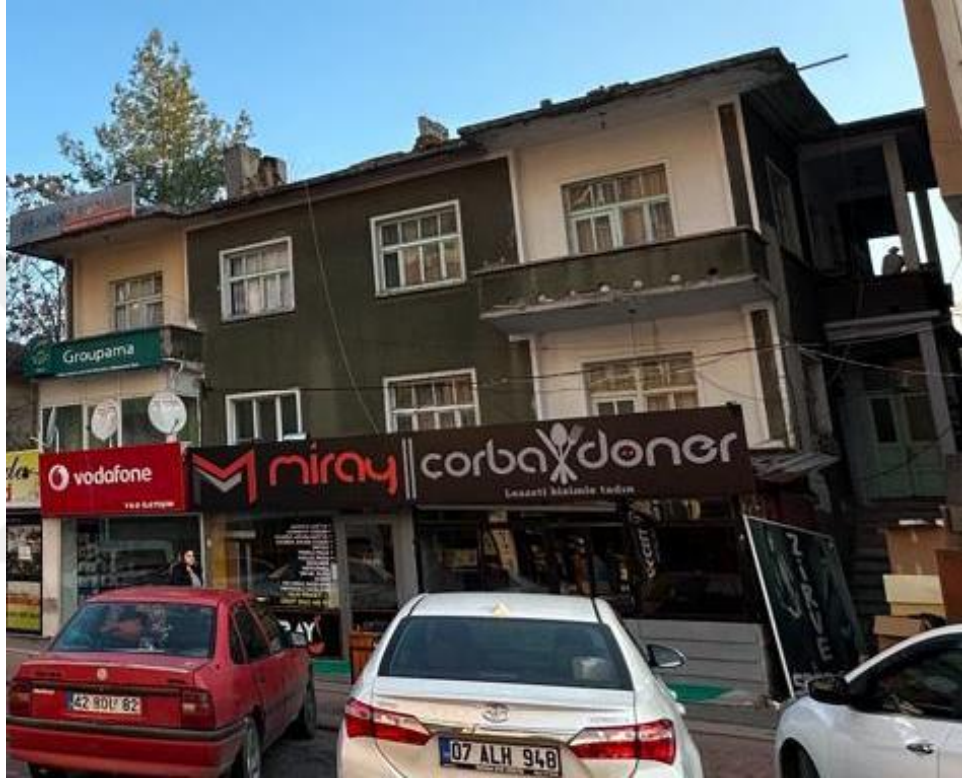
Şekil 4.97. 273 ada 9 parselde bulunan konut
