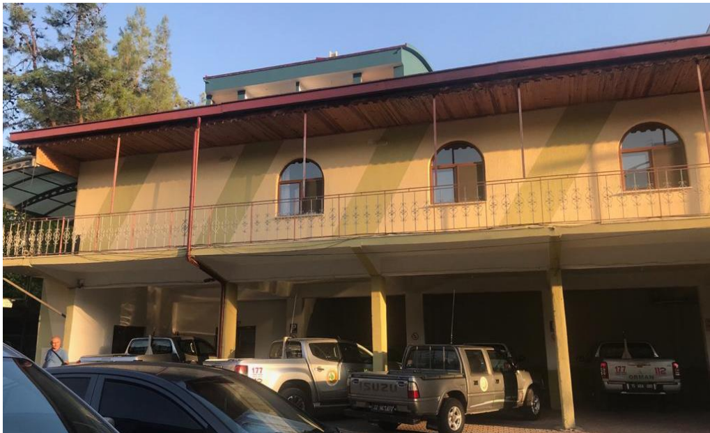
Şekil 4.43. Bucak Orman İşletme Yemekhane Binası
