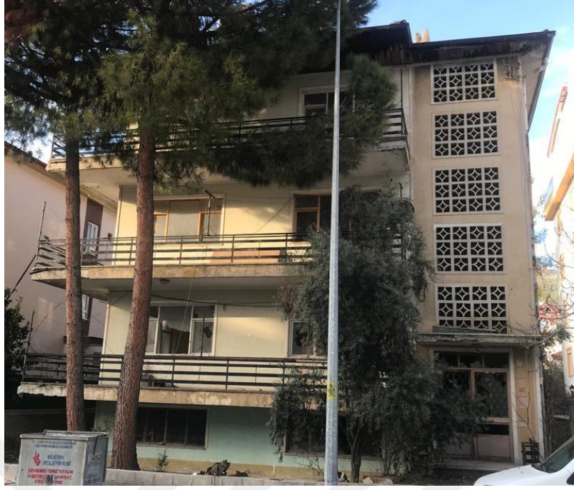
Şekil 4.117. 1323 ada 16 parselde bulunan konut
