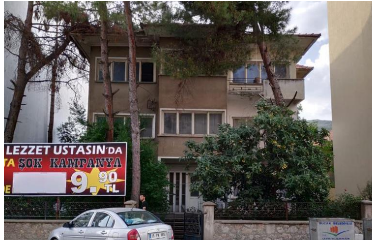
Şekil 4.105. 1825 ada 4 parselde bulunan konut
