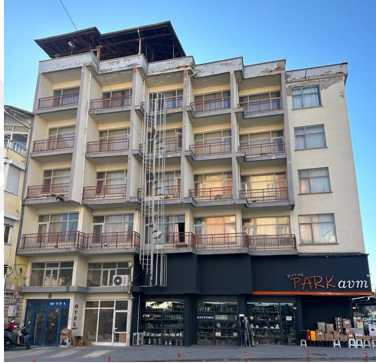
Şekil 4.135. 1573 ada 5 parselde bulunan otel yapısı
