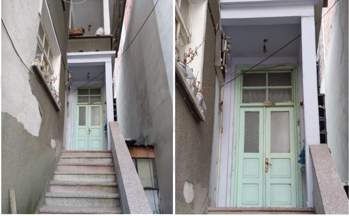
Şekil 4.98. 273 ada 9 parselde bulunan konutun girişi
