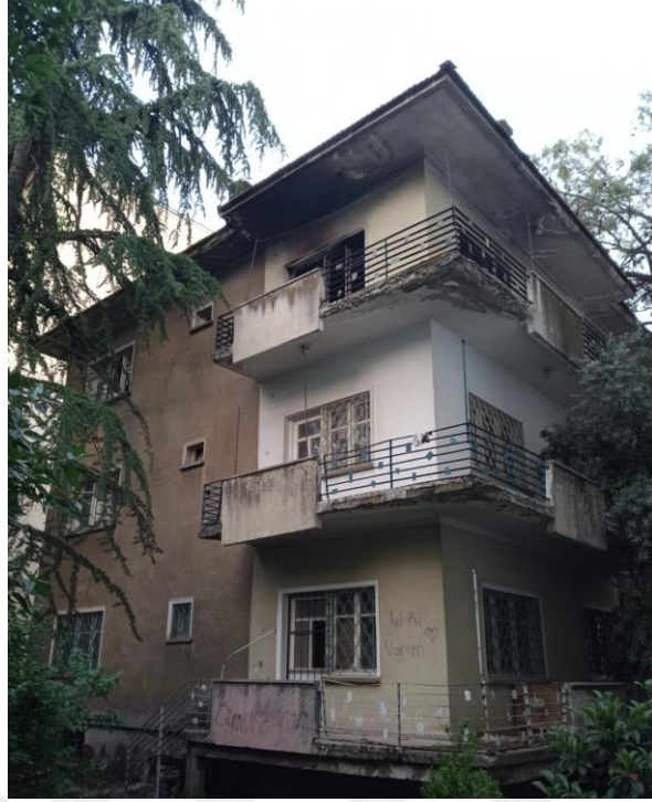
Şekil 4.107. 1825 ada 4 parselde bulunan konut
