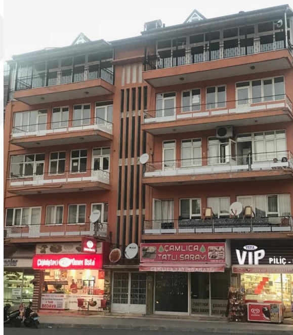
Şekil 4.122. 123 ada 9 parselde bulunan konut
