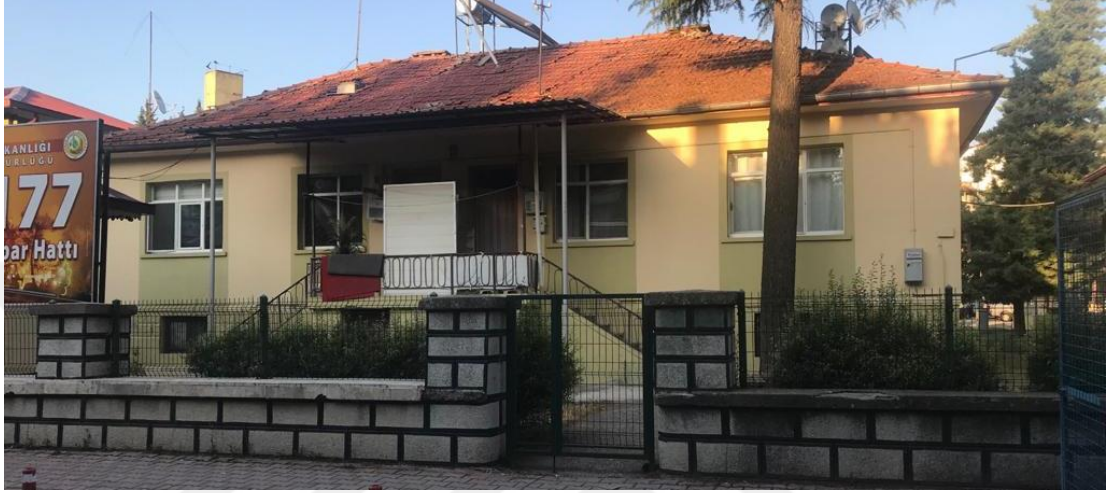
Şekil 4.37. Bucak Orman İşletme Lojman Binası
