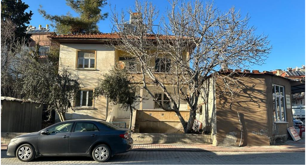
Şekil 4.82. 1324 ada 8 parselde bulunan konut
