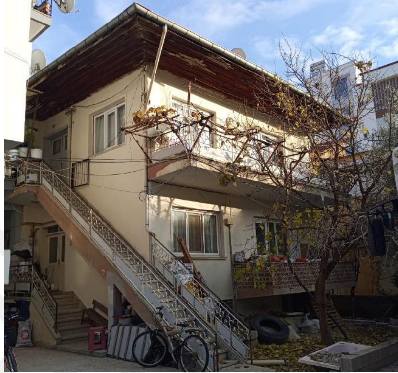
Şekil 4.79. 1323 ada 23 parselde bulunan konut
