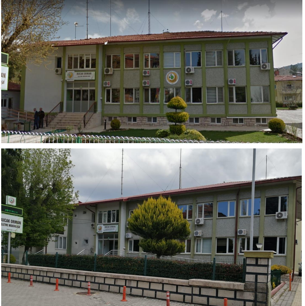
Şekil 4.34. Bucak Orman İşletme Müdürlük Binası
