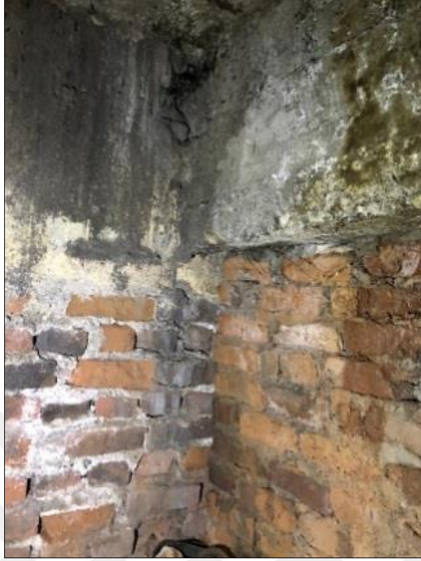
řekil 4.91. Salon 6 makine dairesinde neme baęlı oluřan bozulmalar
