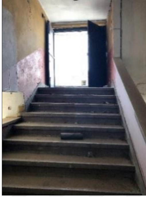
Şekil 4.68. Terasa Çıkan Merdiven
