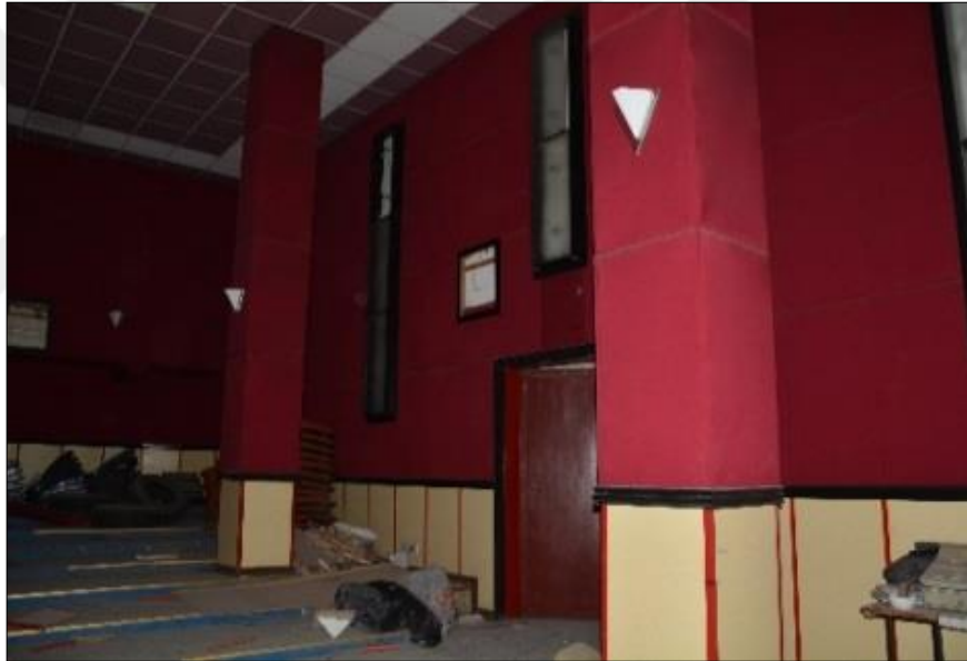
Şekil 4.23. Dilan Sineması Salon 2 Mevcut Durumu
