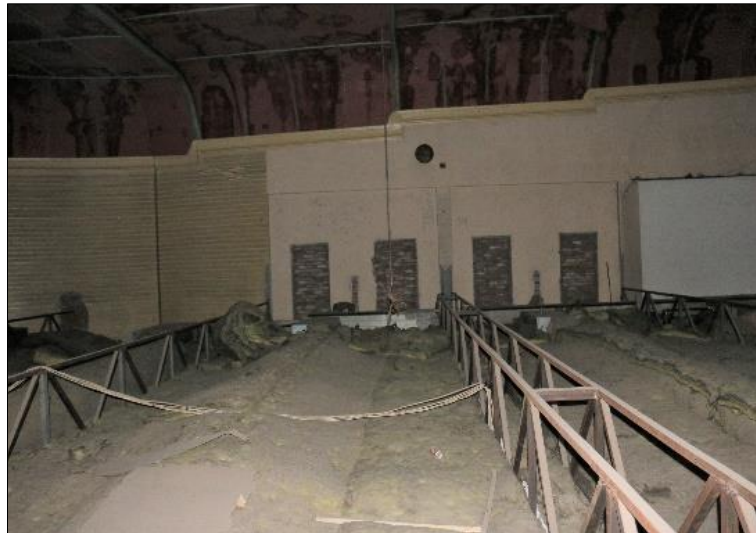
Şekil 4.105. Loca katında bulunan kapıların tuğla malzemeyle kapatılması
