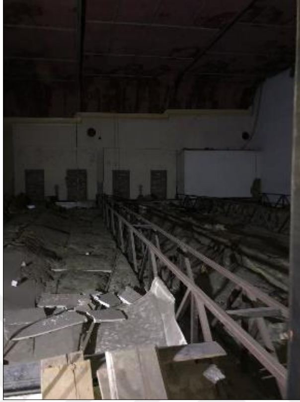
Şekil 4.97. Uzay sistemle geçilmiş loca katı
