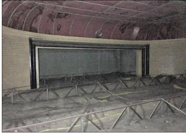
Şekil 4.98. Uzay sistemle geçilmiş loca katı
