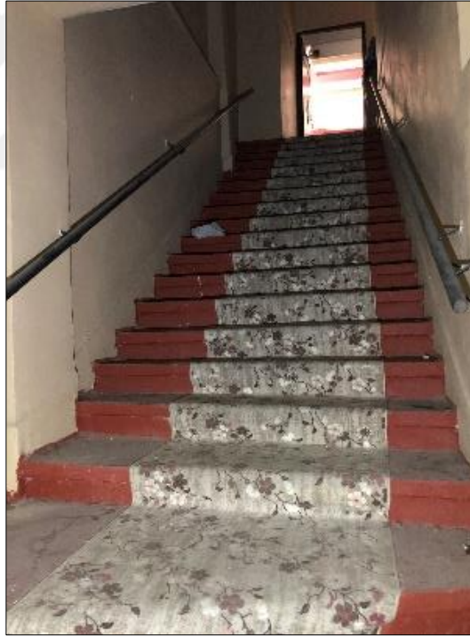
Şekil 4.83. Site Sineması salonları girişleri ve kapatılan merdiven
