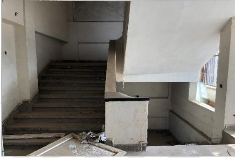
Şekil 4.74. Site sineması çatı katına çıkan merdiven
