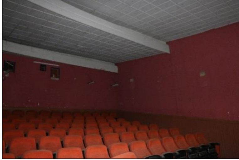
Şekil 4.59. Site Sineması Salon 6’nın Mevcut durumu
