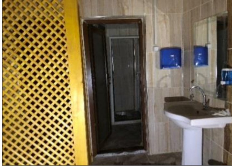
Şekil 4.88. Site Sinemasındaki ticari birimlere eklenen mekânlar
