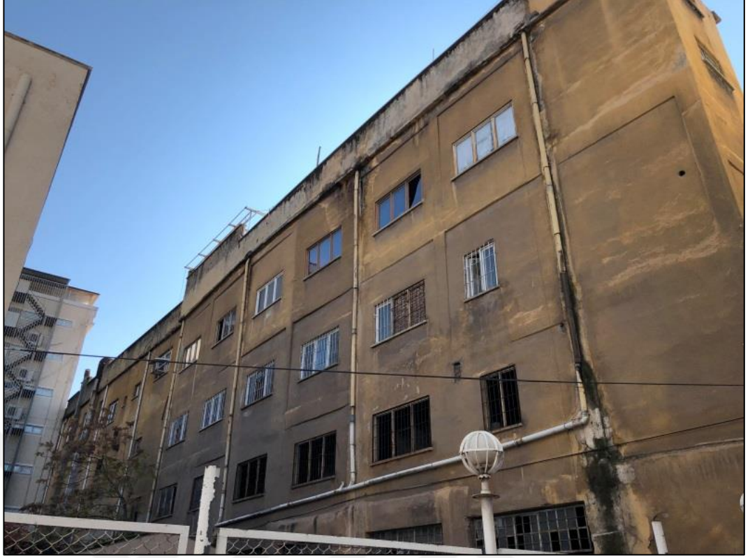
Şekil 4.20. Dilan Sineması' nın kuzeydoğu cephesi
