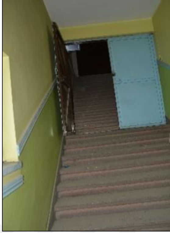
Şekil 4.45. Dilan Sineması Lojman Merdiveni
