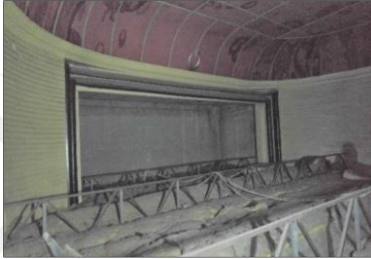
Şekil 4.104. Loca katında yapılan makas sistem
