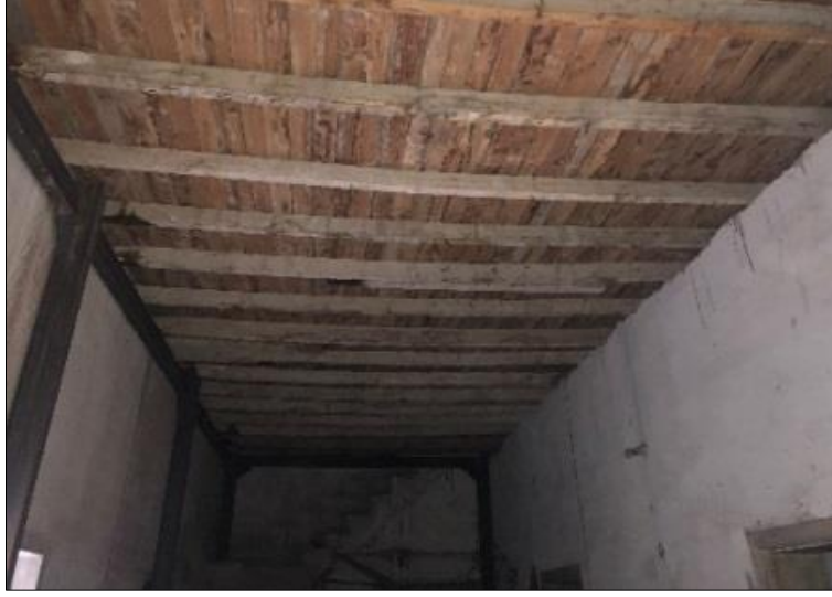
Şekil 4.71. Dilan Sineması Zemin katına çıkılmasını sağlayan ve üstü ahşap kirişli döşemeyle kapatılan merdiven
