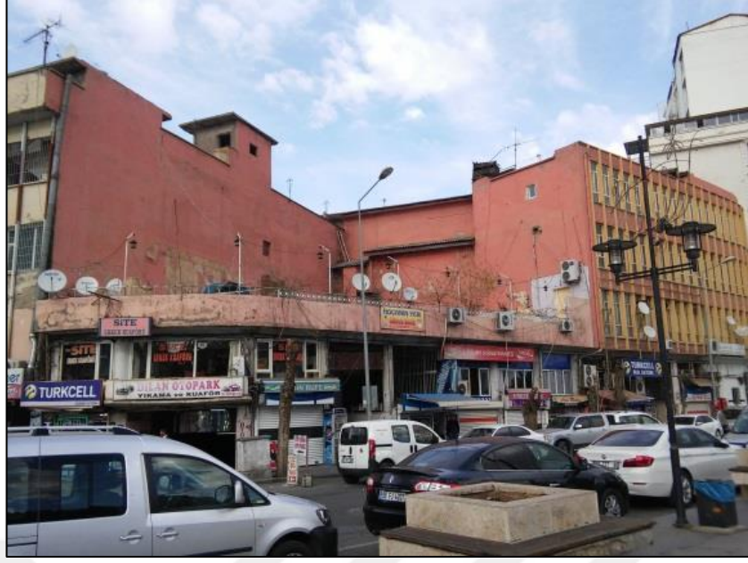
Şekil 4.18. Dilan Sineması yazlık bölümdeki saçak (Arşiv Fotoğrafı)
