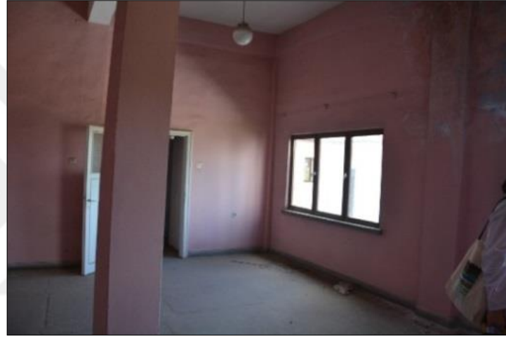
Şekil 4.43. Dilan Sineması Lojman katı mevcut durumu
