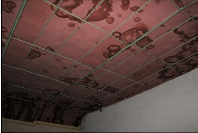
řekil 4.115. Üst örtüde neme baęlı oluřan bozulmalar
