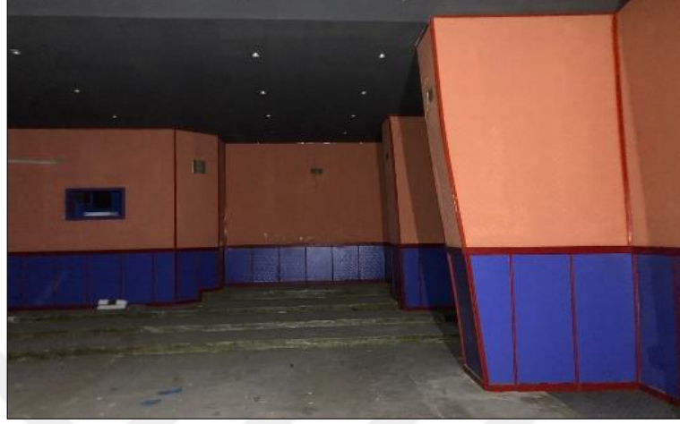
Şekil 4.54. Site Sineması Salon 4'de bulunan taşıyıcı kolonlar
