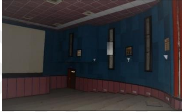
Şekil 4.25. Dilan Sineması Salon 3 Mevcut Durumu
