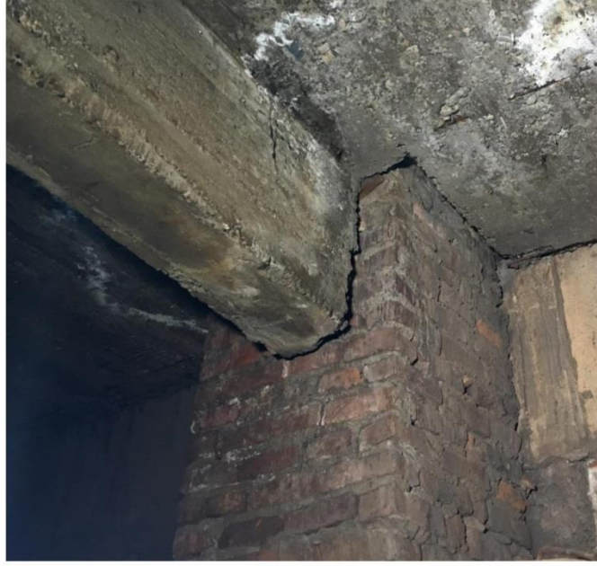
Kolon Formunda Yığma Yapı İçin Taşıyıcı Eleman
