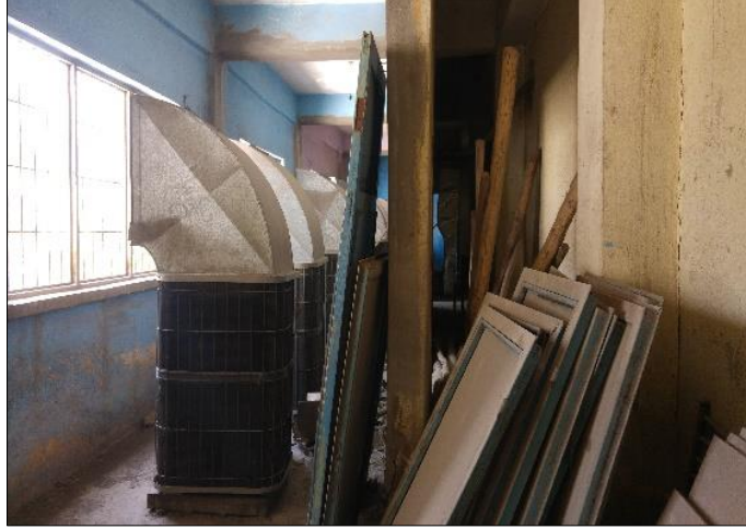
Şekil 4.109. Ahşap pencere ve kapılarda Bakımsızlık ve kullanıcı etkisiyle meydana gelen bozulma
