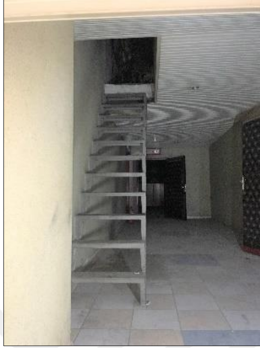
řekil 4.84. Salon 6 makine dairesine ulaşmak için eklenen metal merdiven
