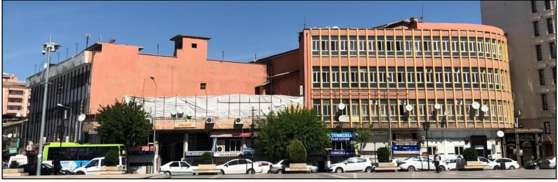
Şekil 4.15. Dilan Sineması' nın Güneydoğu Cephesi
