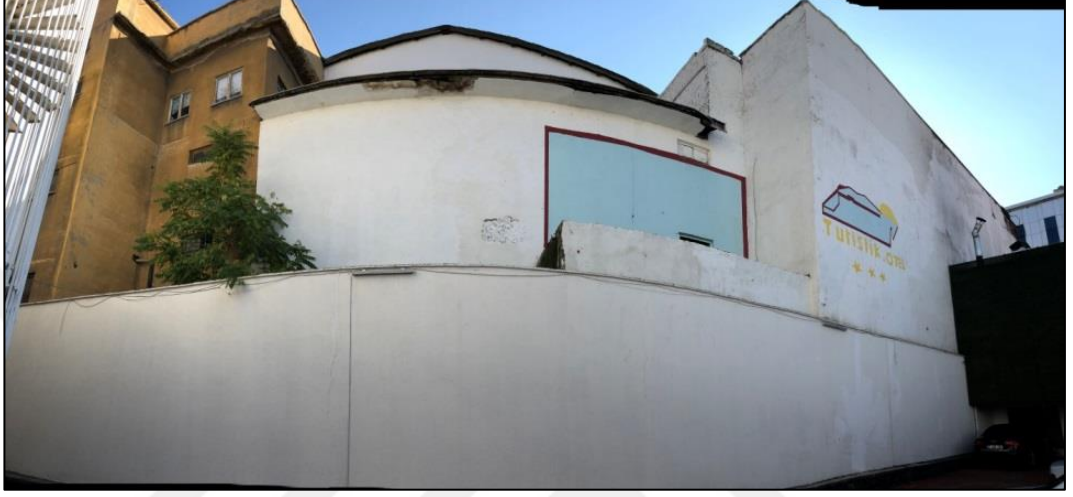
Şekil 4.19.Dilan Sineması ve Site Sineması' nın kuzeybatı cephesi
