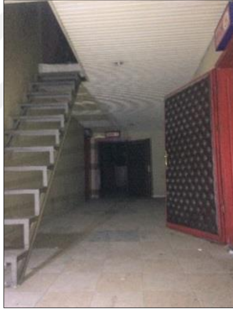
Şekil 4.60. Makine Dairesi Merdiveni
