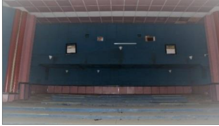
Şekil 4.24. Dilan Sineması Salon 3 Mevcut Durumu
