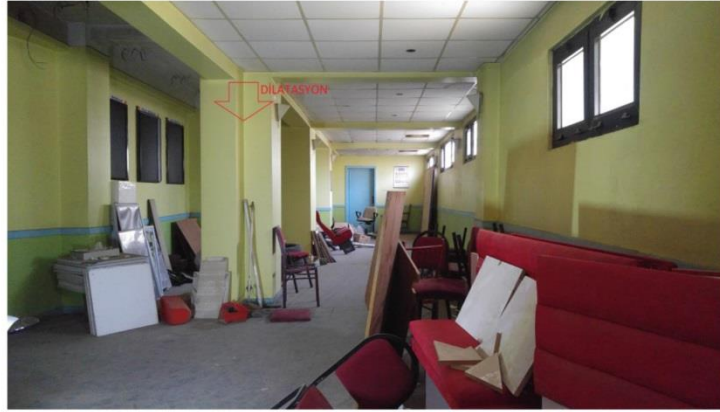
Fuga Konulmadan Tesis Edilmiş Dilatasyon ( Gizlenmiş )
