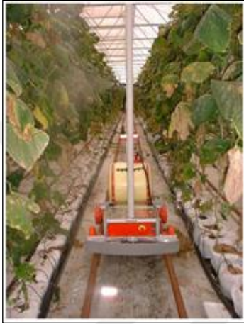
Şekil 2.2. Isıtma boruları üzerinde çalışan sera robotu (Sammons vd. 2005)
