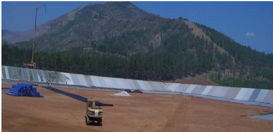
Şekil 2.20. Düzenli depolama lotları geotekstil serilmesi (Anonim 2017j)
