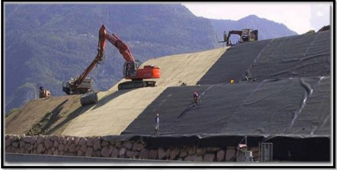
Şekil 2.7. Geomembran serilmesi (Anonim 2016a)
