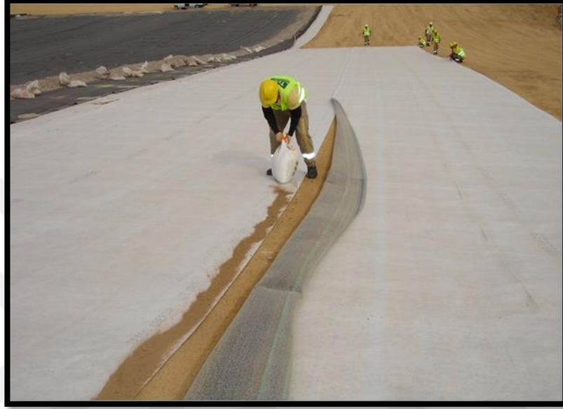
Şekil 2.17. Geosentetik kil şiltenin serilmesi (Anonim 2017h)
