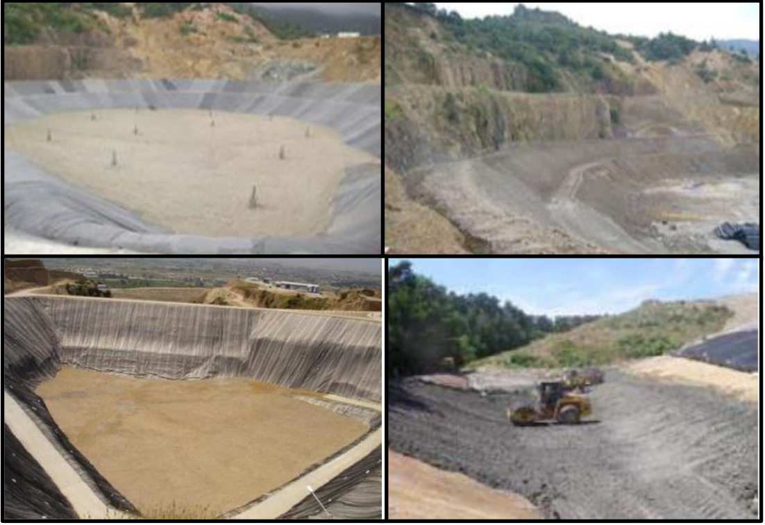
Şekil 2.6. Düzenli depolama sahasının hazırlanması (Anonim 2011a)
