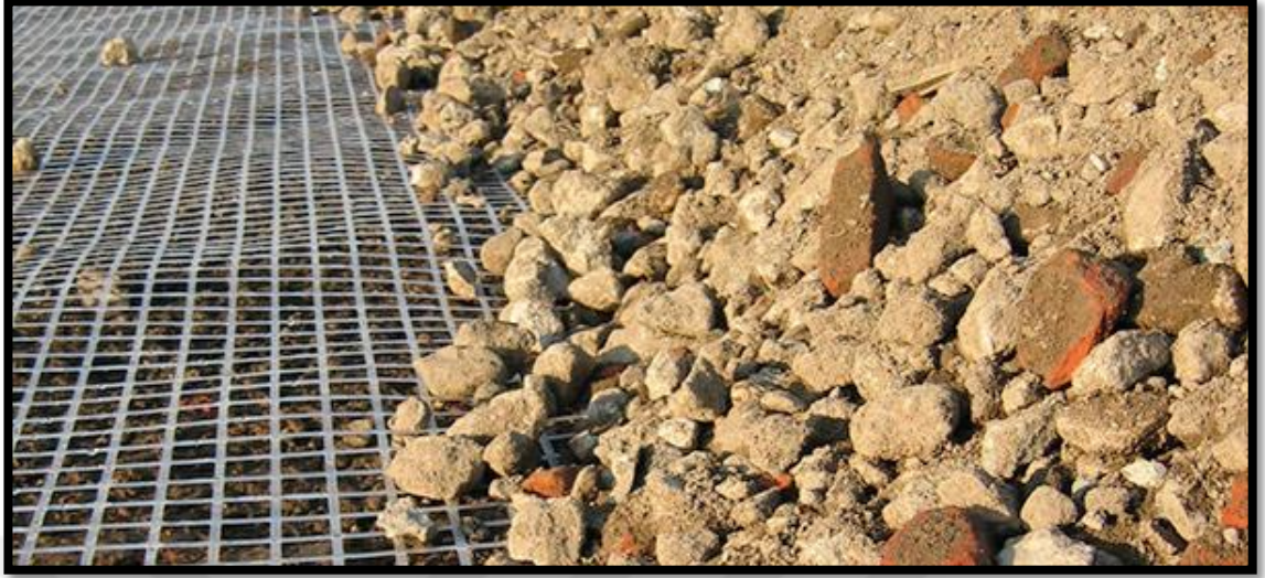
Şekil 2.23. Geogrid uygulaması (Anonim 2017 l)
