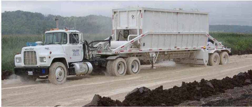
Şekil 2.27. Uçucu külün yol stabilizasyonunda kullanılması (Öksüz 2006)
