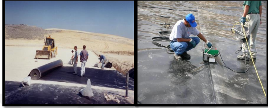
Şekil 2.18. Geomembran serilmesi ve kaynak işlemi (Anonim 2016b)
