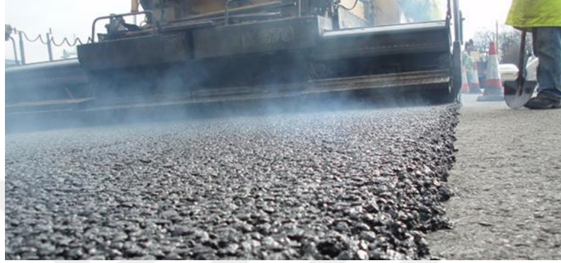
Şekil 2.3. TMA'nın yola döşenmesi [40].
