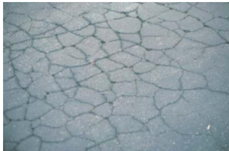
Şekil 1.25. Yorulma çatlağı [28].
