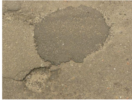
Şekil 1.29. Yoldaki yama [32].
