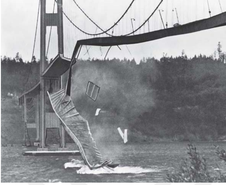
Şekil 2.4. Yıkılmış Tacoma Köprüsü (1940) [8]
