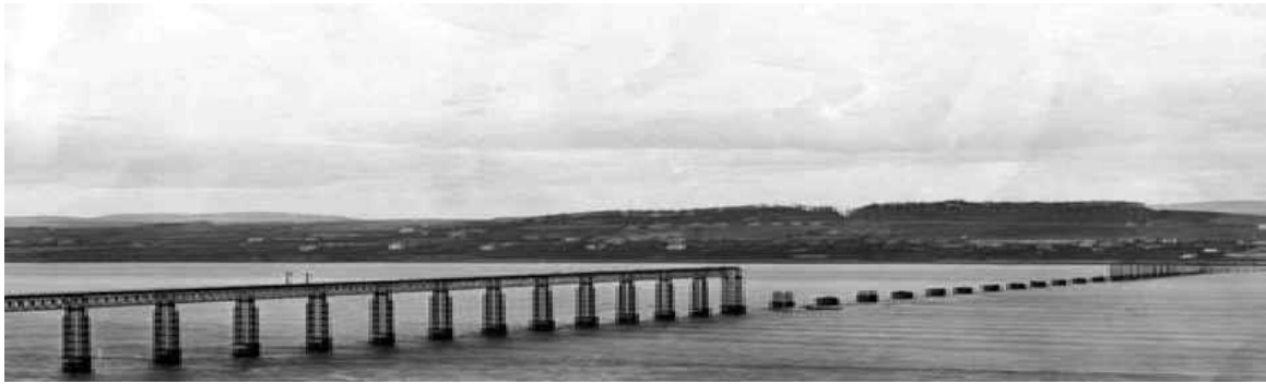
Şekil 2.3. Yıkılmış Tay Köprüsü (1879) [7]
