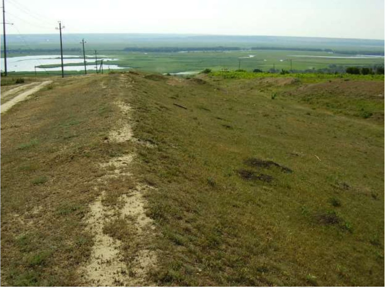
a. Trajan Duvarı
