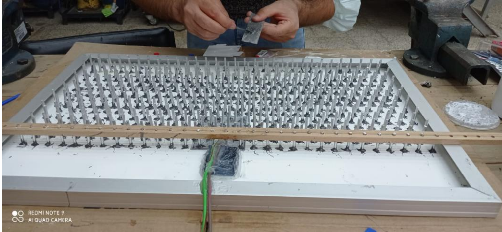
Şekil 6.2. Silindirik kanatçıkların panele yapıştırılması
