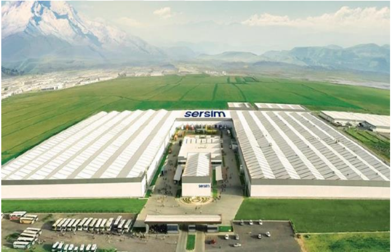
Şekil 3.1. Sersim fabrika genel görünüm.
