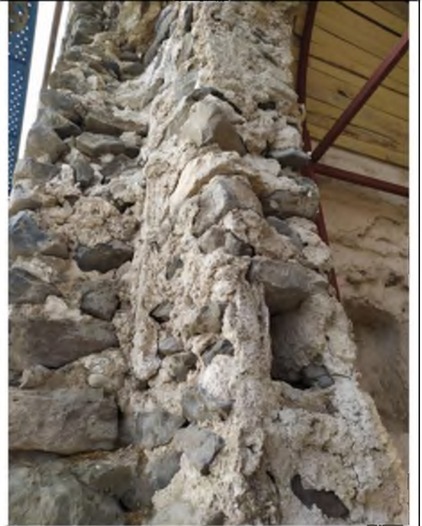
Numune kodu: MK-H2 Alındığı bölge: Ana giriş kapısı dış cephe
