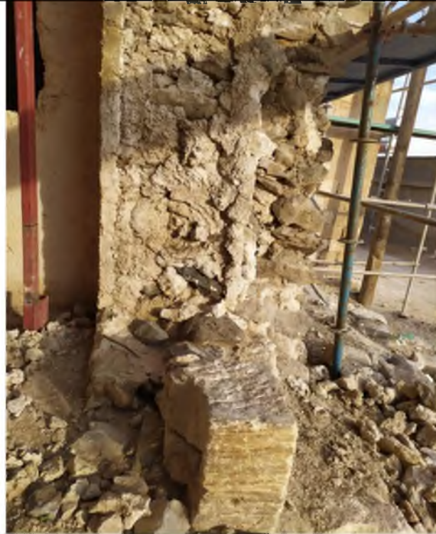
Numune kodu: MK-H1 Alındığı bölge: Ana giriş kapısı dış cephe
