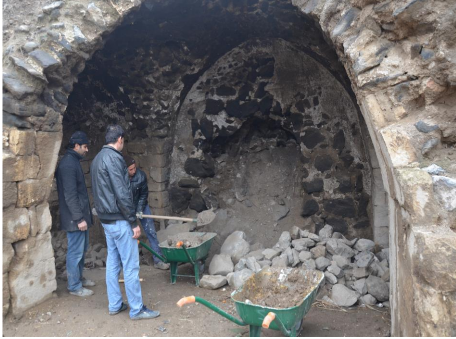
Resim 58: Mor Kuryakos Manastırı'ndaki iç avlu etrafında bulunan kemerli yapıların altında biriken toprak dolgusu temizliği (2015-2016).
