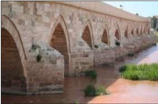
Resim 38: Sivas, Eğri Köprü .
