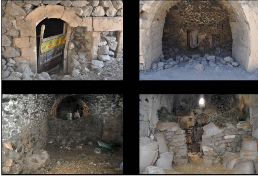
Resim 16: Mor Kuryakos Manastırındaki neflerin, odaların iç kısımları kerpiç ve taş malzeme ile bölümlere ayrılmış hali.
