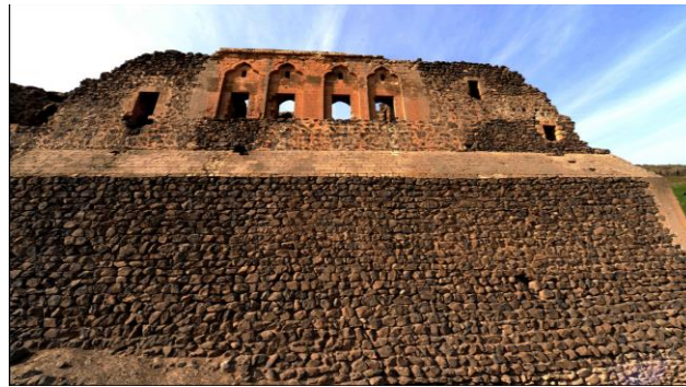
Resim 40: Batman, Mor Kuryakos Manastırı (Bazalt ve Mardin taşının bir arada kullanıldığı cephesinden görünüm)
