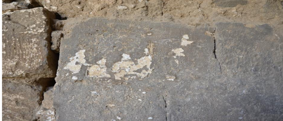
Resim 48: Tuz kaynağı olarak bozulmaya yol açan canlı organizma atıkları (Batman, Mor Kuryakos Manastırı batı revak).
