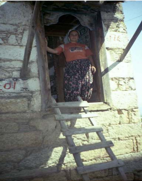
Resim 13. Evi dış tehlikelerden korumak amaçlı yapılmış yerden oldukça yüksek, giriş çıkışların seyyar bir merdivenle sağlandığı taş bir ev
