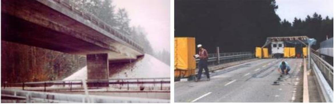
Şekil 2.74. Z24 Köprüsü'ne ait genel görüşler (Kramer vd., 2003)
