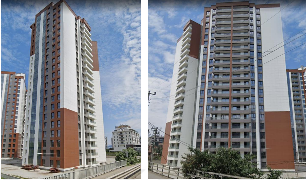
Şekil 2.92. Trabzon İli Yomra İlçesinde yer alan Çok Katlı Betonarme Bina'ya ait görsel
