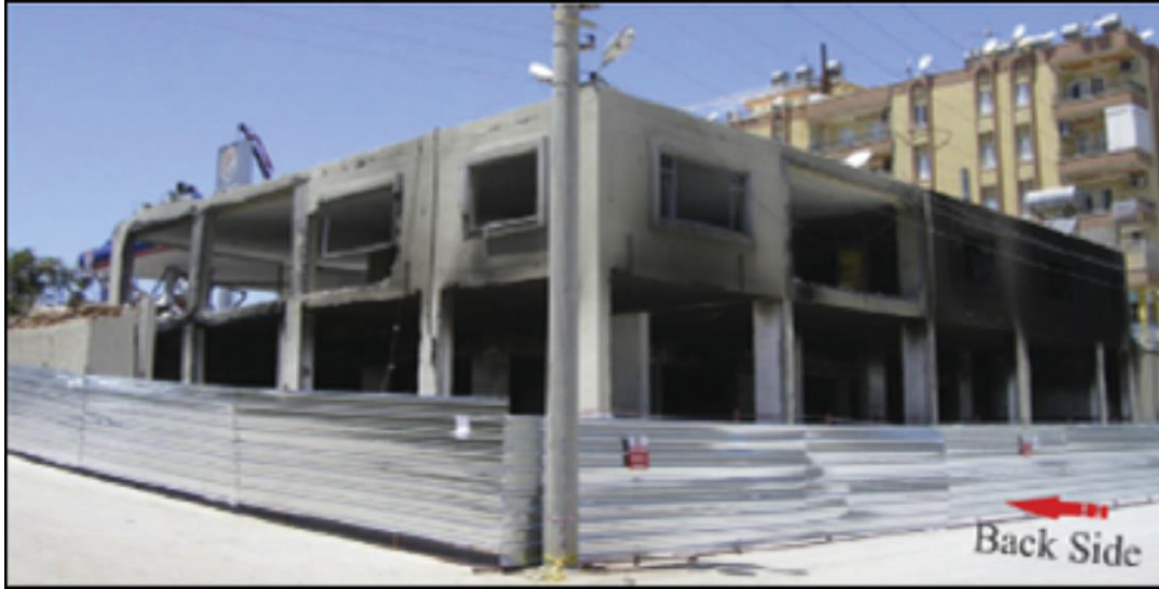
Resim 1.2. Yapının arka görünüşü
