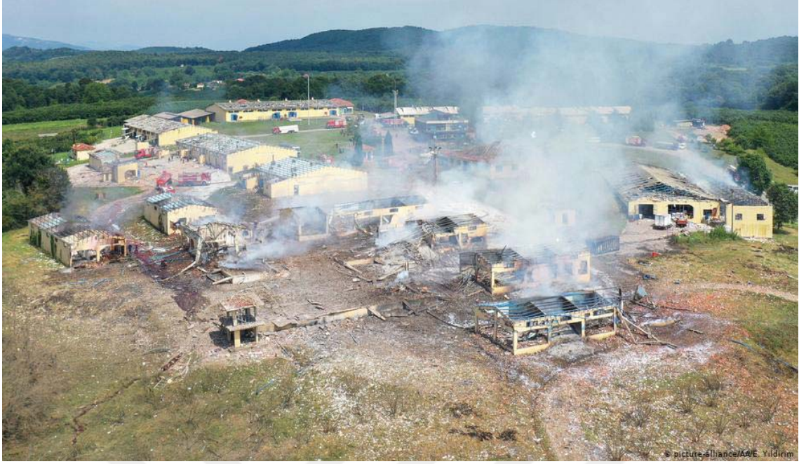
Resim 2.1. Sakarya havai fişek fabrikasında meydana gelen patlama [31]
