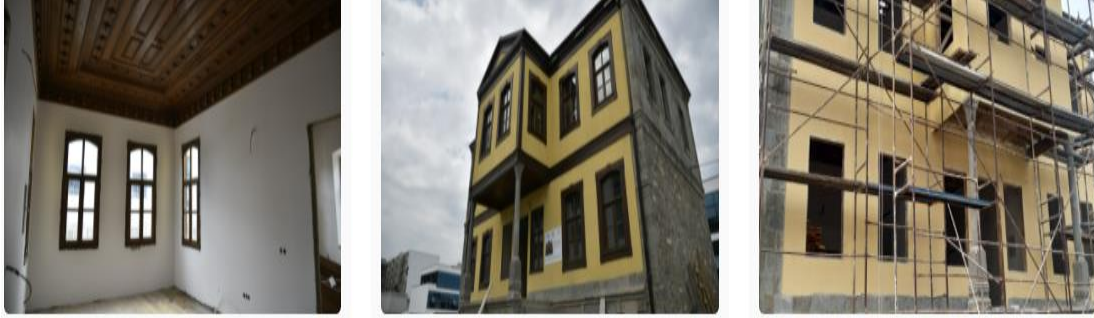
Şekil 21. Pazarkapı Tarihi Bina Restorasyonu (URL-27)
