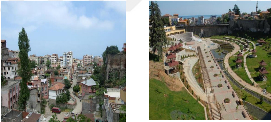
Şekil 13. Tabakhane KD Projesi Yenileme Öncesi ve Sonrası Görünümü (Akkaya, 2018)
