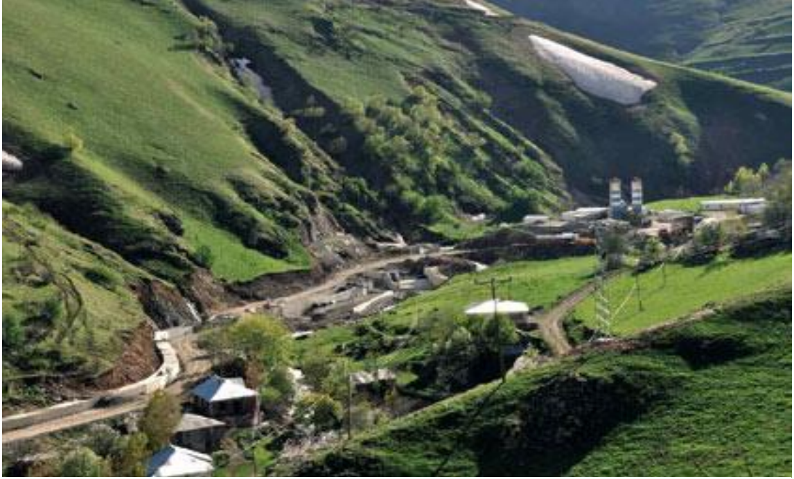
Resim 18: Bozkaya Barajı ve HES'inin yapılacağı bölge
