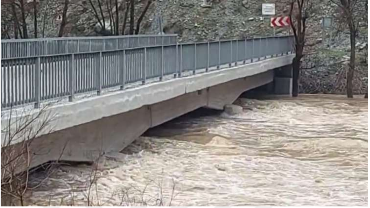
Şekil 5. Munzur Çayında Yaşanan Taşkın Afeti-2
